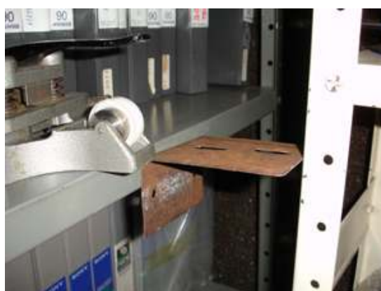
FIGURA 15: Detalhe da barra de ferro que sustenta a estante.
