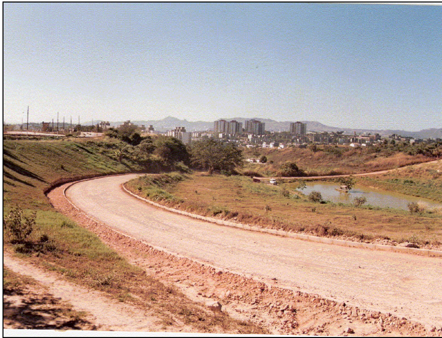
Foto 14 - Via interna (Bacia 3) ao fundo as edificações do Conjunto Califórnia - 1994
