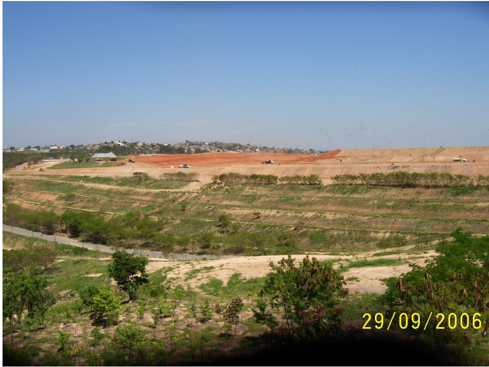
Foto 24 - Célula Emergencial – Via Perimetral – Vista atual / 2006
