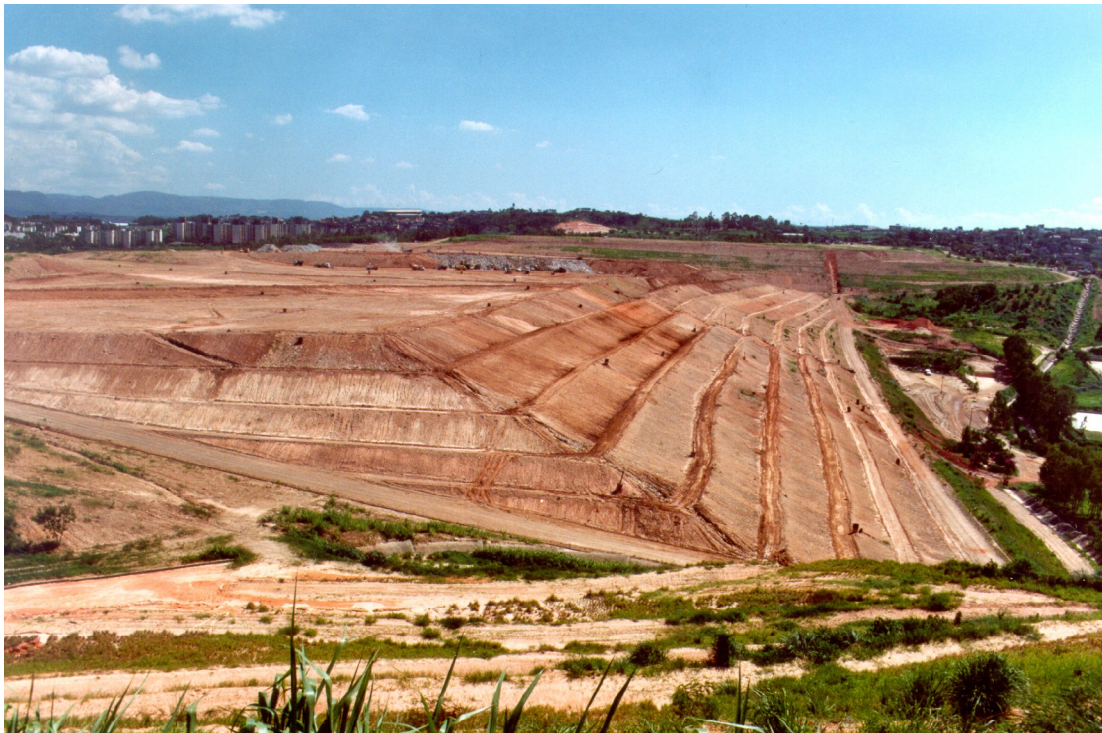
Foto 23 - Vista geral do Aterro / 2004
