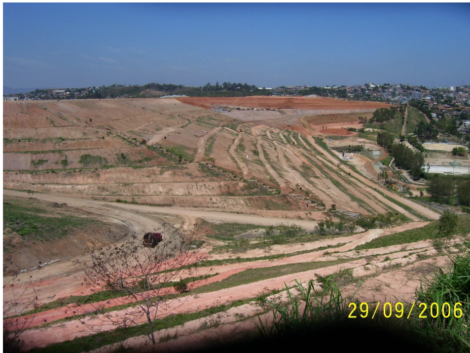
Foto 25 - Vista geral do Aterro / 2006
