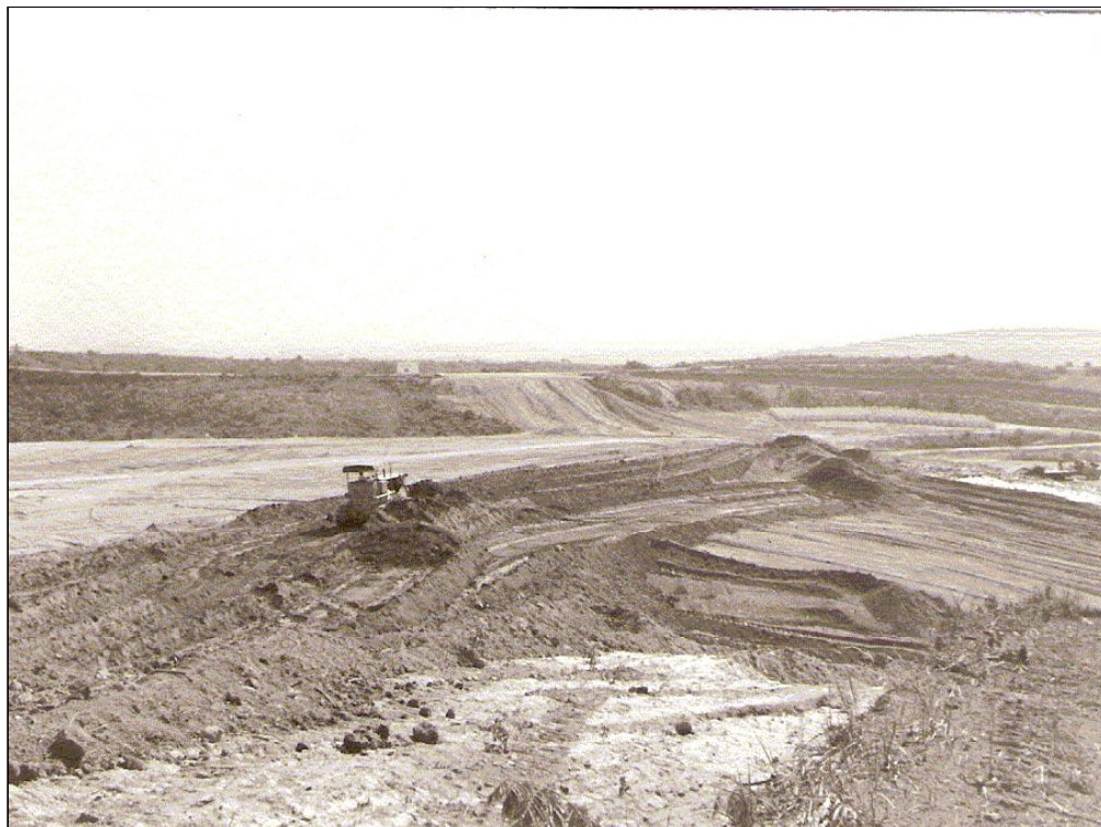
Foto 16 - Construção do Aterro / 1975
