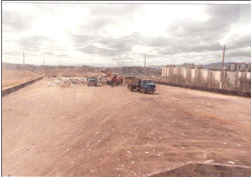
Foto 7 - Pátio de transbordo – desativado em 1995.
