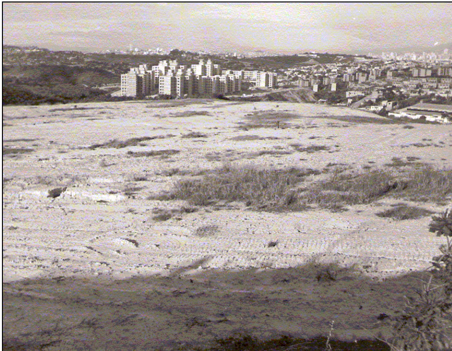
Foto 4 - Construção do Conjunto Califórnia II – 1976
