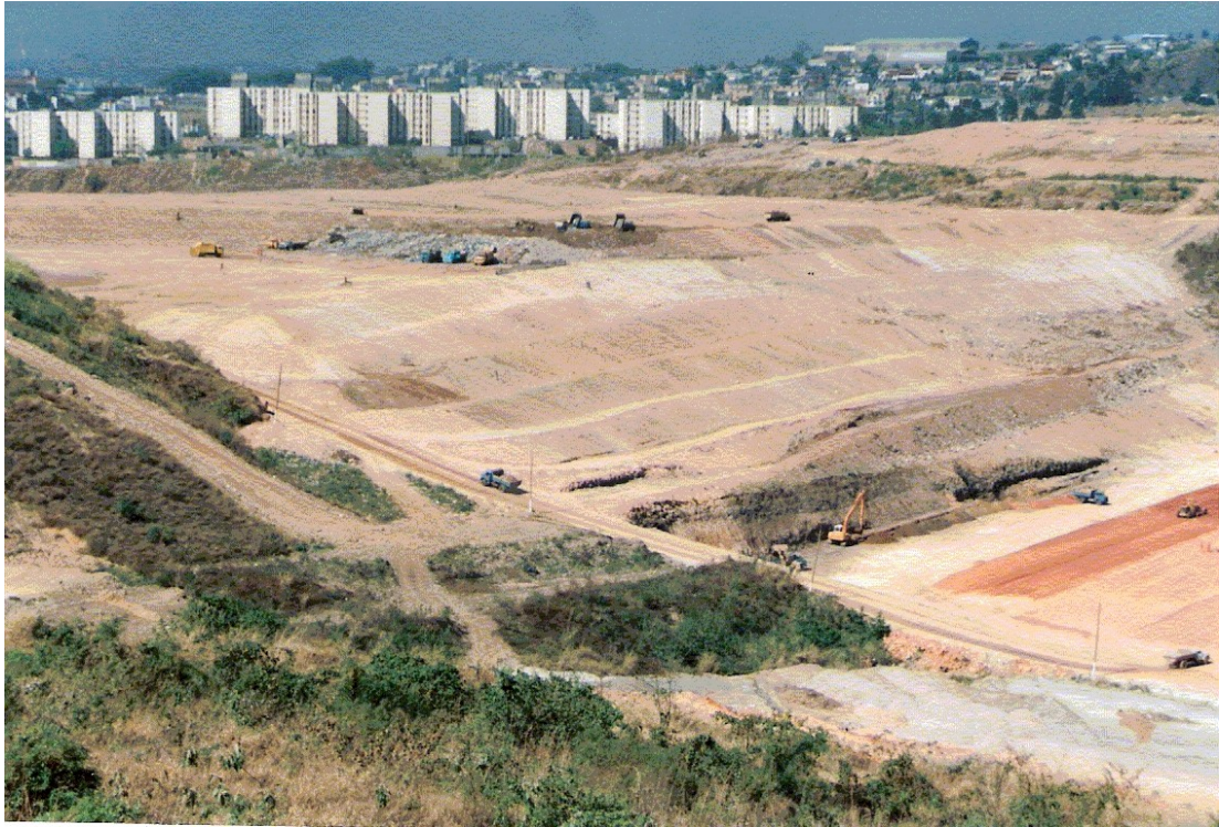
Foto 18 - Início da construção da célula 02 / 1995
