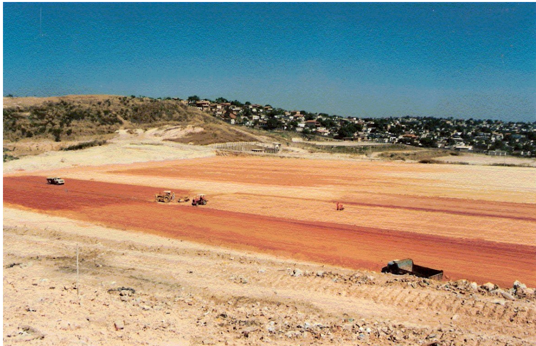
Foto 19 - Construção da célula 02 / 1995
