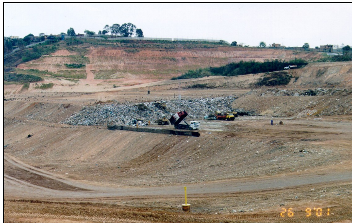
Foto 10 - Frente de aterro / 2001
