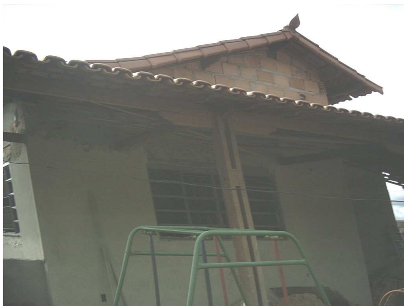
Figura 4 E – Caso 4, 2006, vista frontal. Observar detalhe da cobertura, com águas diferenciadas.
