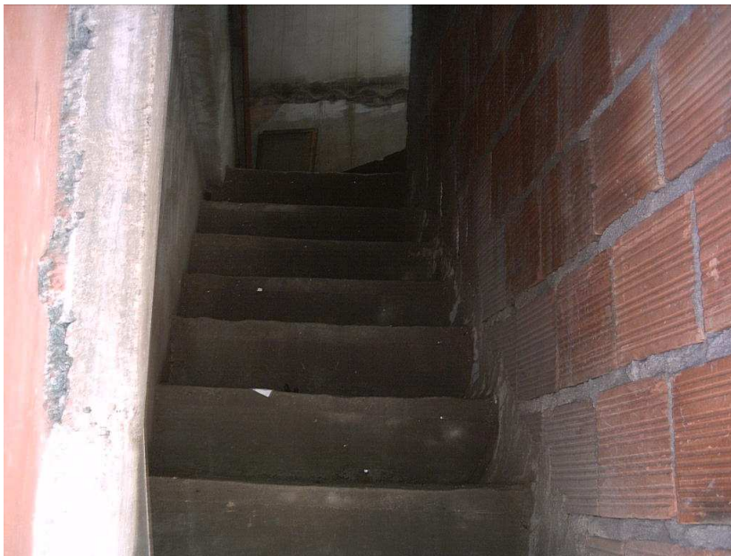
Figura 3.C – Caso 3, 2006, escada de acesso ao 2º pavimento. Como nos casos 1 e 2 os espelhos são desiguais.
