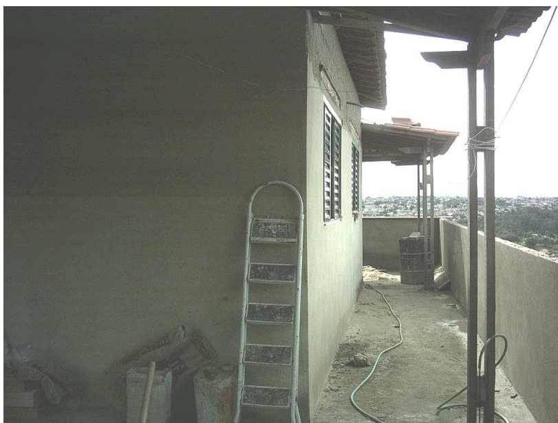
Figura 4 C – Caso 4, 2006, corredor lateral de acesso à área de serviço.
