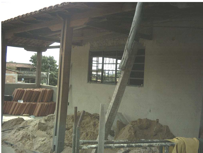
Figura 4 B – Caso 4, 2006, varanda frontal, já com as esquadrias instaladas e reboco executado.
