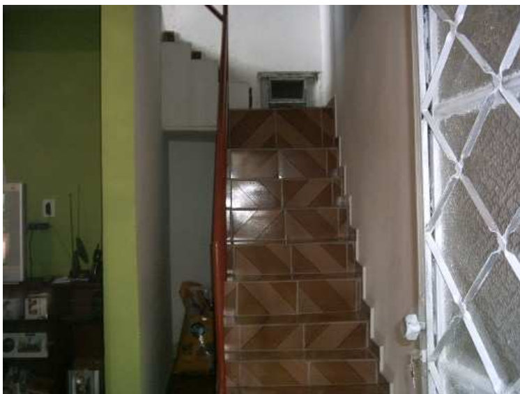
Figura 1 G – Caso 1, 2008: Escada de acesso ao 2º pavimento. O imóvel recebeu nova pintura .
