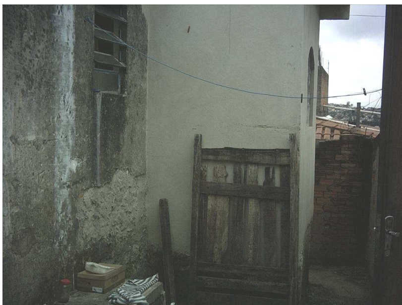
Figura 7 F – Caso 7: 2006, vista frontal, onde se pode observar o núcleo inicial da casa e a parte acrescida. O núcleo inicial apresenta-se deteriorado.
