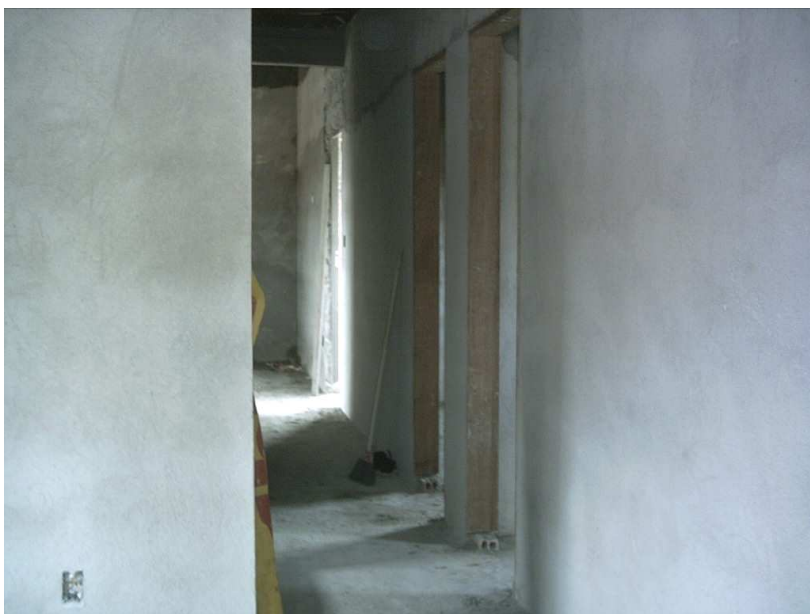
Figura 4 H – Caso 4, 2006, corredor de acesso aos quartos e banheiro.
