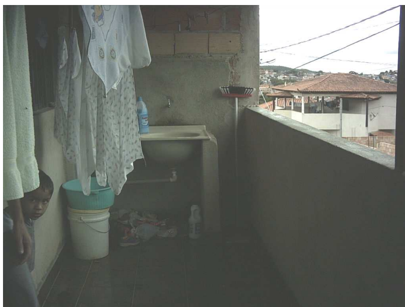
Figura 5 E – Caso 5- 2006: varanda frontal utilizada como área de serviço. Não foi executado revestimento cerâmico próximo ao tanque.
