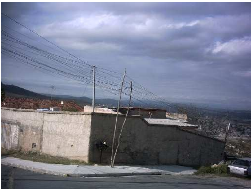
Figura 10 D – Caso 10: 2008, vista da casa, na qual pode-se observar as benfeitorias na malha viária realizadas na região. Também foi construída uma calçada.
