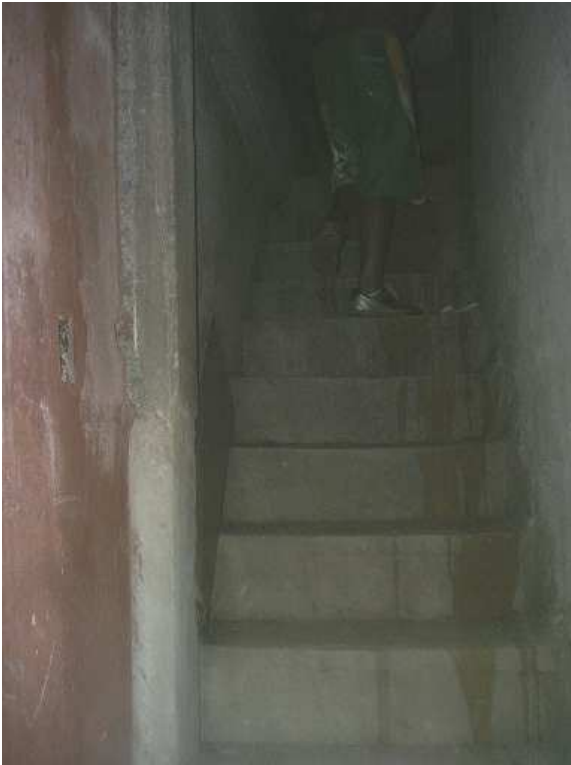
Figura 3 L – Caso 3, 2008, foi executado reboco nas alvenarias e piso na escada de acesso ao 1º pavimento.
