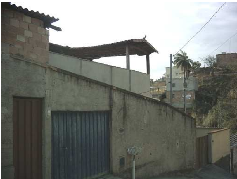
Figura 4 Q – Caso 4, 2008, vista frontal, podendo ser observada a cobertura da escada de acesso que foi refeita devido à deformação da estrutura em madeira. Observar também alta declividade do entorno.
