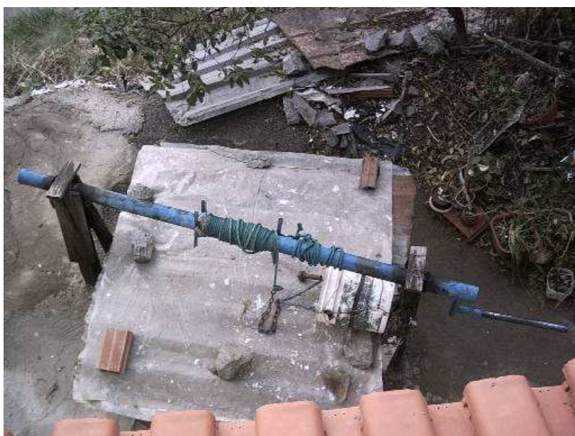
Figura 8 J – Caso 8: 2008, cisterna construída na ocasião da compra do terreno, de forma a suprir ausência de infra-estrutura e ainda utilizada pelos moradores.
