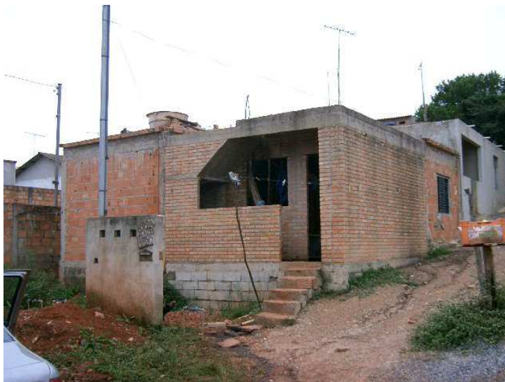
Figura 2 E – Caso 2, 2008, vista geral da esquina. O novo volume da sala, com varanda e acesso ao 2º pavimento, foi executado em alvenaria de tijolos (não mais de blocos) e com mão-de-obra contratada (não mais em mutirão), o que se reflete na qualidade da execução. Foram acrescentadas também esquadrias nas janelas. Já a urbanização não sofreu melhorias.
