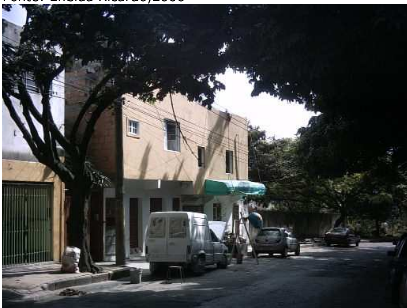
Figura 3 H– Caso 3, 2008, fachada frontal já rebocada e pintada. A fachada lateral permanece sem revestimento.
