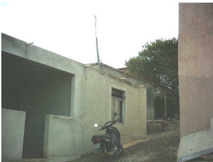
Figura 11 C- Caso 11: 2008, imóvel com o acréscimo feito em 2007. Observar presença de buzínates.
