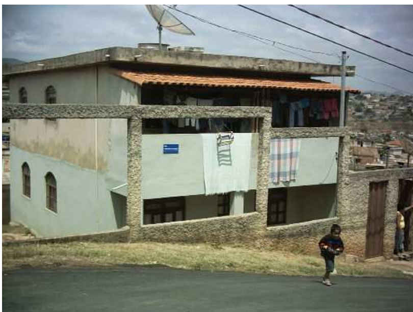
Figura 5 I – Caso 5- 2008: fachada frontal, sendo que a rua que era em terra quando da vistoria em 2006 recebeu pavimentação asfáltica este ano.
