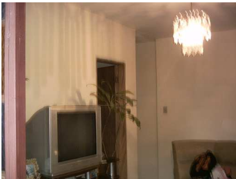
Figura 6 F – Caso 6, 2008: sala, porta de acesso ao quarto de casal e circulação de acesso ao banheiro. O reboco foi bem executado e o imóvel não apresenta infiltrações nem nas alvenarias nem na laje de cobertura. Não foram instalados alisares nas portas.
