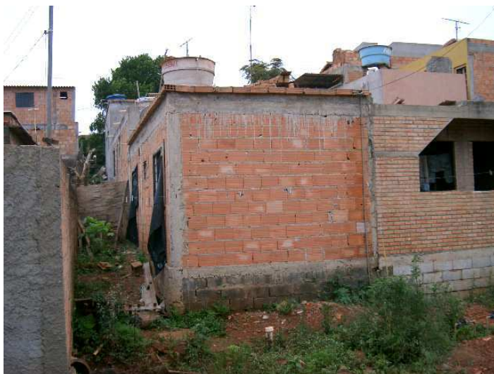
Figura 2 F – Caso 2, 2008, vista a partir de uma das ruas. O afastamento lateral para iluminação e ventilação foi preservado. Observa-se a inexistência de vidros nas esquadrias, protegidas por lonas plásticas.
