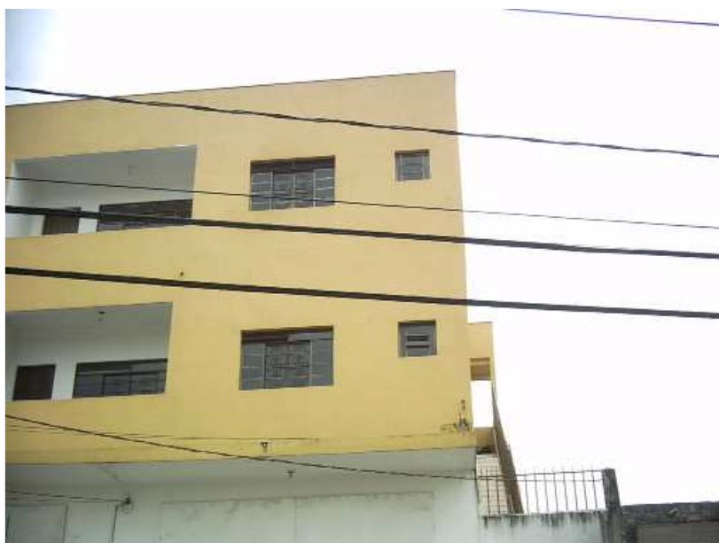
Figura 9 D - Caso 9: 2008, os apartamentos localizados no 2º pavimento foram concluídos.
