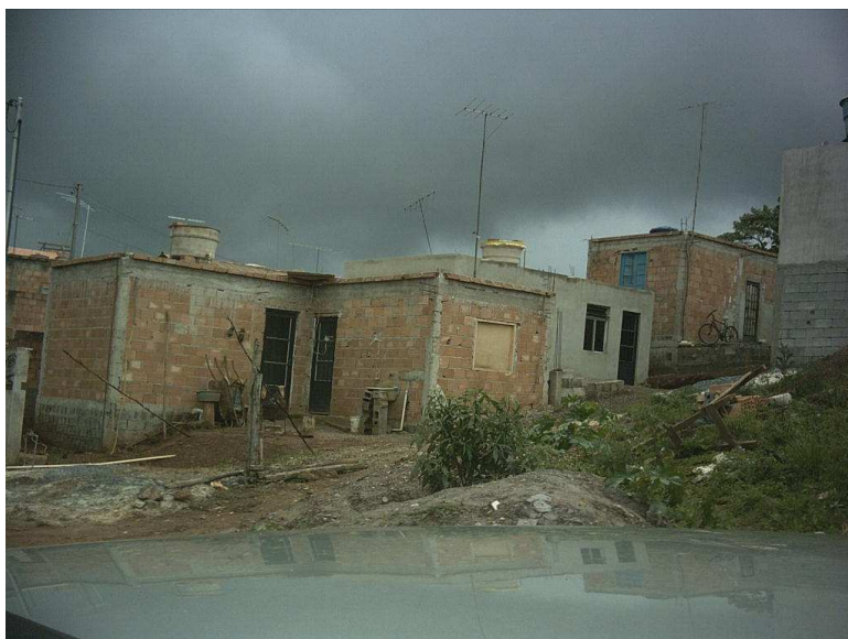
Figura 11 B- Caso 11: 2006, observar núcleo inicial do imóvel construído em 2005.
