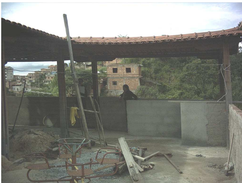
Figura 4 G – Caso 4, 2006, cobertura da escada de acesso. Observar deformação do telhado. Observar também característica de ocupação do entorno e declividades.
