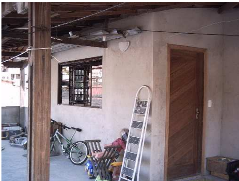
Figura 4 J – Caso 4, 2008, varanda frontal, ainda sem pintura.
