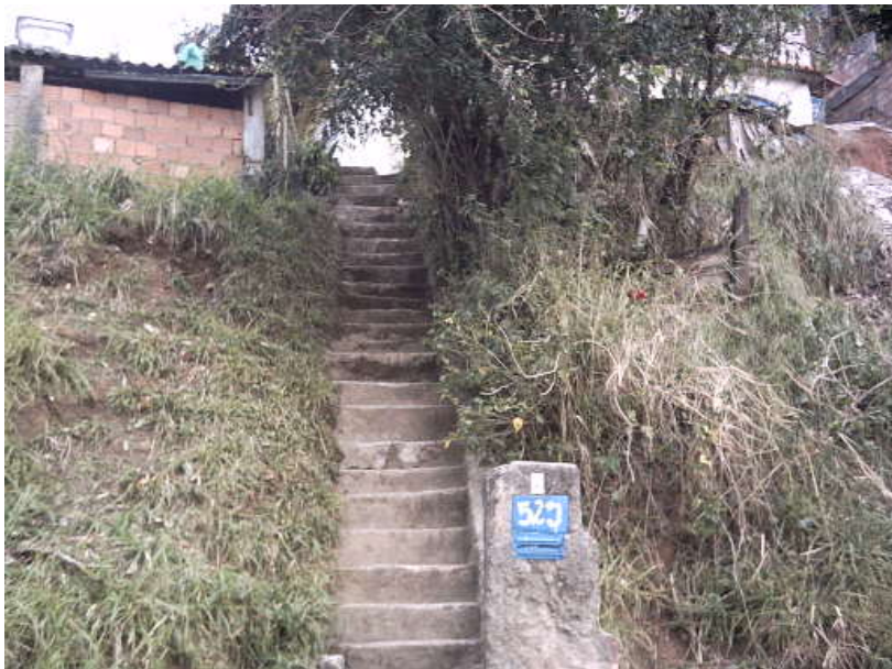
Figura 8 L- Caso 8: 2008, escada de acesso à casa, como já citado, muito desconfortável: não possui patamares intermediários ou corrimão, os pisos são estreitos e os espelhos apresentam alturas diferentes.
