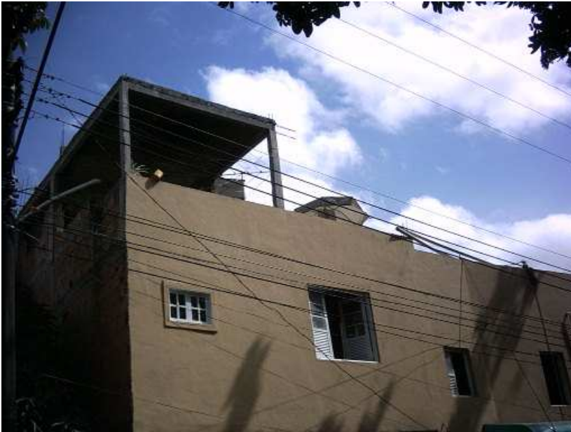
Figura 3 I – Caso 3, 2006, fachada frontal e cobertura em laje com estrutura de concreto armado acrescida no 3º pavimento.
