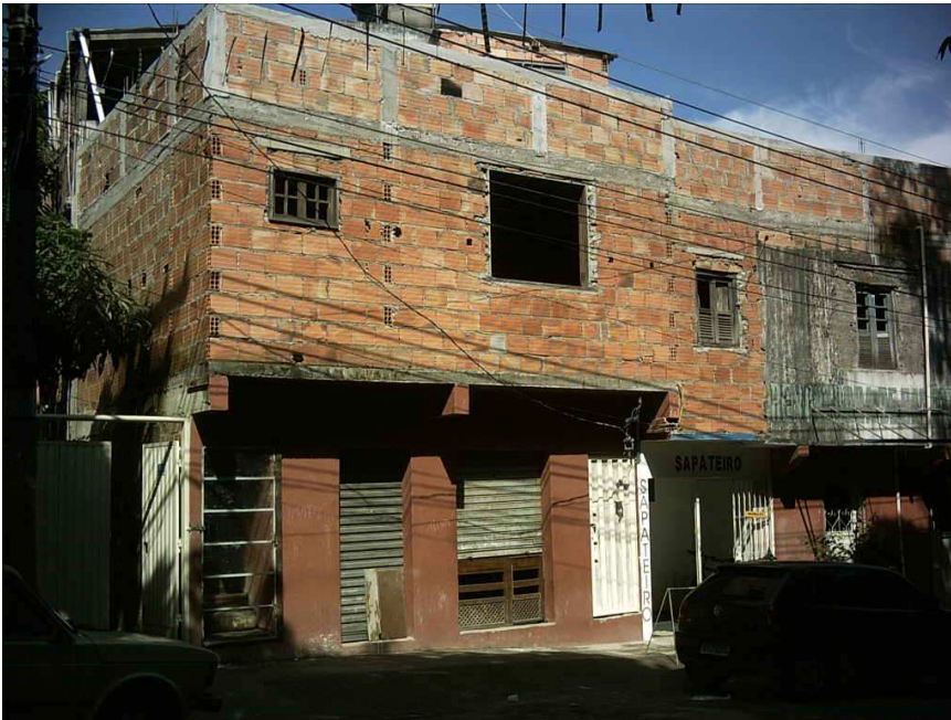
Figura 3 B – Caso 3, 2006, fachada frontal onde se pode observar a obra realizada com os recursos do financiamento: construção de parte do 2º pavimento e 02 lojas no térreo, escadas de acesso e guarda corpo do terraço. A construção foi feita com estrutura de concreto e alvenarias de blocos cerâmicos.
