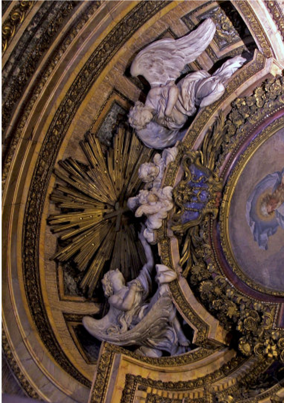
Figura 29 – Cimo central interior da Capela de São João Batista
