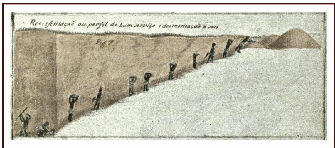
Fig. 16 – Representação ou perfil de hum serviço e desmontação a seco. José Manuel de Sequeira, 1802.
