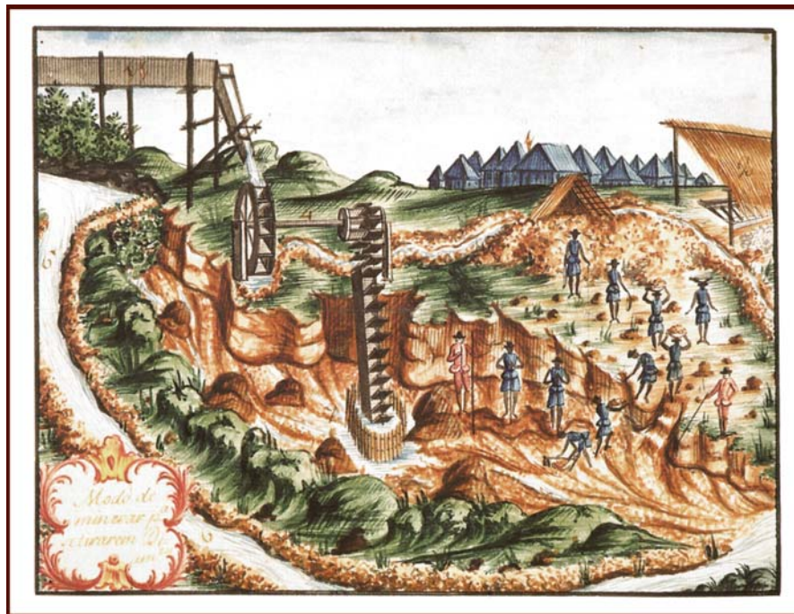
Fig. 10 – Modo de minar p a se tirarem Diam tes . Autoria não identificada. Minas Gerais, século XVIII.
