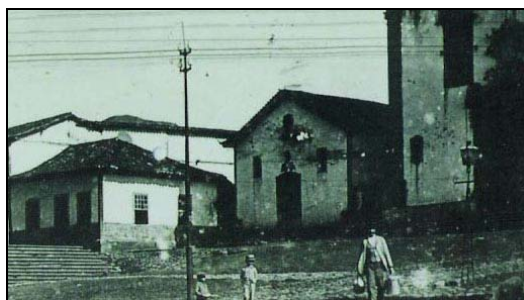
FIG. 6 – Rede elétrica - detalhe da FIG.5. Fonte: Acervo particular de Márcio Marezza.
