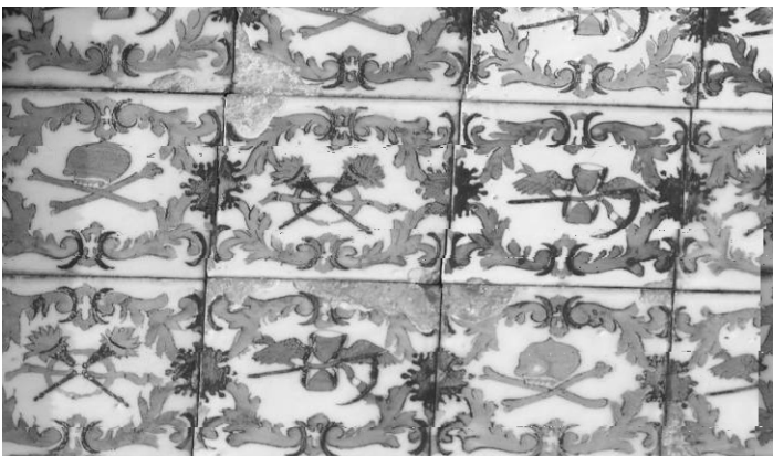
Jazigo 116, 8ª seção municipal, revestimento externo de azulejos com motivos escatológicos: a caveira com as tíbias cruzadas, a ampulheta e a foice, as tochas e a serpente mordendo o próprio rabo. Cemitério do Prado do Repouso, Porto.
