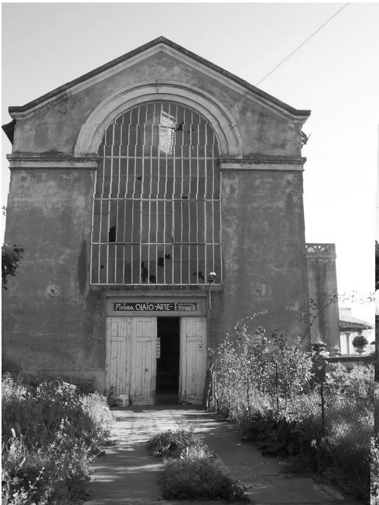
Prédio do ateliê dos irmãos Oliveira Ferreira, Miramar.
