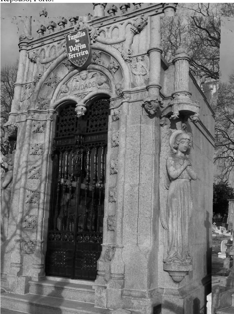
Capela-jazigo n.º. 2508, 36ª seção municipal. Granito e bronze. Obra realizada pelos irmãos Oliveira Ferreira, 1933. Cemitério do Prado do Repouso, Porto.
