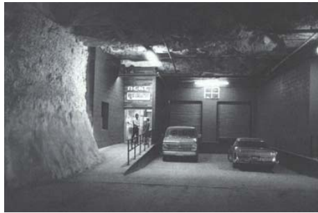
FIG. 28 – Galpão de entrada e carregamento com instalações de alta segurança em Kansas, construída entre pilares de pedra calcária deixados pelas operações de mineração para suportar o teto da mina.
