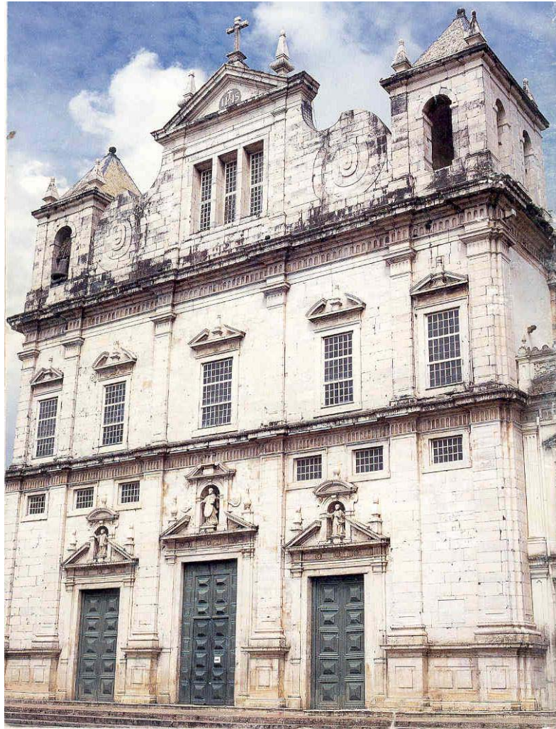
FIGURA 3- Fachada da Catedral Basílica de Salvador, no Terreiro de Jesus.
