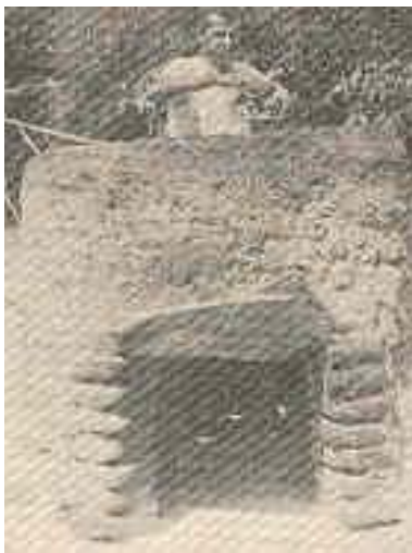
FIGURA 17 a e b- Detalhe de fornos populares, similares aos usados na Bahia colonial. Notar a construção simplificada e o uso de cacos de cerâmica para isolar as chamas das peças durante a queima. Esse cuidado reduz as manchas causadas pela combustão de matéria orgânica. Fonte: BRANDÃO, J., 1962, p.65, 66.
