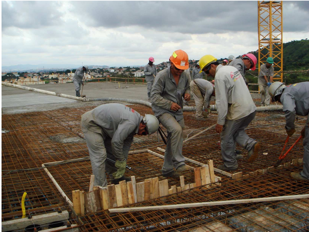
Figura 3.16: Vigas transversais – bainha dos cabos de protensão
