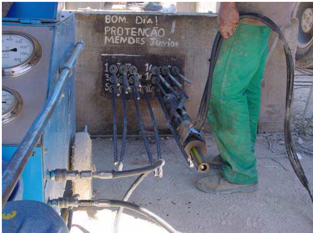
Figura 2.19: Bomba e macaco de protensão
