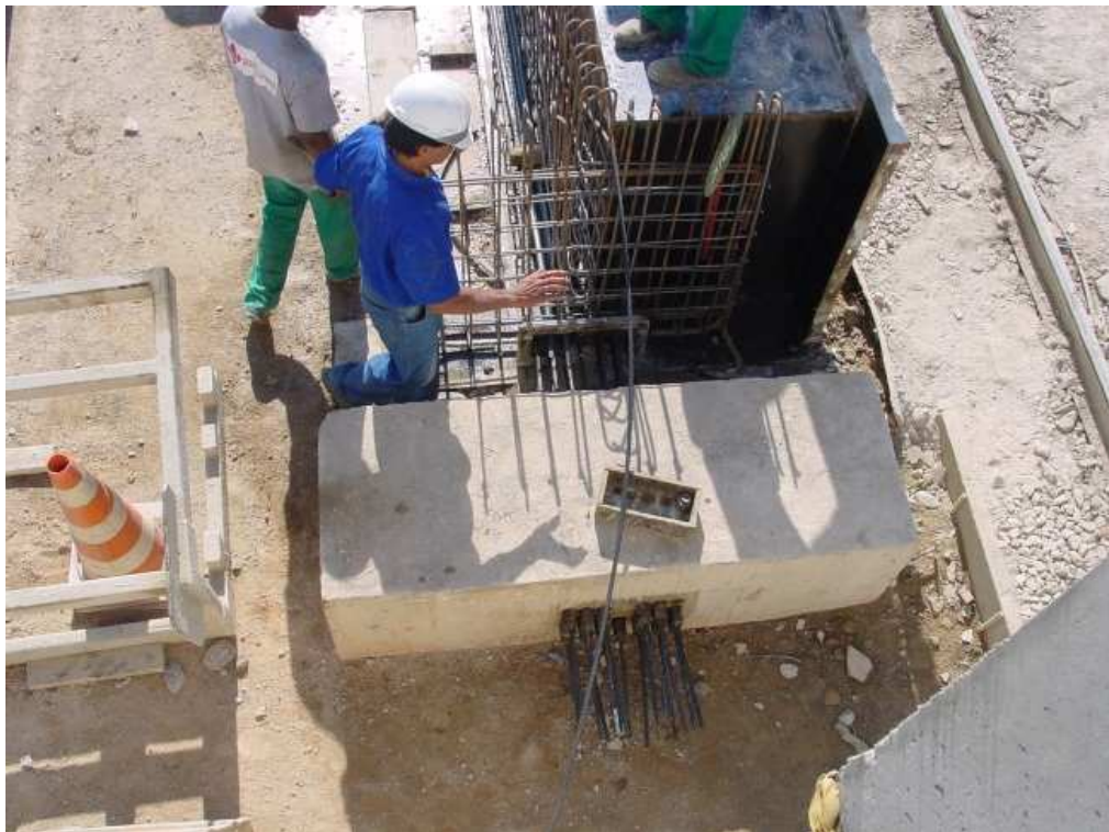
Figura 2.15: Cabeça de ancoragem da bancada de protensão
