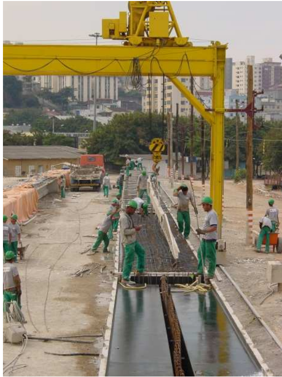
Figura 2.18: Fechamento da forma e colocação da armadura da mesa superior
