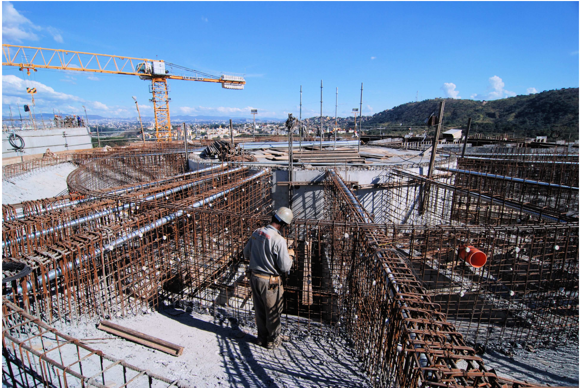
Figura 3.52: Heliporto – bainhas dos cabos de protensão das vigas radiais
