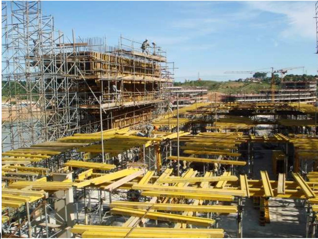
Figura 3.18: Estrutura metálica dos tirantes – cimbramento das lajes
