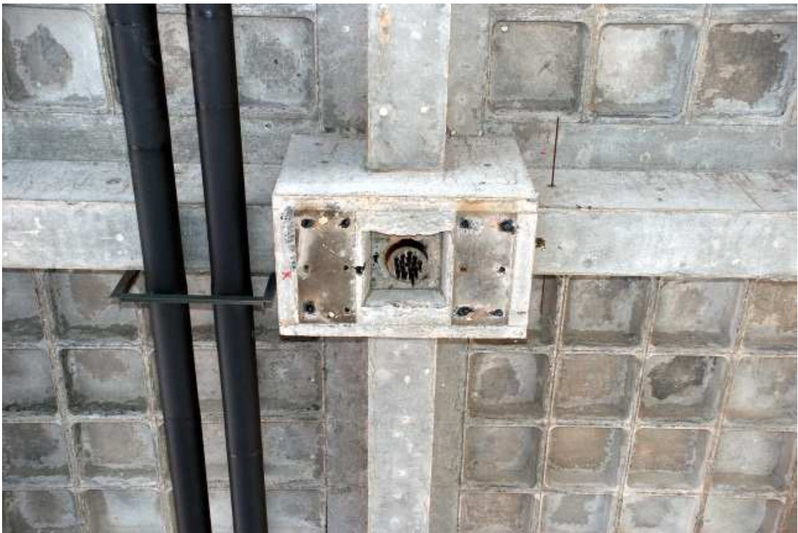
Figura 3.56: Ancoragem do tirante após a retirada dos pilares provisórios
