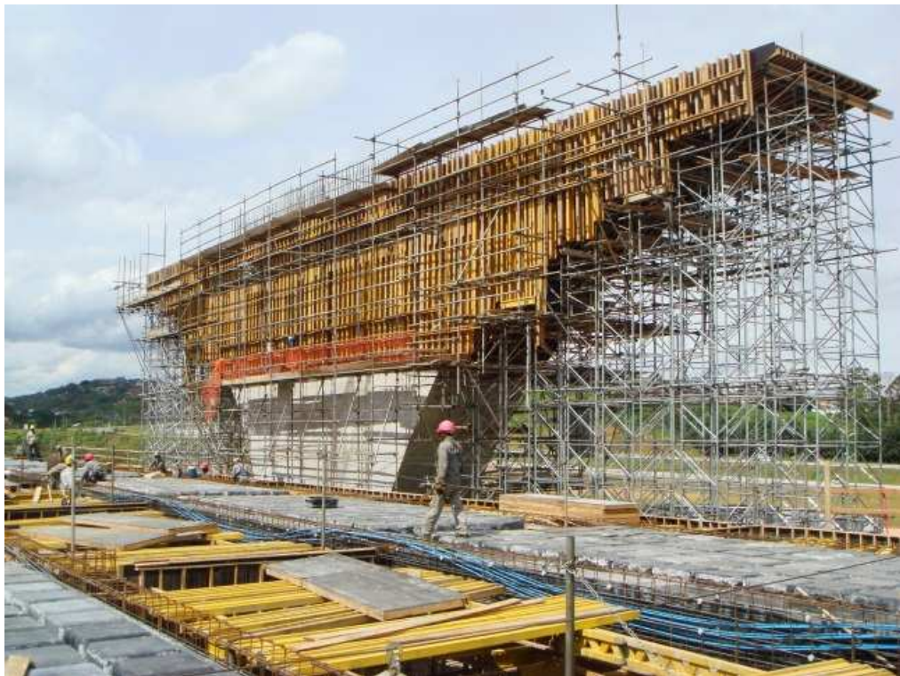
Figura 3.15: Vigas longitudinais – cordoalha engraxada plastificada
