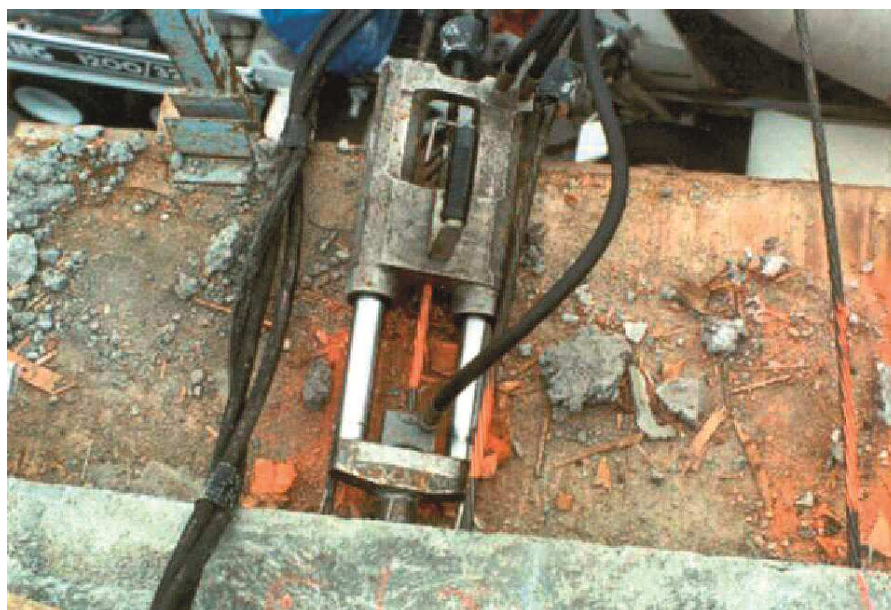
Figura 2.26: Macaco de protensão monocordoalha engraxada
