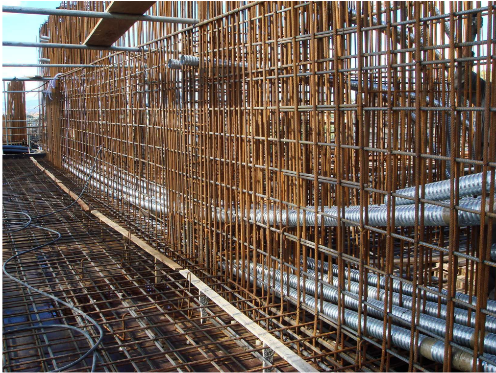
Figura 3.34: Vigas Longitudinais – Bainhas (Protensão)
