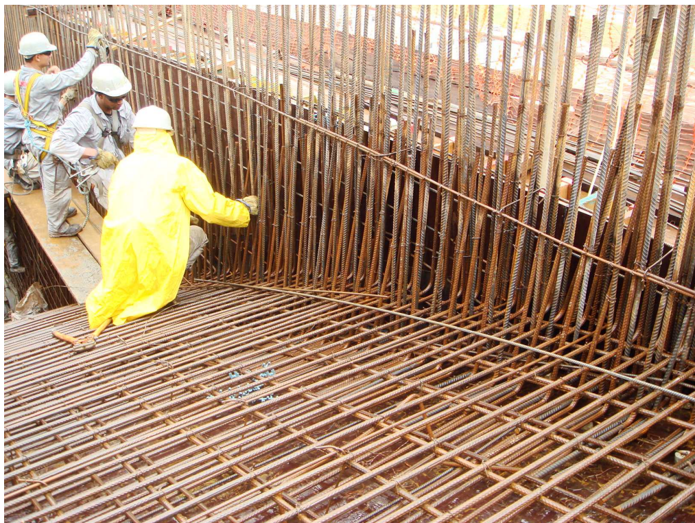
Figura 3.31: Pilares Pórtico - 8ª Etapa – Detalhe da Armação
