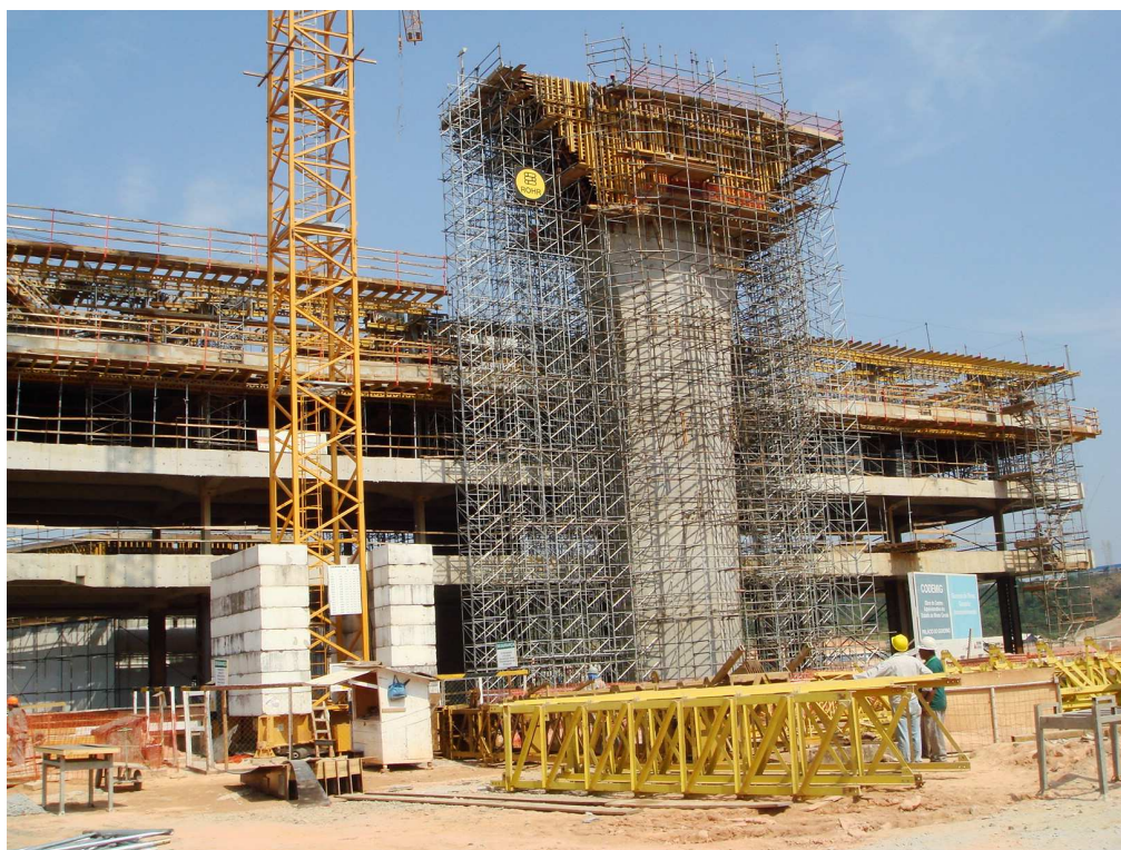
Figura 3.26: Pilares Pórtico - 7ª Etapa
