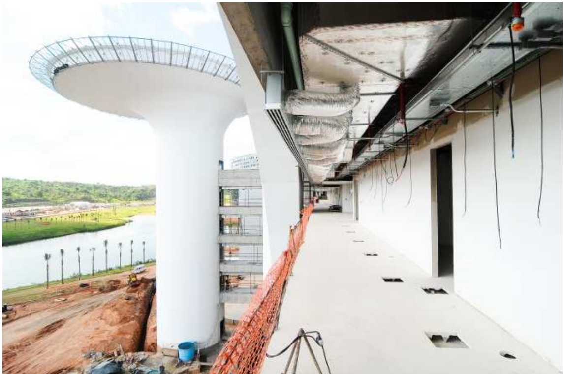
Figura 3.46: Passarela de interligação Heliponto – pavimentos suspensos do edifício
