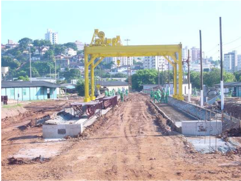
Figura 2.14: Bancada de protensão
