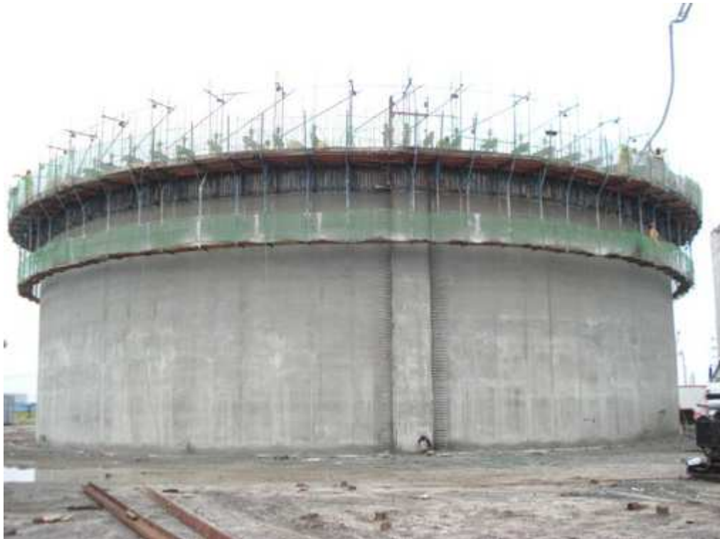
Figura 2.23: Silo em concreto protendido
