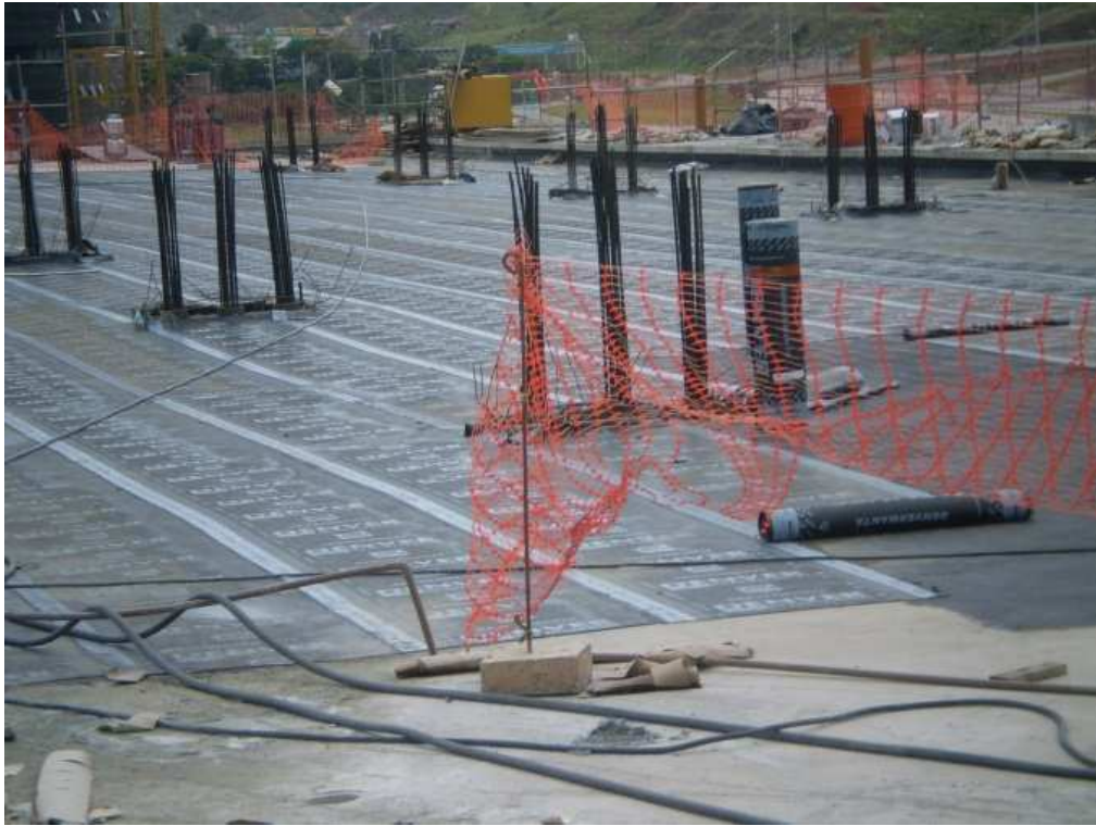
Figura 3.13: Tirantes – Cabos de cordoalha nua e ancoragens
