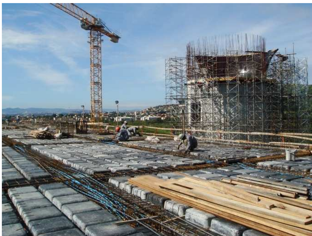
Figura 3.49: Heliponto - cimbramento e forma
