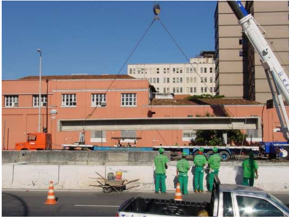
Figura 2.22: Transporte e montagem de vigas pré-moldadas
