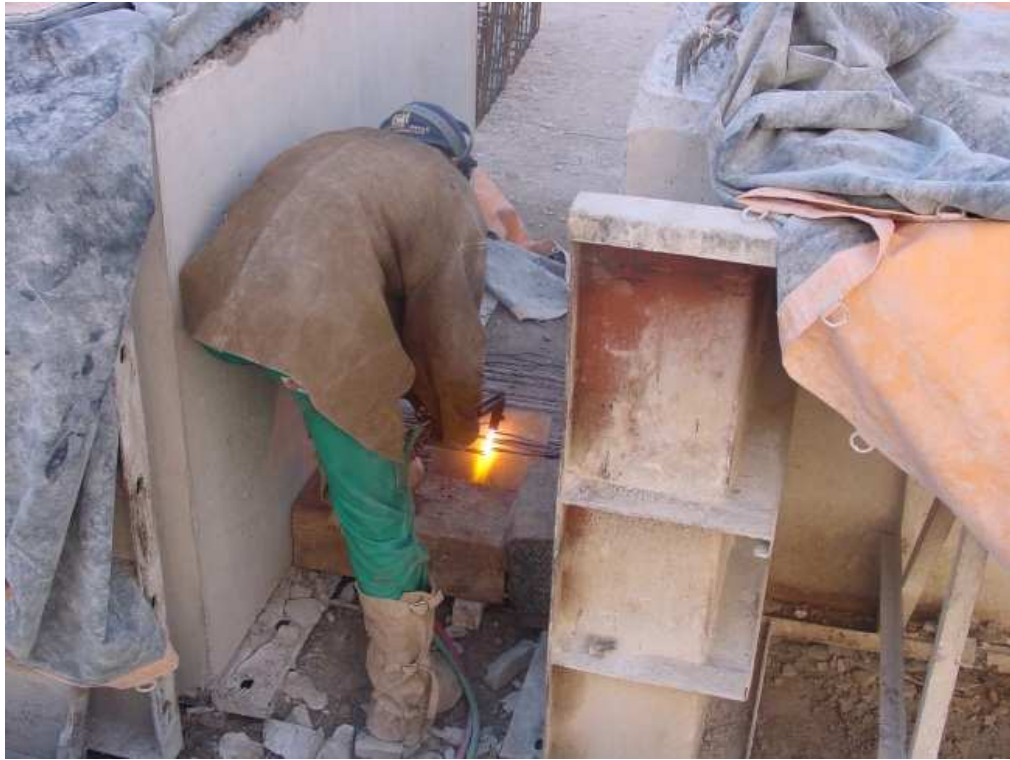
Figura 2.20: Corte das cordoalhas
