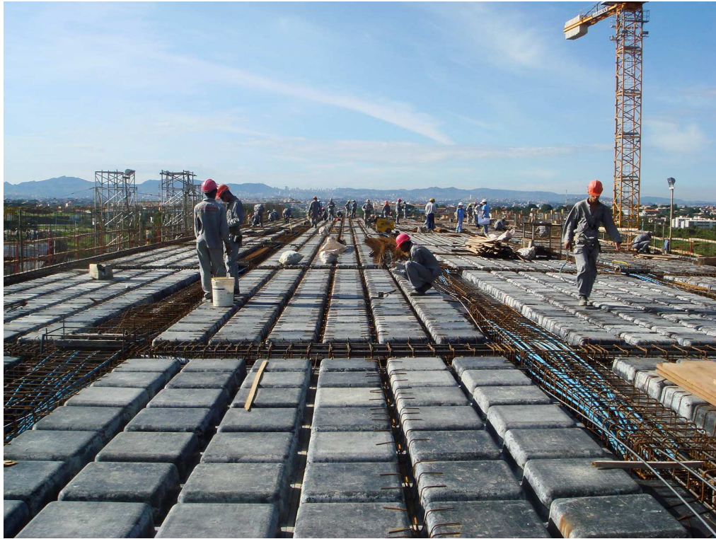
Figura 3.14: Vigas longitudinais – protensão em cordoalha engraxada encapada
