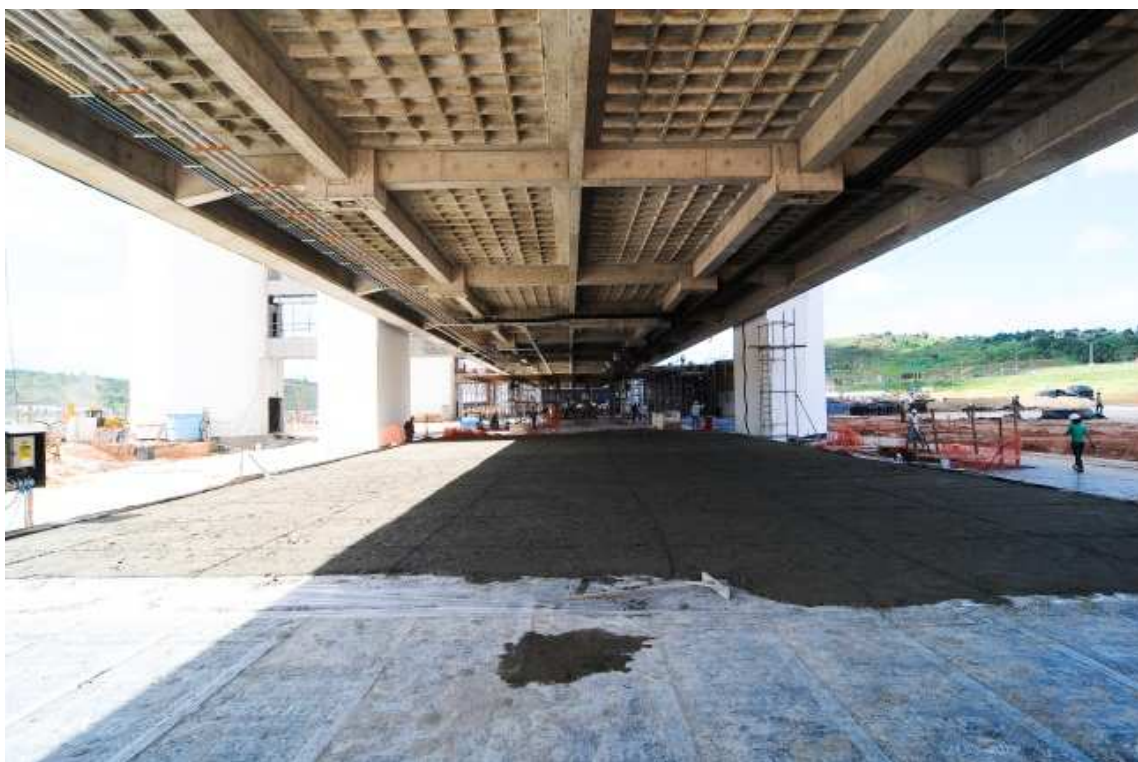
Figura 3.57: Pavimento térreo após a retirada dos pilares provisórios
