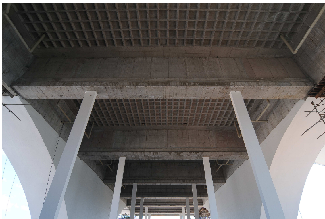
Figura 3.42: Vigas Transversais e laje de cobertura
