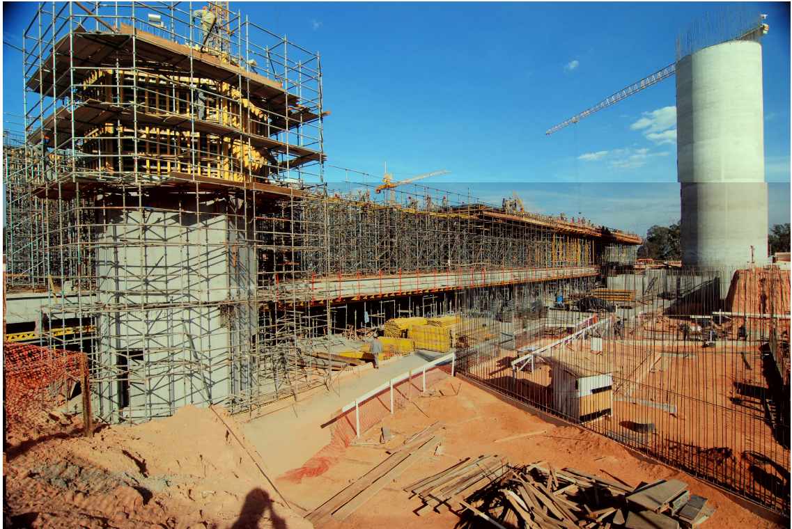
Figura 3.22: Pilares Pórtico - 3ª Etapa
