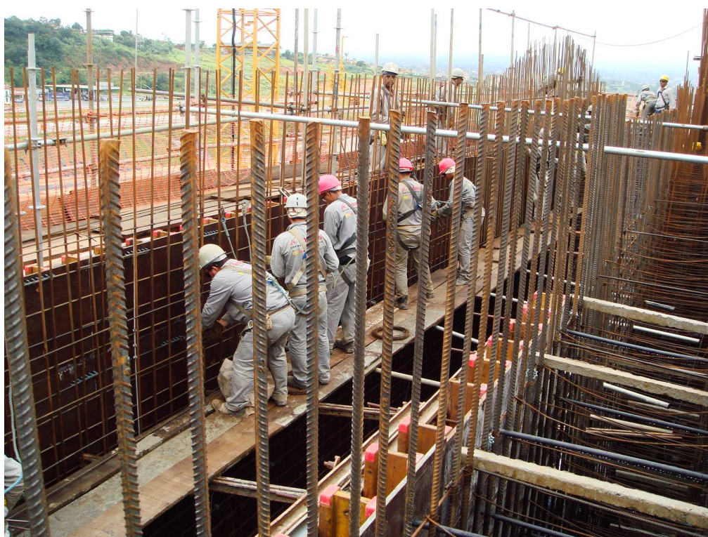
Figura 3.27: Pilares Pórtico - 7ª Etapa – Forma e Armação
