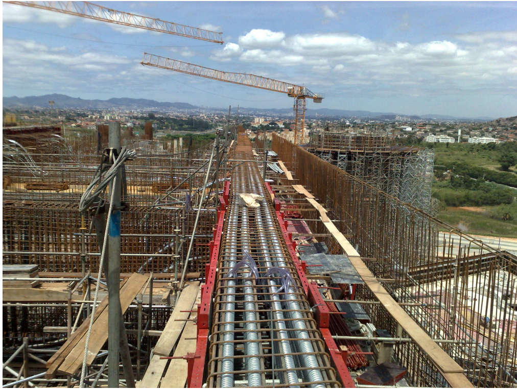
Figura 3.32: Vigas Longitudinais – Paredes Laterais
