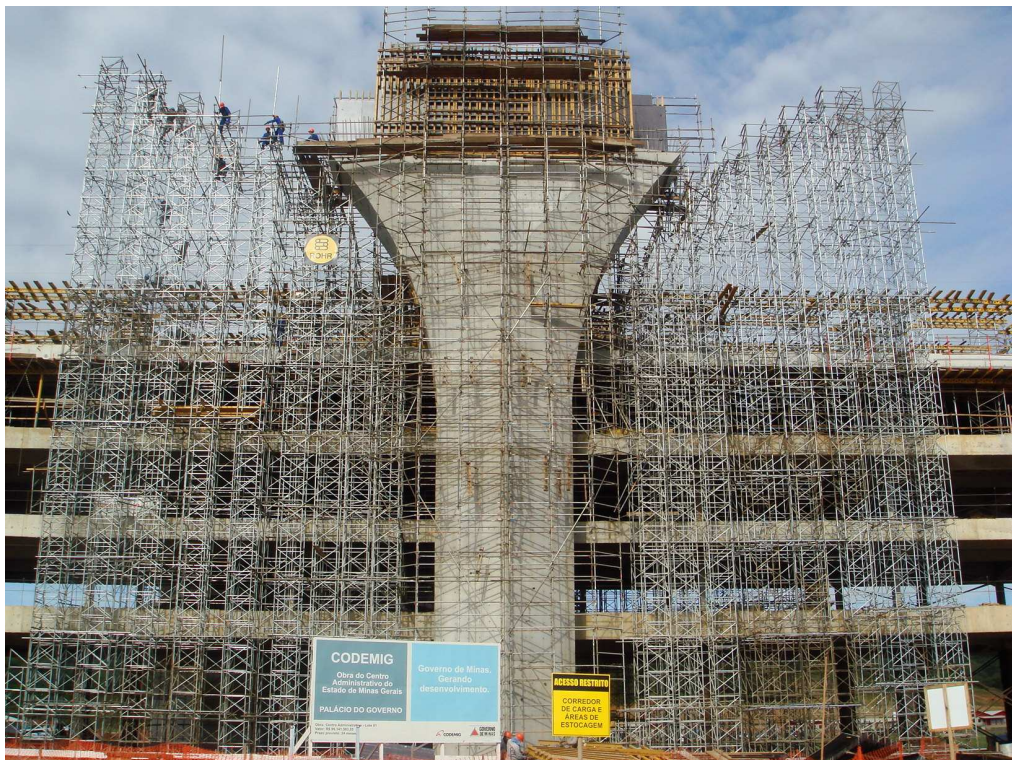
Figura 3.29: Pilares Pórtico - 8ª Etapa – Montagem de Cimbramento (altura = 37,5m)
