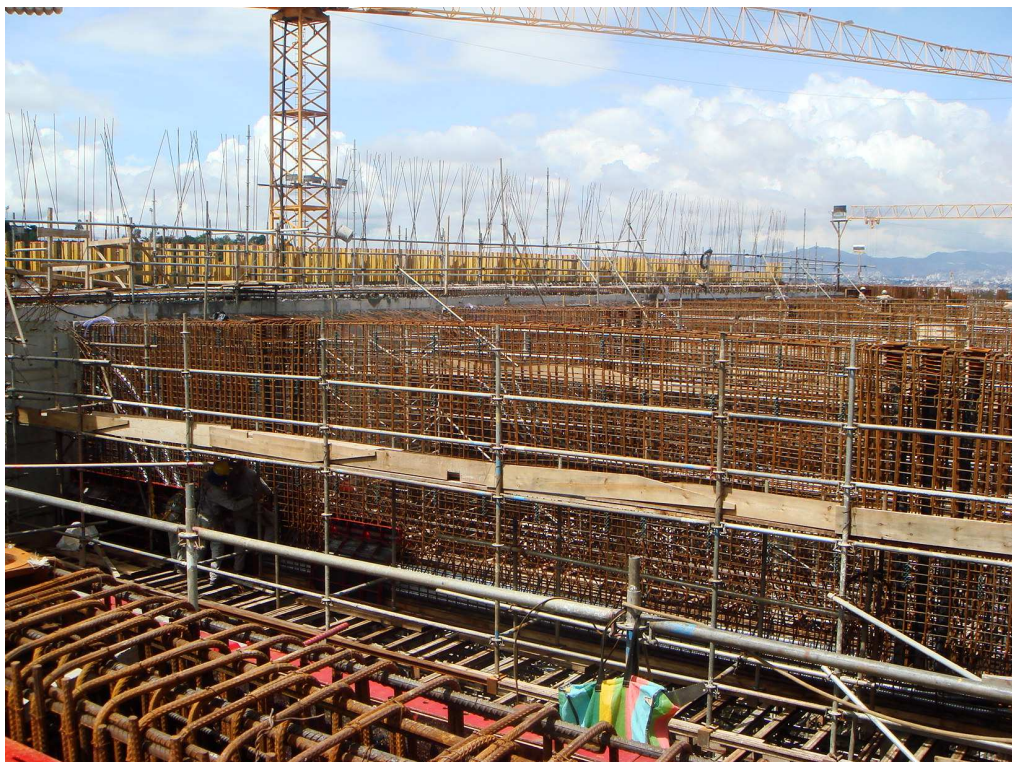
Figura 3.40: Vigas Transversais – Armação e Bainhas (Protensão)
