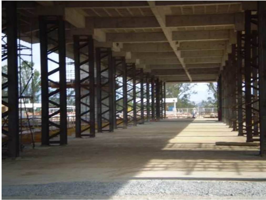
Figura 3.9: Pilares provisórios – pavimento térreo
