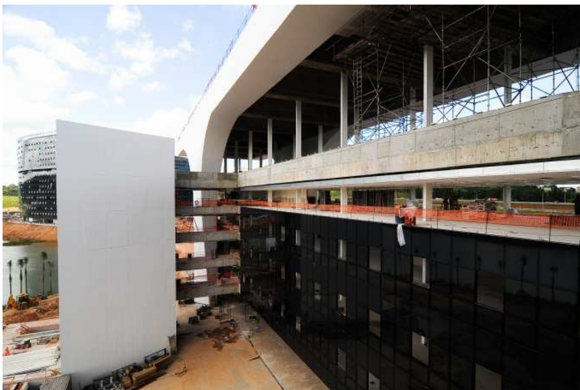
Figura 3.48: Passarela de interligação Circulação Vertical – pavimentos suspensos do edifício
