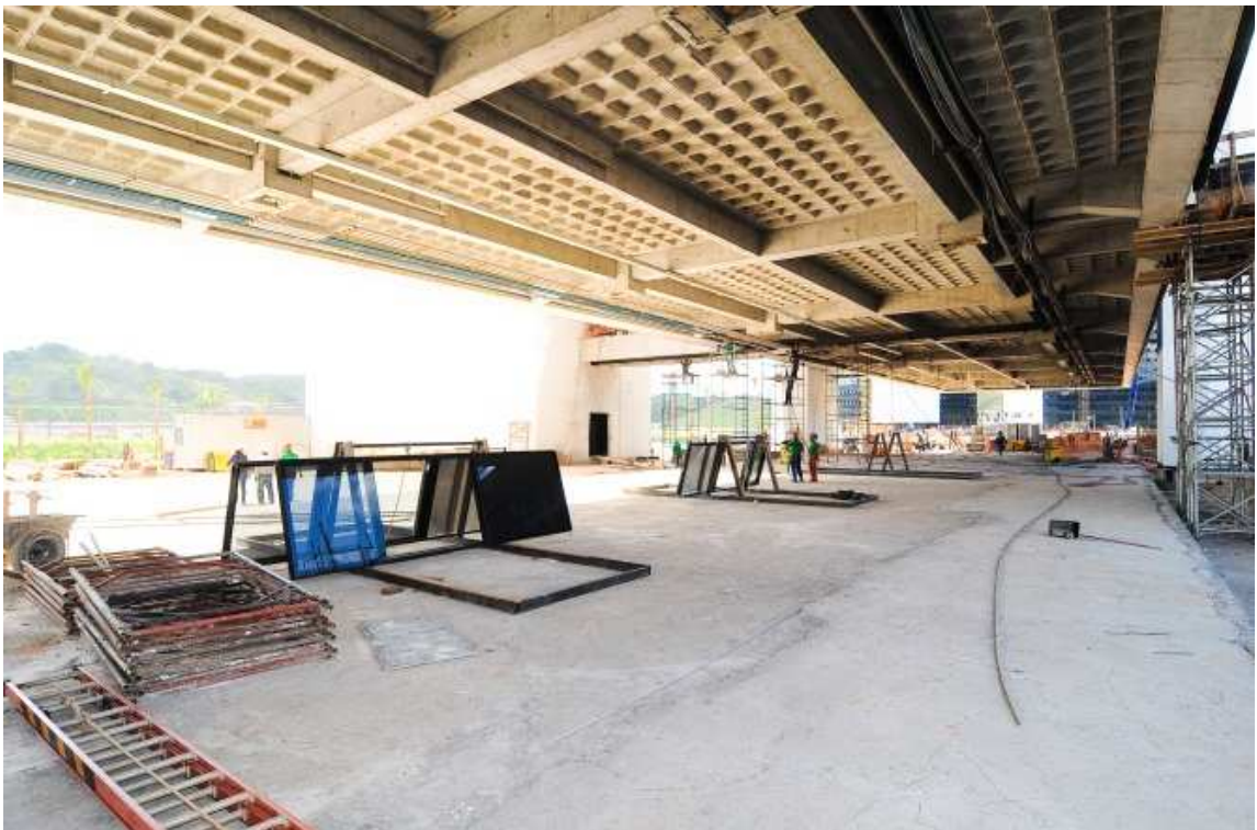
Figura 3.19: Laje térreo após retirada pilares provisórios
