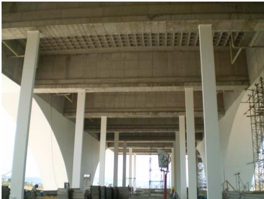
Figura 3.12: Estrutura metálica dos tirantes – pavimento técnico
