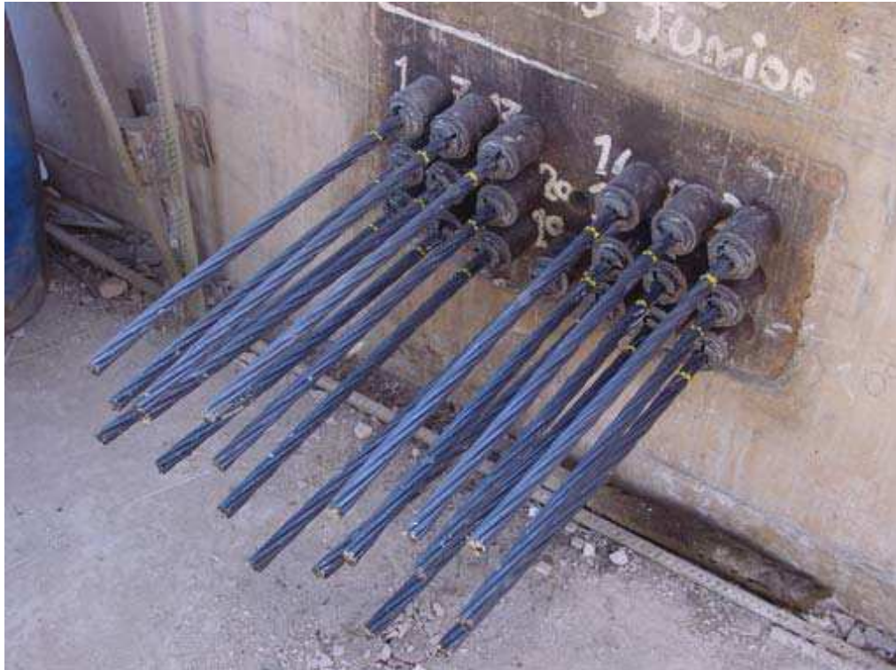
Figura 2.16: Ancoragens e cunhas de protensão
