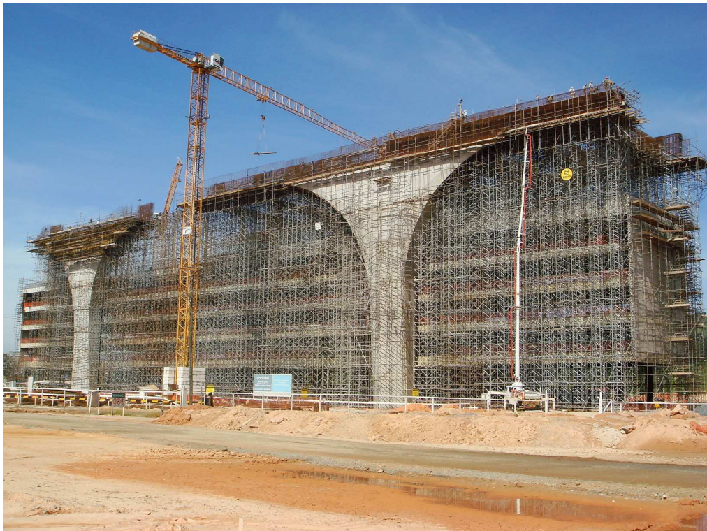
Figura 3.35: Vigas Longitudinais – Concretagem
