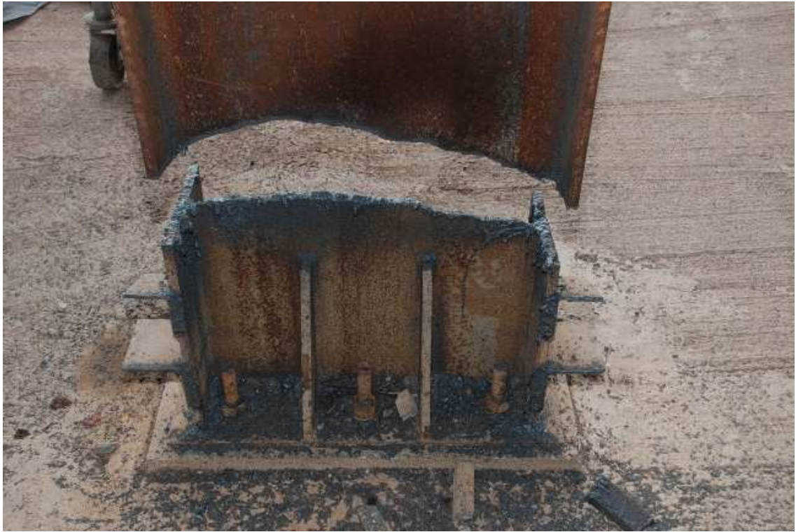
Figura 3.55: Corte pilares provisórios
