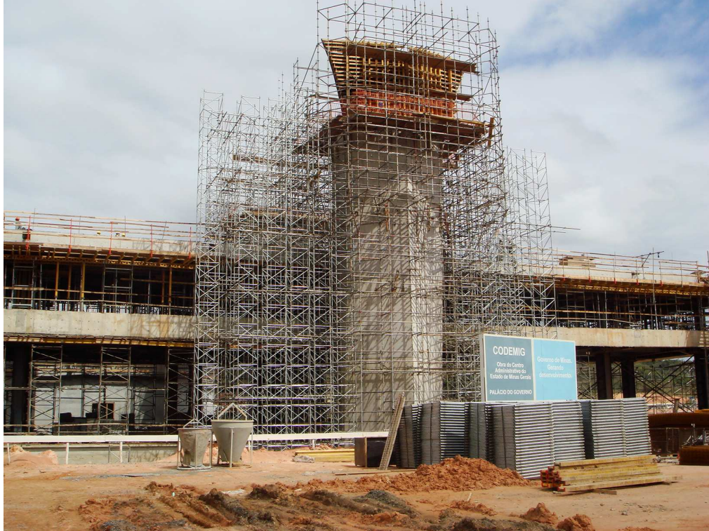
Figura 3.25: Pilares Pórtico - 6ª Etapa
