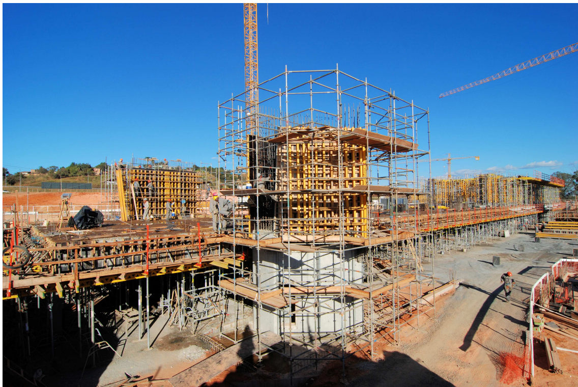
Figura 3.21: Pilares Pórtico - 2ª Etapa
