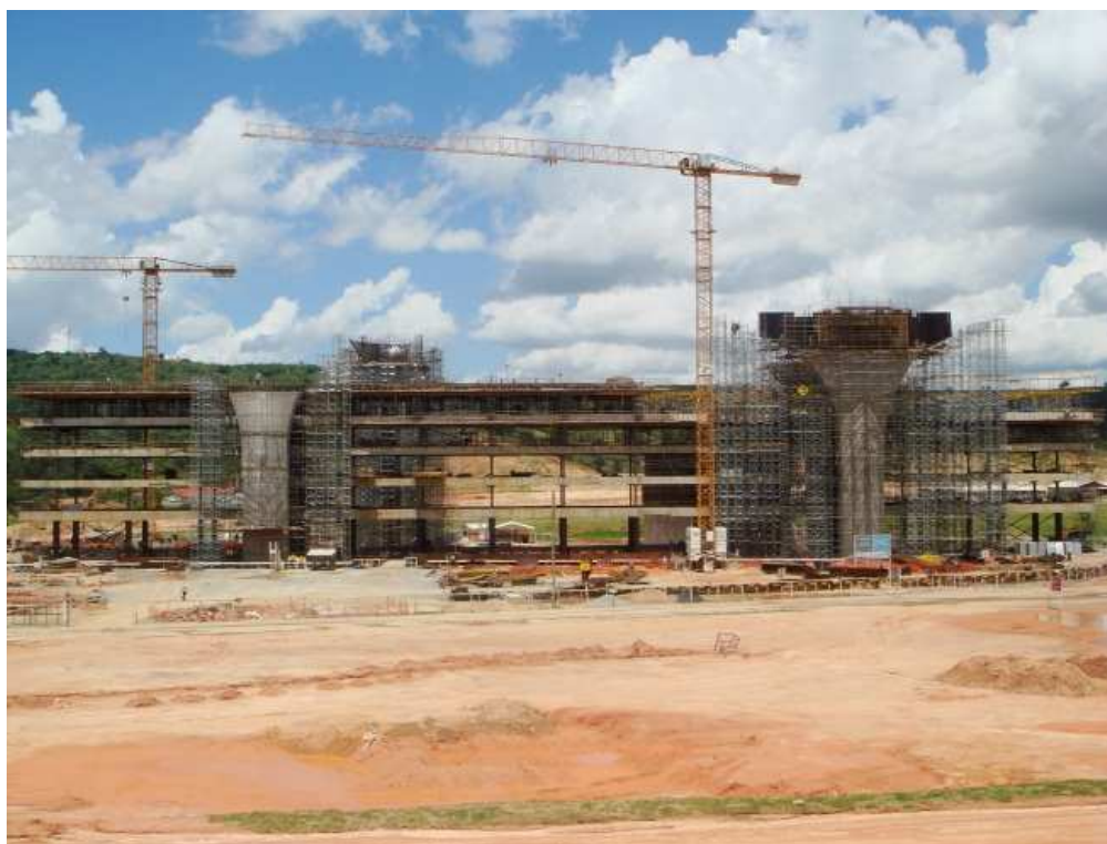
Figura 3.8: a) Pilares provisórios – pavimento térreo; b) Estrutura Metálica dos Tirantes – demais pavimentos.
