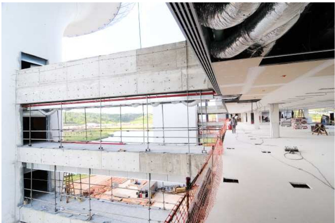
Figura 3.47: Passarela de interligação Heliponto – pavimentos suspensos do edifício
