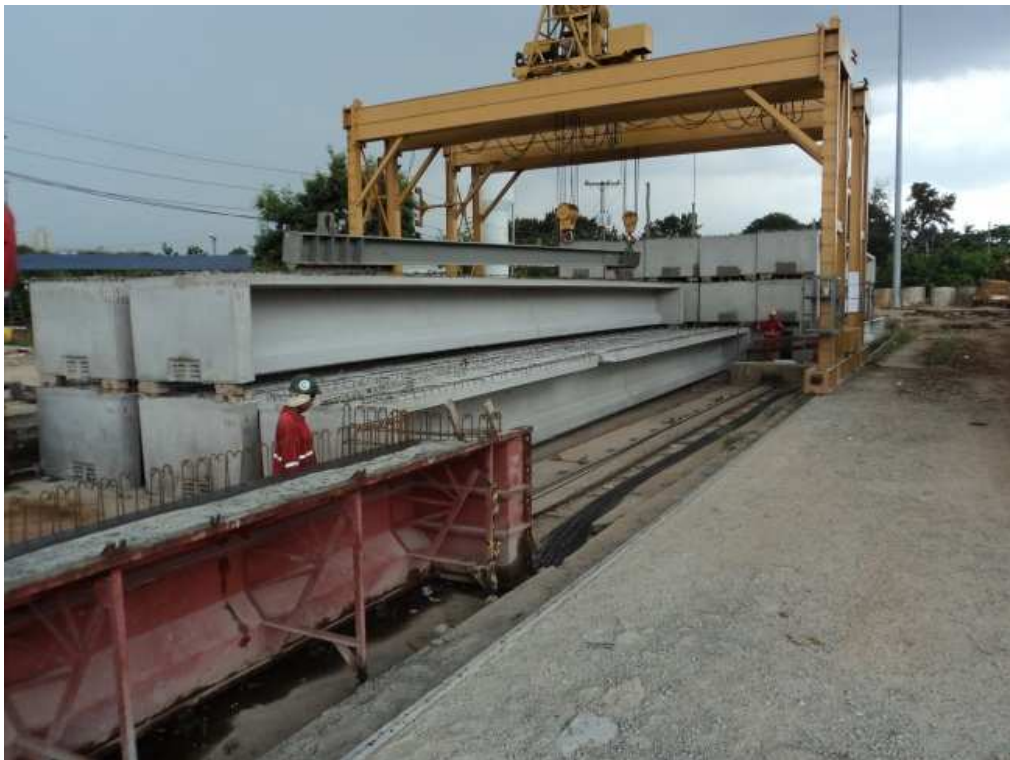
Figura 2.21: Estocagem das vigas
