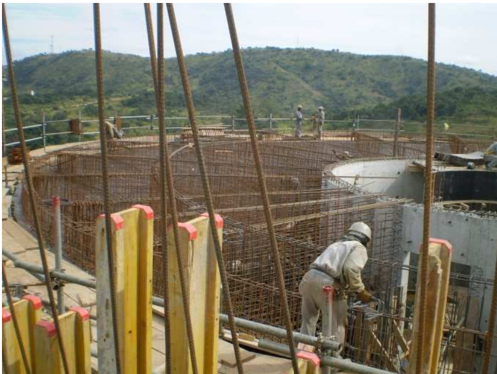
Figura 3.51: Heliporto - Vigas radiais
