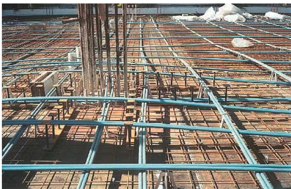
Figura 2.25: Posicionamento dos cabos
