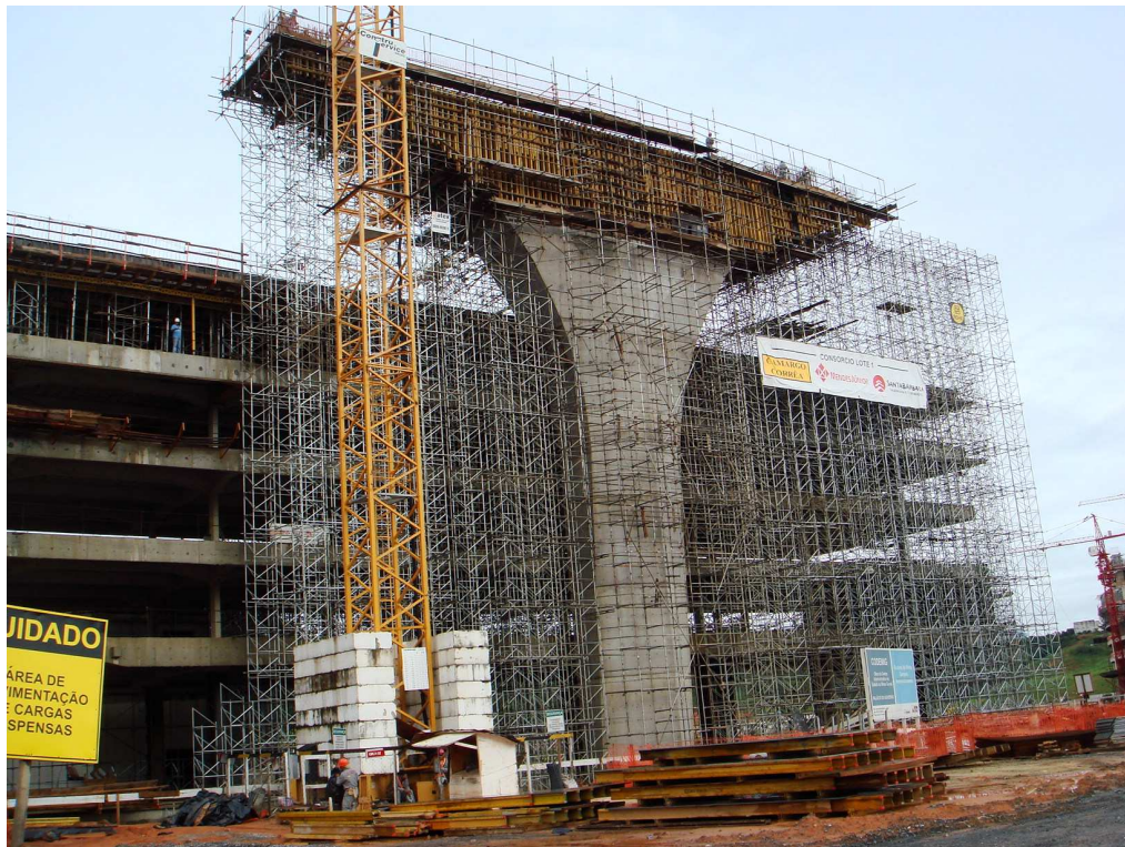
Figura 3.30: Pilares Pórtico - 8ª Etapa – Montagem de Forma (altura = 37,5m)
