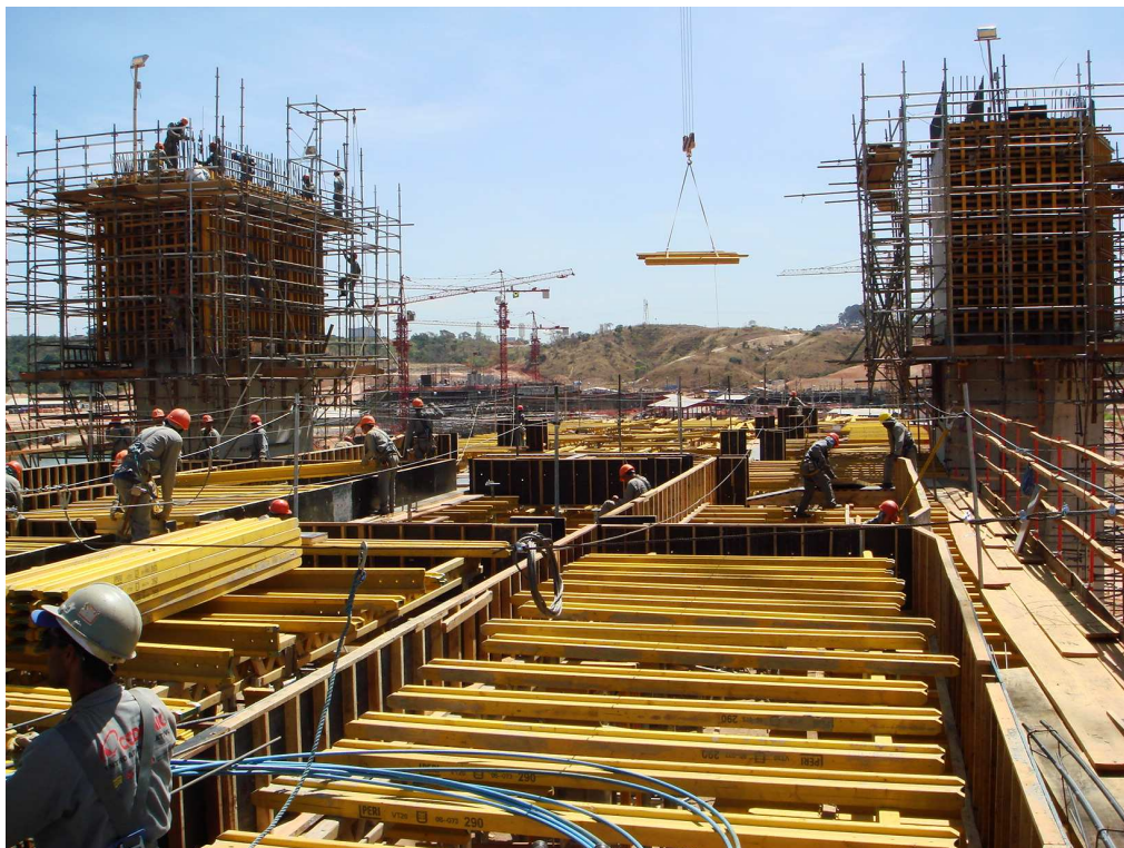
Figura 3.23: Pilares Pórtico - 4ª Etapa
