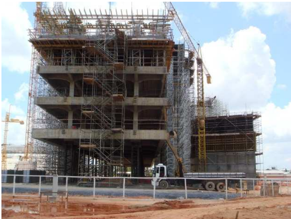
Figura 3.10: a) Pilares provisórios – térreo; b) Estrutura Metálica dos Tirantes - demais pavimentos.
