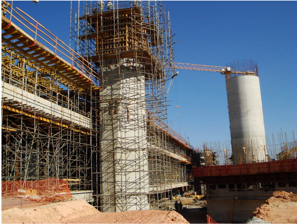
Figura 3.24: Pilares Pórtico - 5ª Etapa
