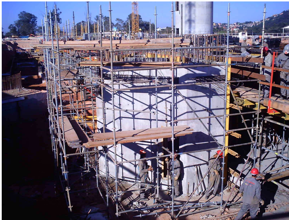
Figura 3.20: Pilares Pórtico - 1ª Etapa
