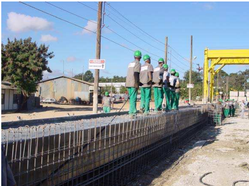
Figura 2.17: Passagem das cordoalhas
