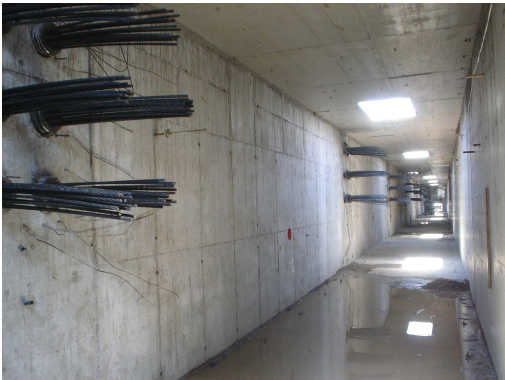
Figura 3.37: Vigas Longitudinais – Vista Interna
