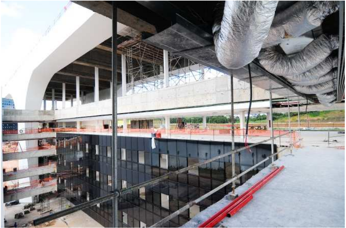
Figura 3.11: Estrutura metálica dos tirantes – pavimentos quarto e técnico
