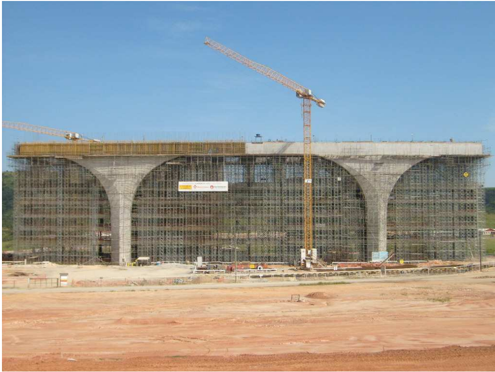
Figura 3.36: Vigas Longitudinais – Concretagem
