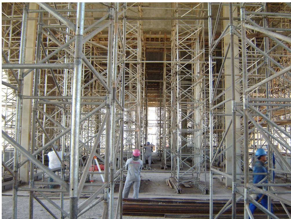
Figura 3.38: Vigas Transversais - Cimbramento
