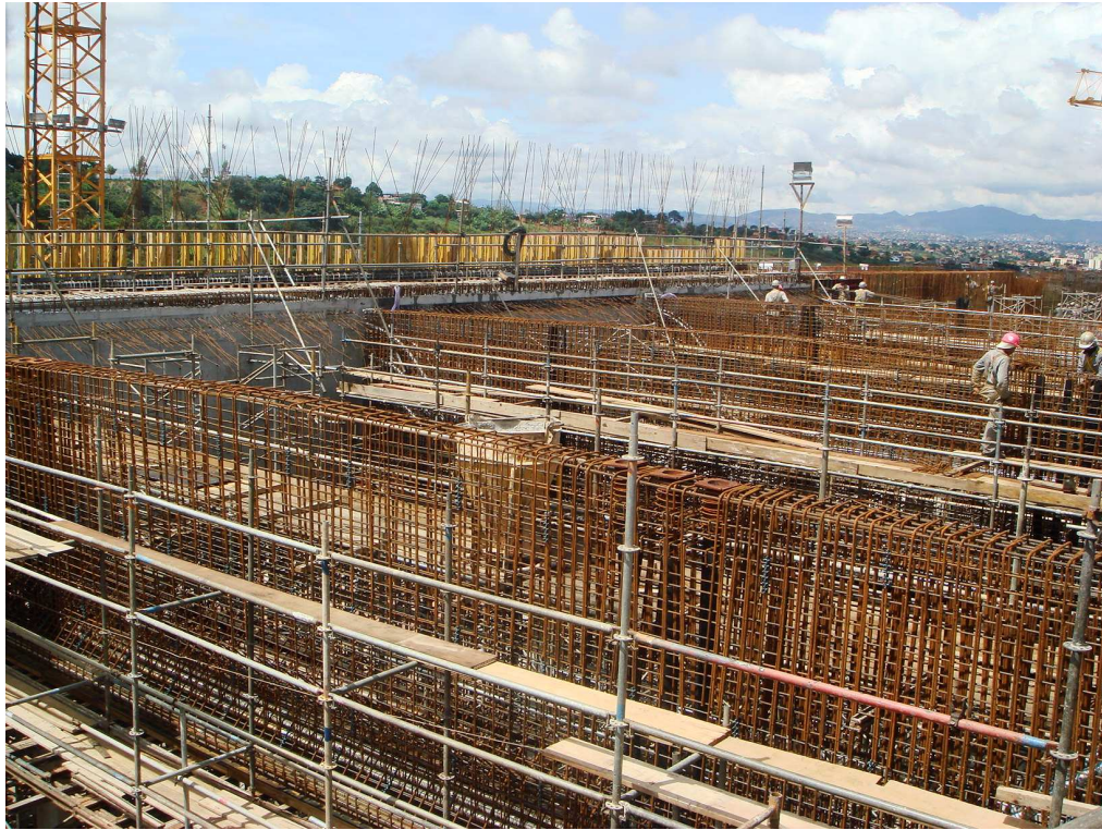
Figura 3.39: Vigas Transversais – Armação
