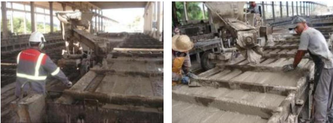
**Figura 12: Lançamento do Concreto sem vibração e Acabamento Superficial**
