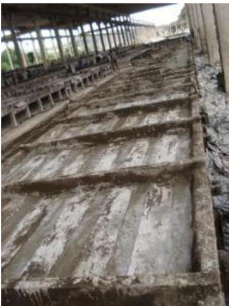
**Figura 13: Estacas concretadas**
