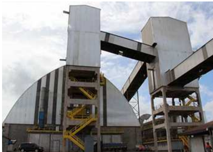
Figura 6 - Detalhe de um Armazém de Grãos. (Vale, 2013).
