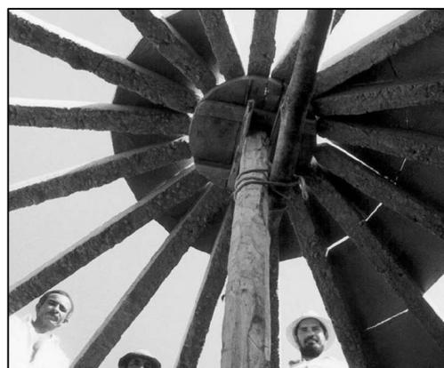
apertando firme com torquês ou alicate. Molhar a rodela antes de chumbar os caibros. Despejar um balde com o traço de areia, brita e cimento sobre o ponto de amarração dos caibros em cima da rodela. Socar bem o concreto com um pedaço fino de madeira até encher todos os vazios da amarração, para dar mais firmeza à estrutura. Com o arame nº 12, fazer a amarração nas pontas dos caibros sobre a parede, dando duas voltas de arame.
