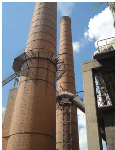
FIGURA 12: Chaminés dos fornos Fonte: Mineração Belocal – Grupo Lhoist, 2011
