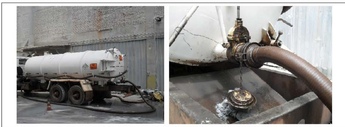
Figura 7: Sistema de injeção do óleo, caminhão tanque, mangueiras (lado esquerdo) e válvulas de conexão (lado direito)
