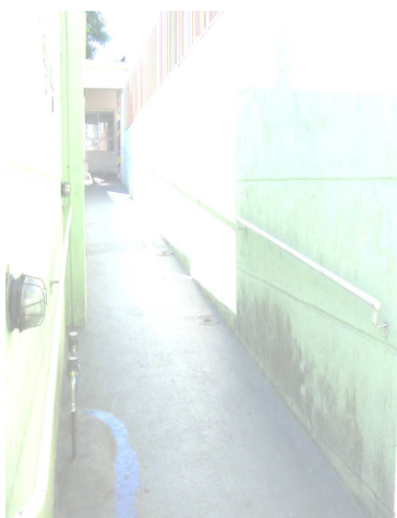
Foto 7A – Rampa principal de acesso.
