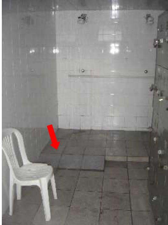
Foto 4 – Vista parcial do banheiro/ vestiário com adaptações para PD
