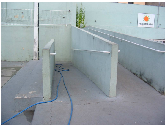
Foto 7D – Rampas de acesso aos vestiários e a quadra poliesportiva.
