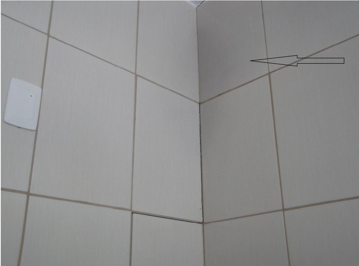
Figura 22 – Fissura na junta de dessolidarização e mancha escura no revestimento cerâmico.
