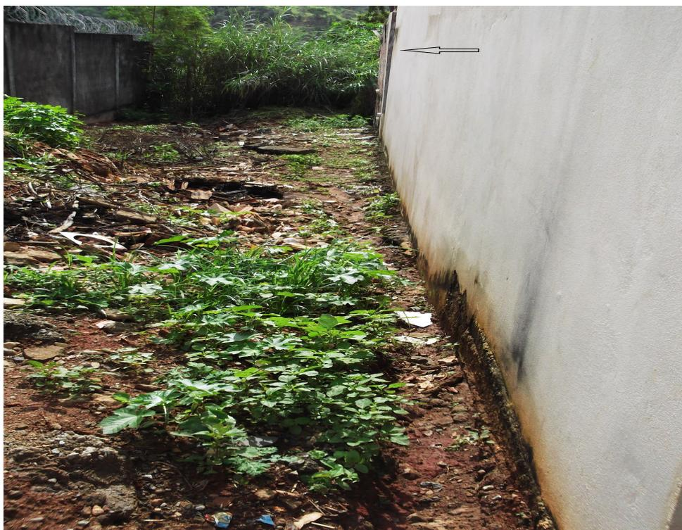
Figura 17 – Umidade na parede lateral do imóvel
