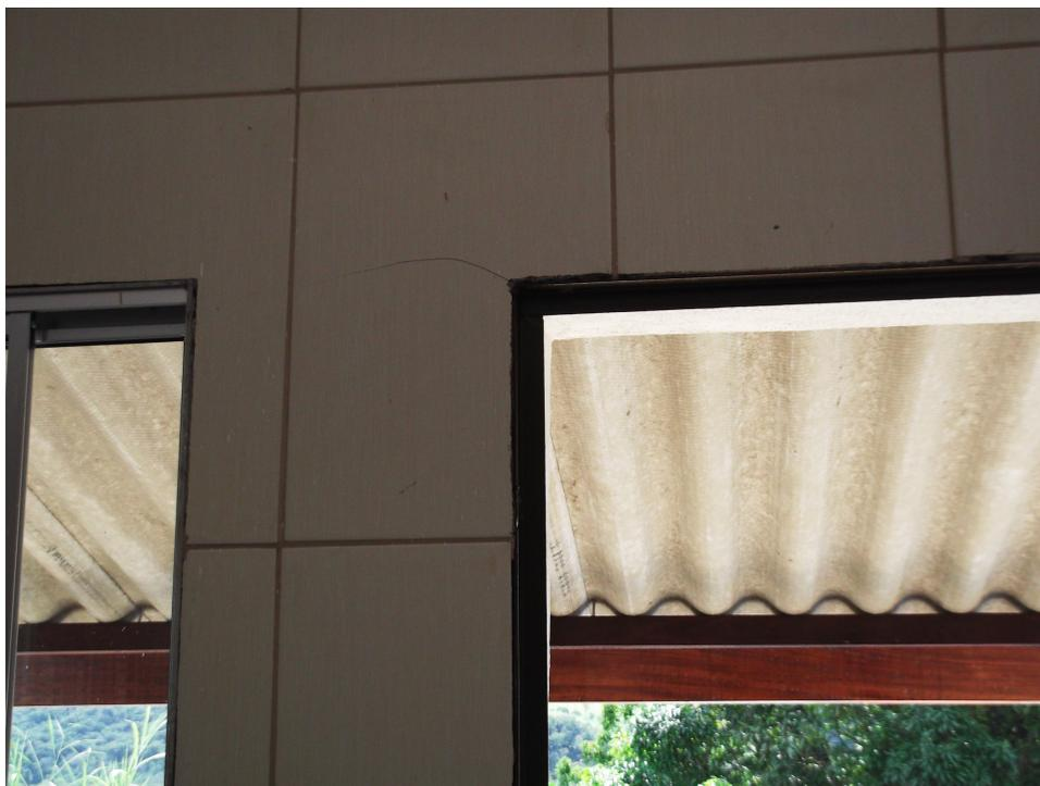
Figura 21 - Fissura no revestimento cerâmico com inclinação próxima a 45° no canto superior da porta.
