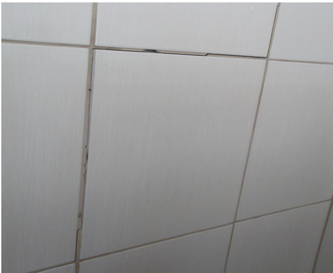
Figura 23 – Fissura na junta de dessolidarização do revestimento cerâmico.
