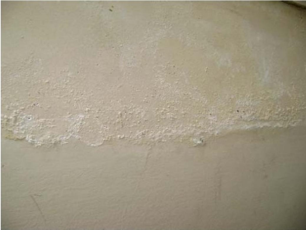
Figura 10 – Eflorescência no revestimento interno do Fórum de Leopoldina
