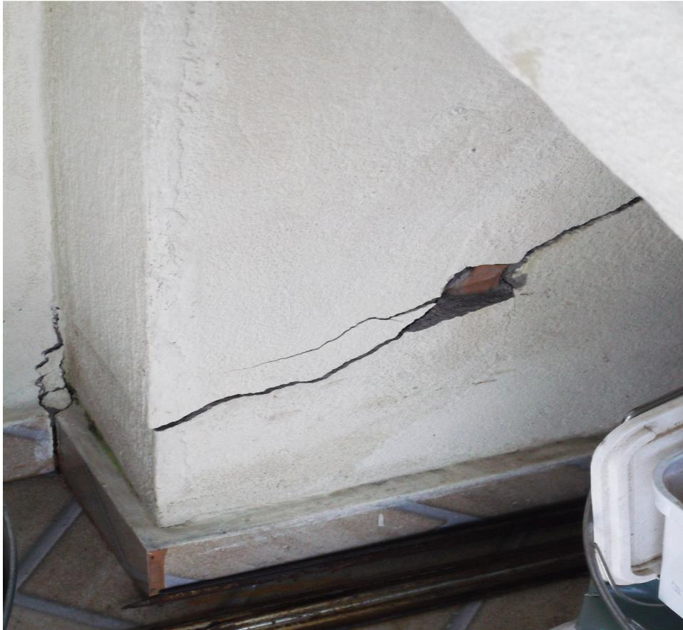
Figura 18 – Trinca e destacamento do revestimento argamassado
