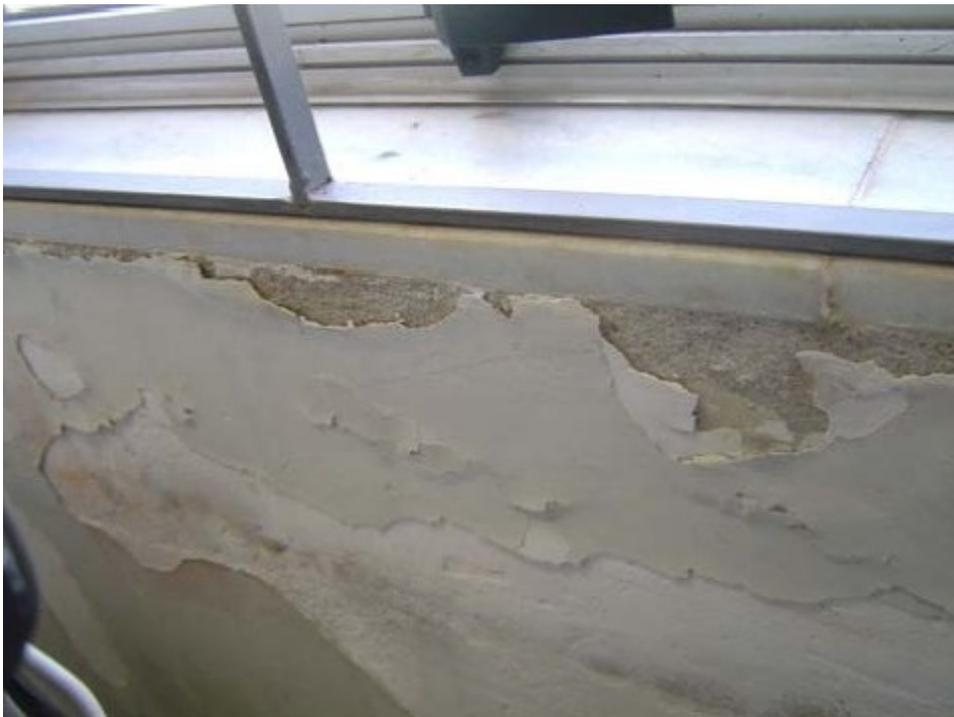
Figura 12 - Deterioração do reboco devido à infiltração de água pela janela de um prédio (Ferreira, 2010)
