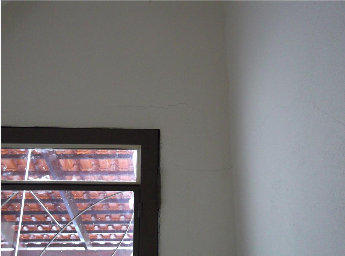
Figura 20 – Fissuração generalizada no revestimento argamassado.
