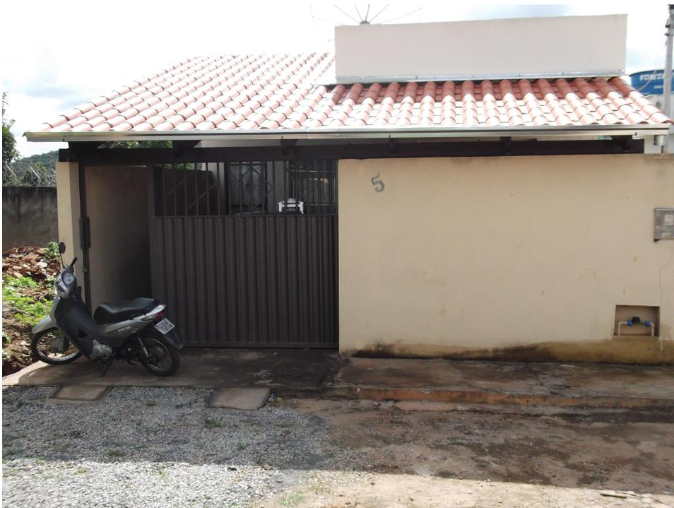
Figura 16 – Umidade na parede frontal do imóvel
