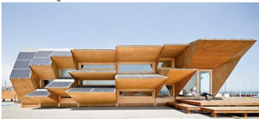
Figura 7 - Painéis fotovoltaicos nas coberturas
