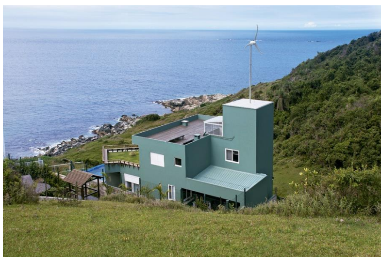
Figura 15 - Residência com aerogerador
