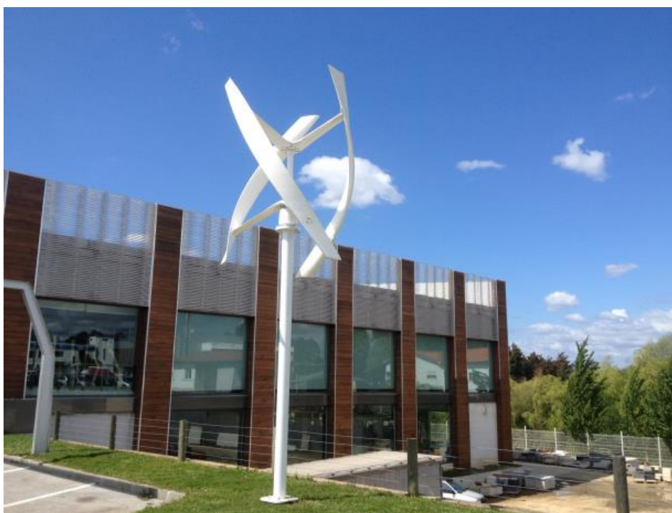
Figura 16 - Turbinas de eixo vertical
