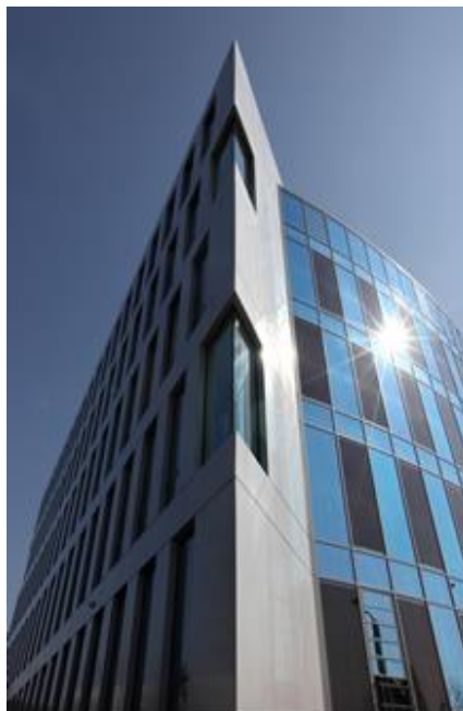
Figura 8 - Painéis fotovoltaicos nas fachadas
