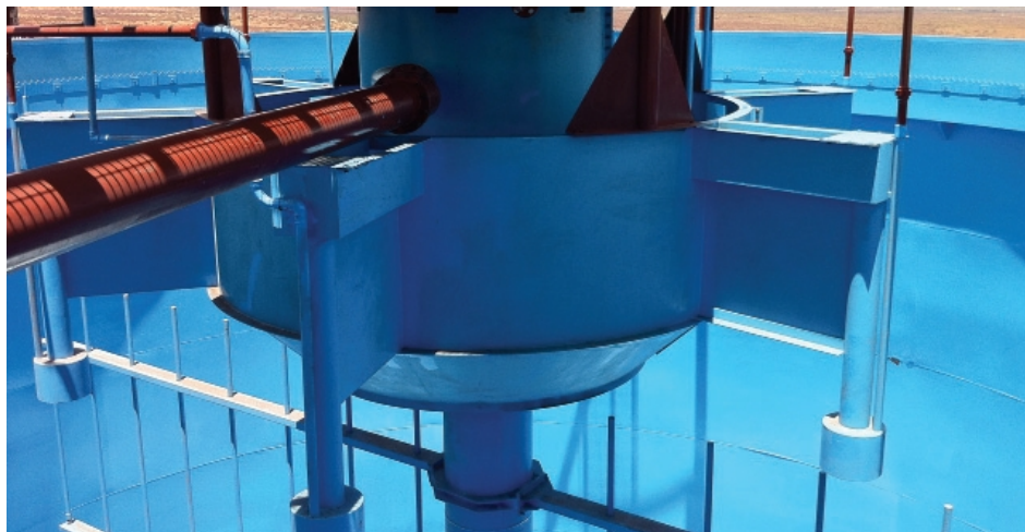
Figura 3.30: Representação de um poço de alimentação EvenFlo™ com diluição AirLift™ (WESTECH, 2006)
