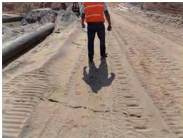
Figura 54: Trincas na crista da barragem e saturação no pé do talude identificados por Samarco em 27 de agosto de 2014. Fonte: Samarco/(Morgenstern et al., 2016).
