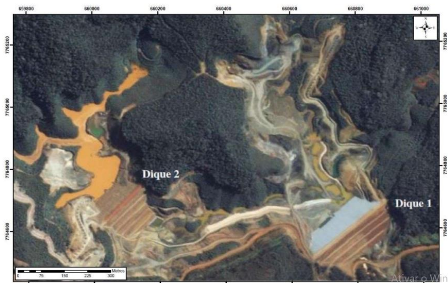
Figura 12: Barragem do Fundão. Vista geral no ano de 2008, imediatamente após sua implantação.
