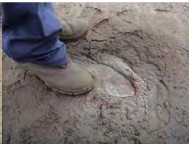
Figura 54: Trincas na crista da barragem e saturação no pé do talude identificados por Samarco em 27 de agosto de 2014. Fonte: Samarco/(Morgenstern et al., 2016).
