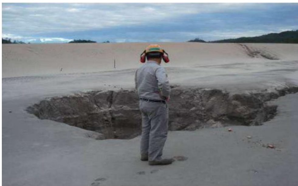
Figura 51: Detalhe da subsidência (sinkhole) sobre a junta 18 da galeria secundária. Fonte: Samarco/MPF.
