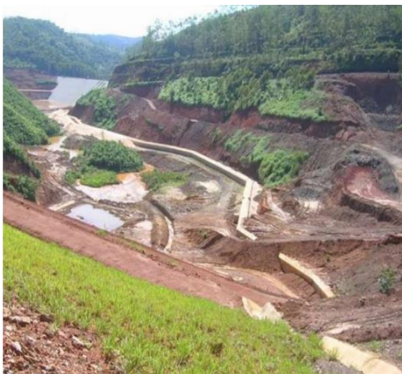
Figura 35: Galeria principal, com o Dique 1 ao fundo. Fonte: Procedimento Investigatório Criminal (PIC) MPF n.º 1.22.000.000003/2016-04.
