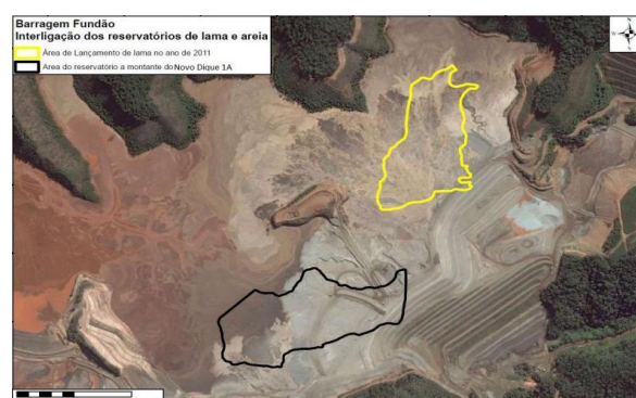
Figura 48: Projeção do perímetro de acumulação de lama em maio de 2011, em preto e amarelo, sob o depósito de rejeito arenoso e alteamento do Dique 1 (eixo "S"). Imagem Google Earth, capturada em 20 de julho de 2015. Fonte: Samarco/MPF.
