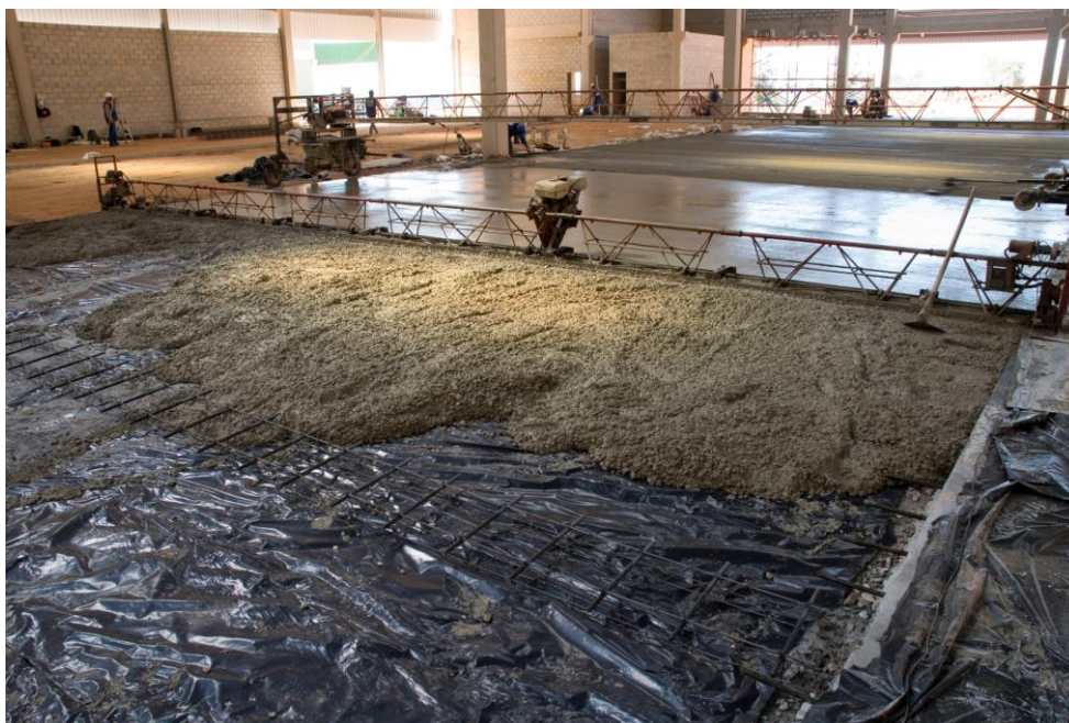
Figura 41 – Adensamento, nivelamento e acabamento do concreto Fonte: Arquivo da ArcelorMittal
