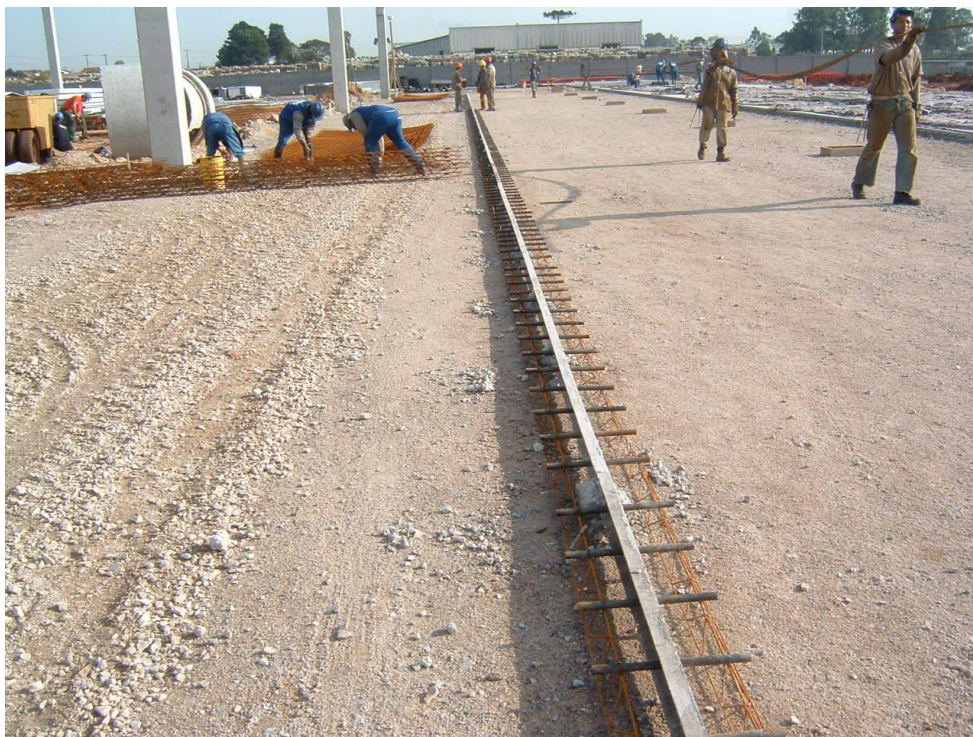
Figura 40 – Assentamento das formas metálicas e preparação das juntas Fonte: Arquivo da ArcelorMittal
