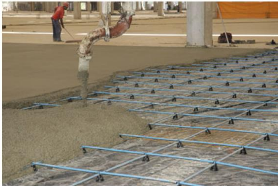
Figura 13 - Concretagem de piso protendido Fonte: site www.pisosindustriais.com.br , 2015
