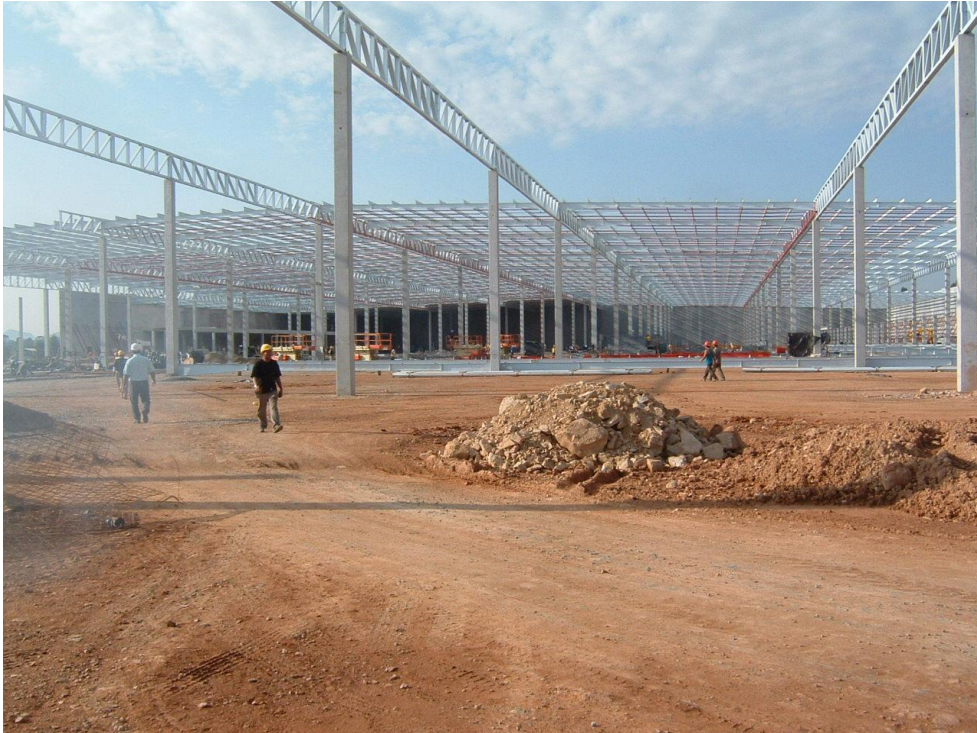
Figura 38 – Preparação do Sub-leito Fonte: Arquivo da ArcelorMittal
