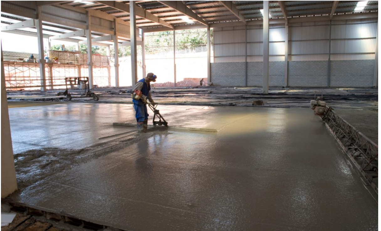
Figura 42 – Nivelamento com régua vibratória simples Fonte: Arquivo da ArcelorMittal
