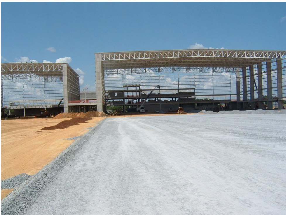
Figura 39 – Preparação da Sub-base
