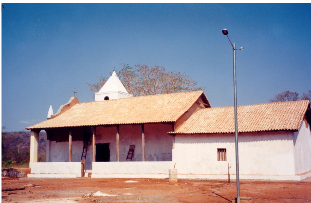
FIGURA 106 e 107 - Capela de Nossa Senhora do Rosário no distrito de Brejo do Amparo, Januária, MG. Fachada frontal e fachada lateral Fonte: IEPHA – MG.
