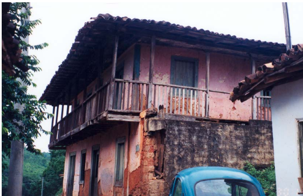
FIGURA 63 - Casa do Inconfidente Domingos de Abreu Vieira. Fachada lateral esquerda. Detalhe do avarandado que circula o 1º pavimento, com acabamentos em madeira e régua simples de madeira no guarda-corpo
