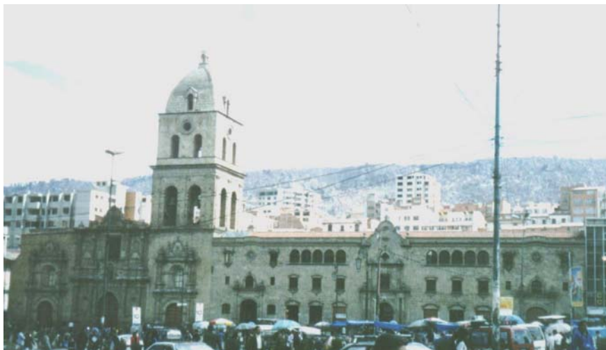
FIGURA 37 - Fachada da Igreja de São Francisco em La Paz, Bolívia Fonte: Acervo da autora, agosto 2004.
