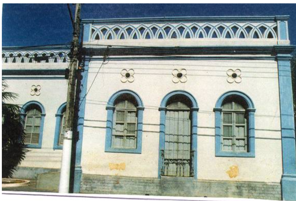
FIGURA 108 e 109 - Platibandas de edificações no município de Januária, MG Fonte: IEPHA – MG.
