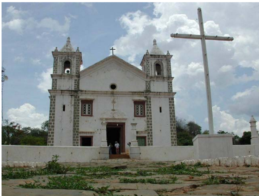
FIGURA 101 - Igreja de Nossa Senhora da Conceição em Matias Cardoso, MG. Fachada frontal Fonte: IEPHA - MG, fev. 1987.
