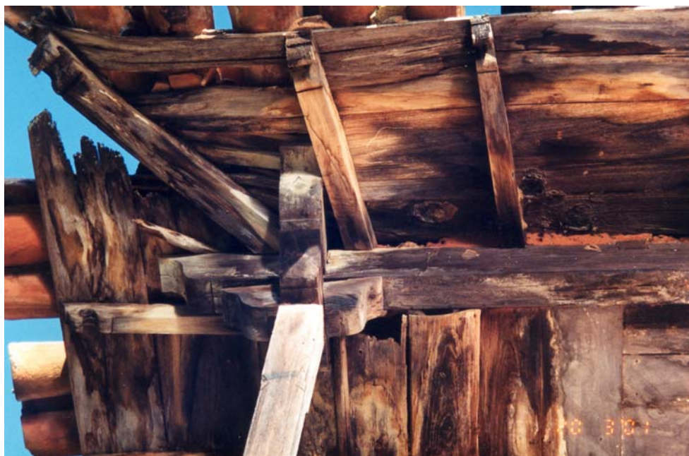
FIGURA 64 - Detalhe do beiral da casa do Inconfidente Domingos de Abreu Vieira, em Berilo. Notar o acabamento dos frechais Fonte: Acervo da autora, março 2001.
