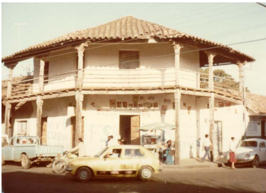
FIGURA 66 - Edificação avarandada, residência na parte superior e comércio na parte térrea. Exemplo encontrado nas proximidades de Cuzco, Peru Fonte: Rômulo Junqueira, agosto 1980.
