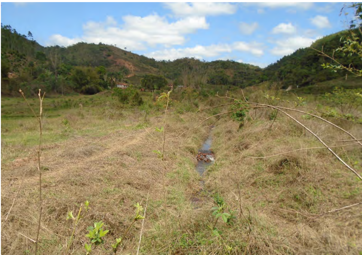
Figura 23 - Calha no córrego construída pela Renova no terreno de Jorge Fonte: Repertório do autor
