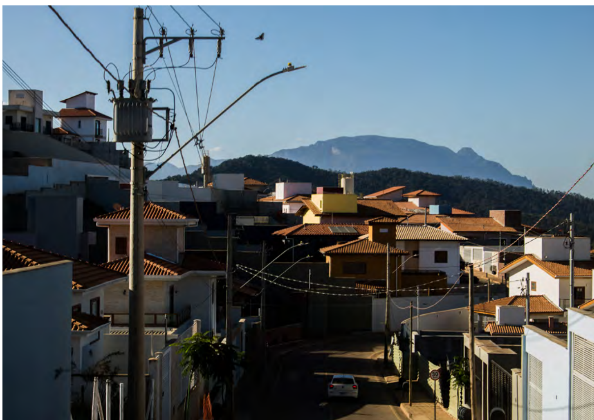
Figura 101 - Casas finalizadas no reassentamento de Bento Rodrigues Fonte: Repertório do autor
