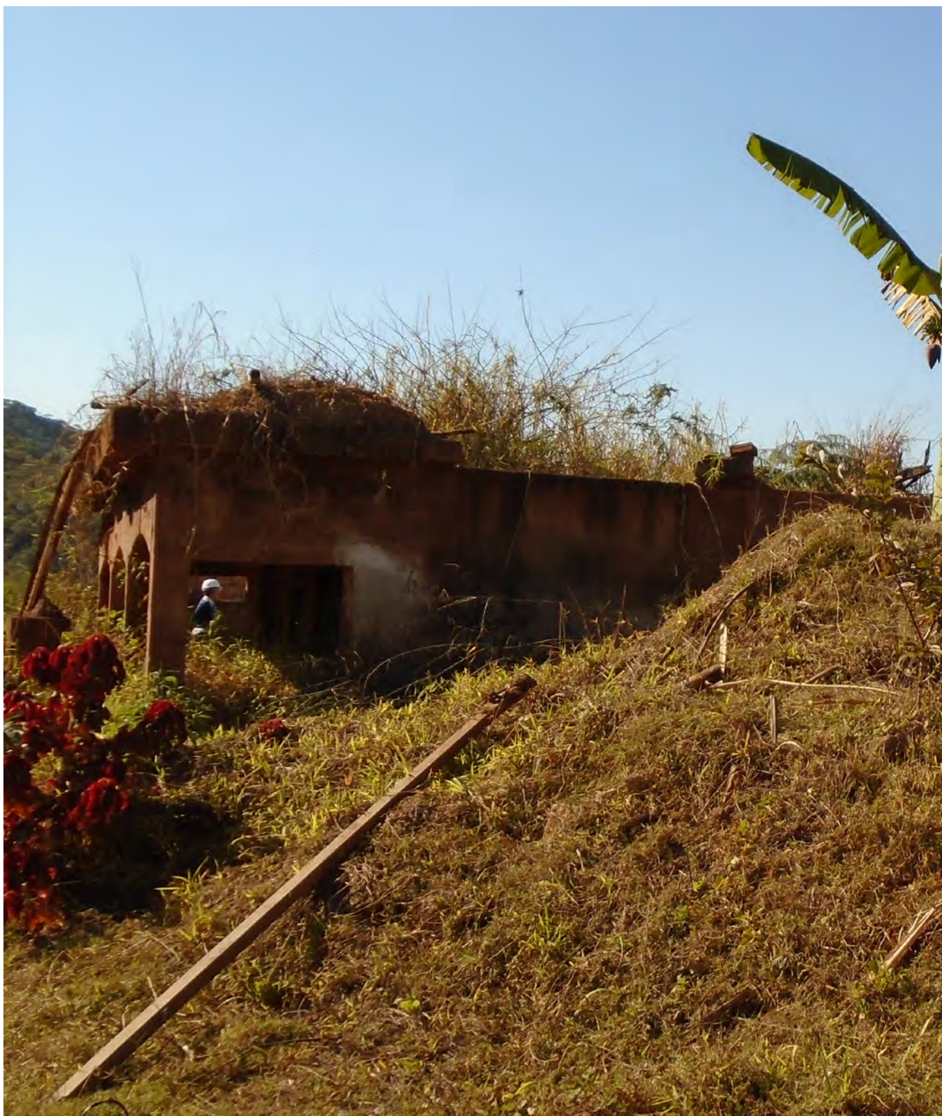
Figura 6 - Vistoria Técnica em Bento Rodrigues Fonte: Repertório do autor
