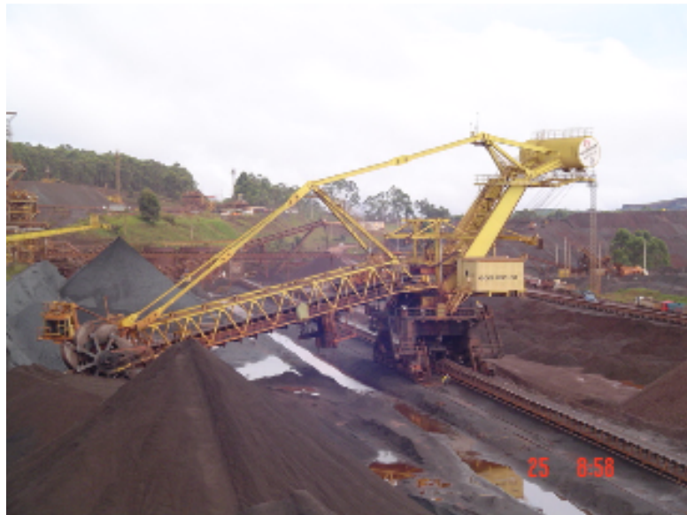
Figura 29 Retomadora ou Recuperadora de minério
