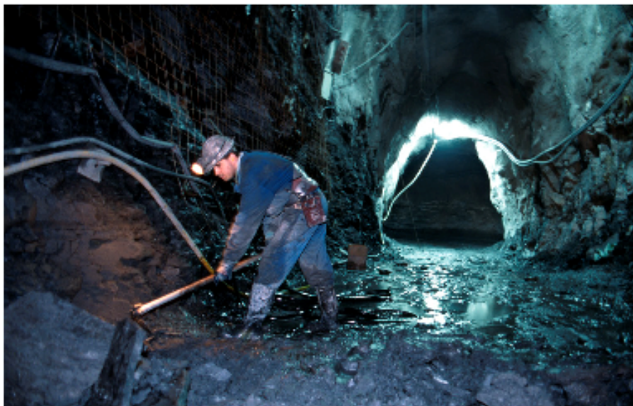
Figura 10 Remoção de material em mina subterrânea com utilização de enxada
