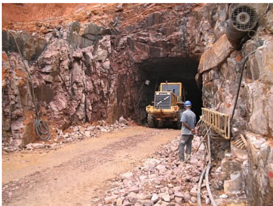
Figura 11 Entrada de Pá-Carregadeira em mina subterrânea
