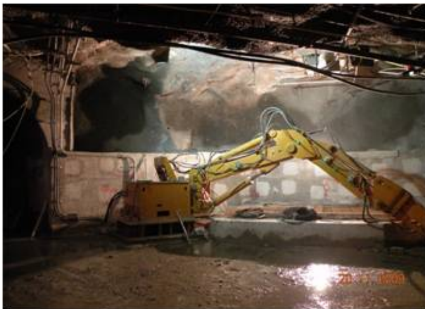
Figura 12 Escavação em mina subterrânea com utilização de escavadeira hidráulica
