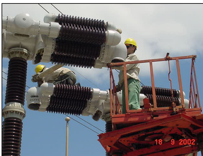
FIGURA 3.4 – Situação típica de trabalho – manutenção em plataforma elevada
