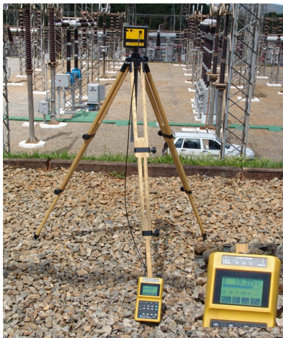
FIGURA 4.25 – Teste de campo - Medição de campo elétrico na SE Taquaril
