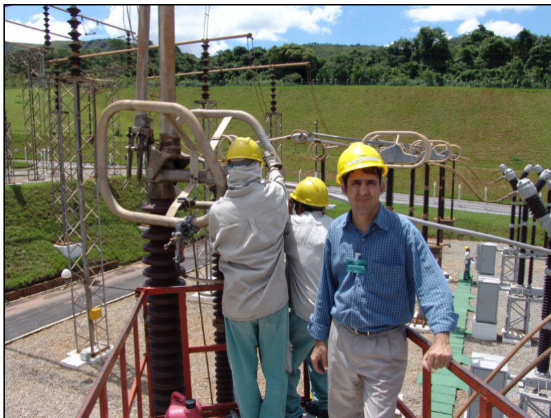
FIGURA 4.26 – Teste de campo - Medição de tensão na plataforma
