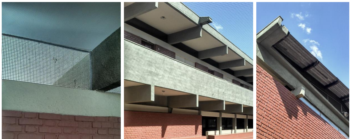
FIGURA 90 (a, b e c) - EE Presidente Antônio Carlos em BH – CARRPE- Detalhes de ventilação permanente superior da (FOTO: do autor, 2015)
