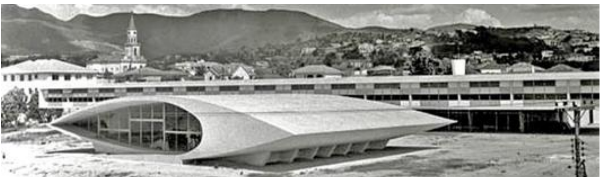
FIGURA 16 - Colégio Estadual Central em BH, de Oscar Niemeyer em 1954 (FONTE: APM)
