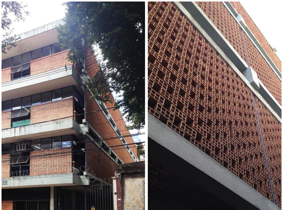
FIGURA 25 (a e b) – Sede da CARPE em Belo Horizonte na Rua Congonhas 675, no bairro Santo Antônio, BH – Fachada principal e detalhe (FOTO: do Autor, 2015)
