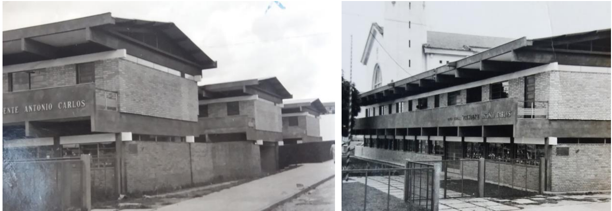
FIGURA 91 (a e b) - EE Presidente Antônio Carlos – CARRPE - Cobertura em amianto e calha (FONTE: Acervo Pessoal Galileu Reis)
