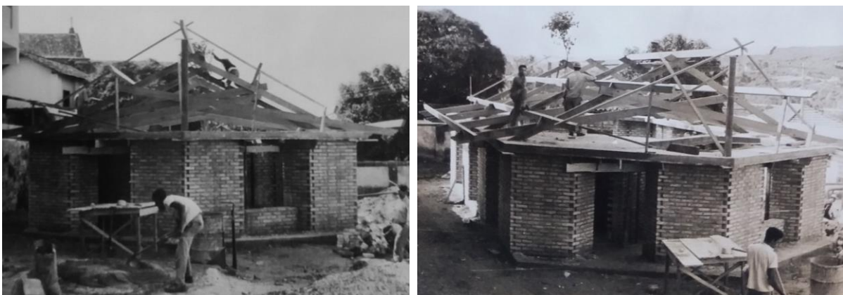
FIGURA 30 (a e b) - Jardim de infância de Caeté em construção - montagem do telhado (FONTE: Acervo Galileu Reis)
