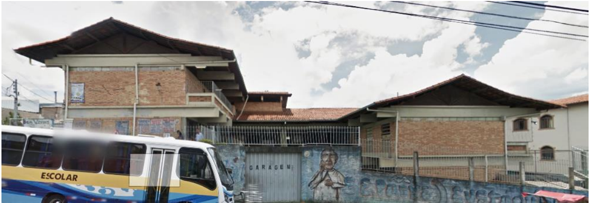
FIGURA 88 - EE Padre Eustáquio em BH – CARRPE - Comunicação entre blocos em desnível (FONTE: Google Street View, 2016)
