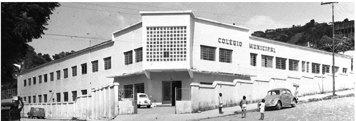
FIGURA 6 - Ginásio Municipal de BH – 1ª Colégio público do município, de 1948 (FOTO: APCBH, 1966)
