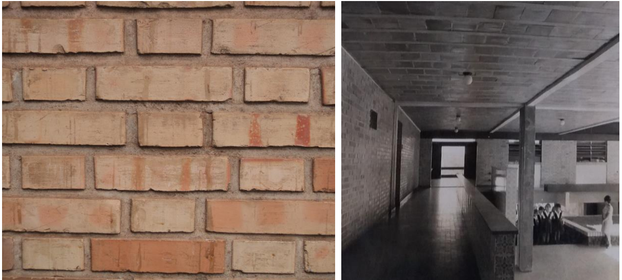
FIGURA 89 (a e b) – EE Padre Eustáquio em BH – CARRPE - Detalhe da paginação dos tijolos e foto do corredor aberto de ligação entre blocos (Foto: do autor, 2015; Acervo Pessoal Galileu Reis)
