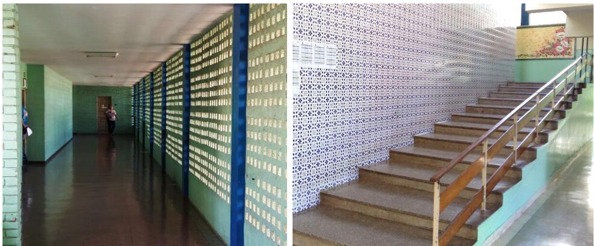
FIGURA 77 (a e b) - Escola Normal Oficial de Montes Claros - Circulação com elementos vazados e Escada Principal com azulejos da (FOTOS: Amaro Sérgio Marques, 2016)
