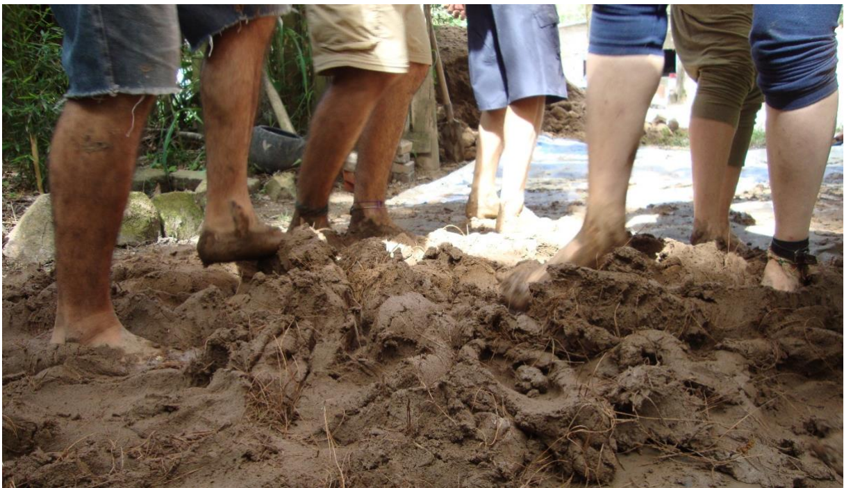
FIGURA 5 – Processo de formação da massa de terra crua
