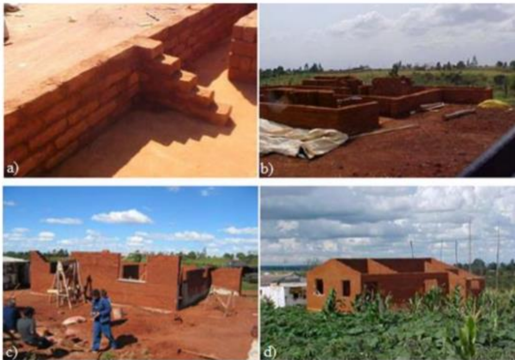
FIGURA 9: Processo construtivo com tijolo de adobe
