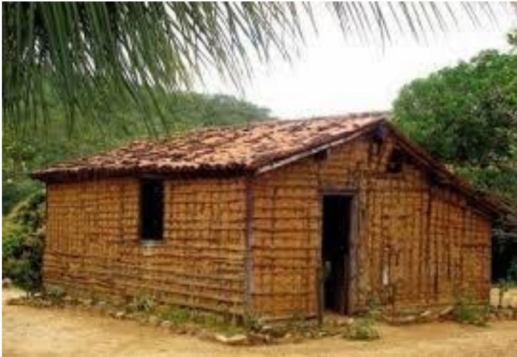
FIGURA 2: Casa construída utilizando a técnica de Taipa de mão.
