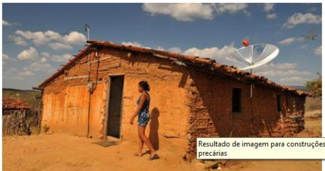
FIGURA 8: Edificação moderna mal acabada e precária feita em adobe e taipa de mão
