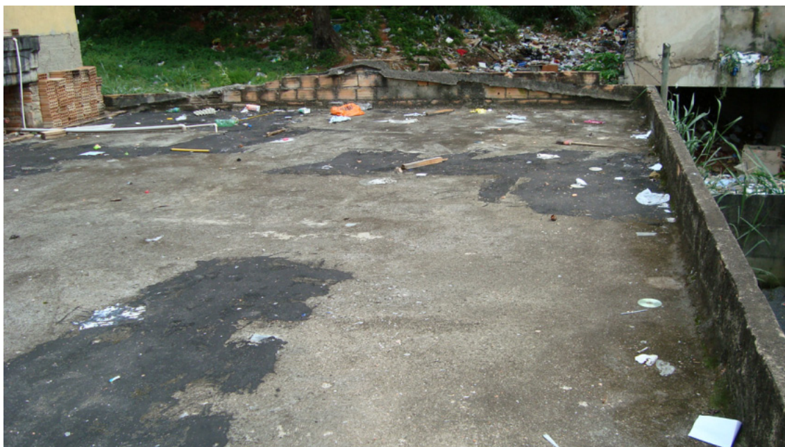
FIGURA 32 – Vista da laje.
