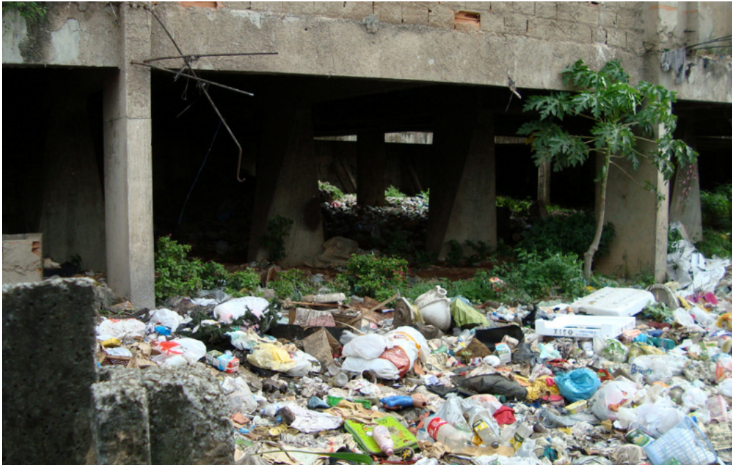
FIGURA 29 – Vista por sobre o muro de divisa.
