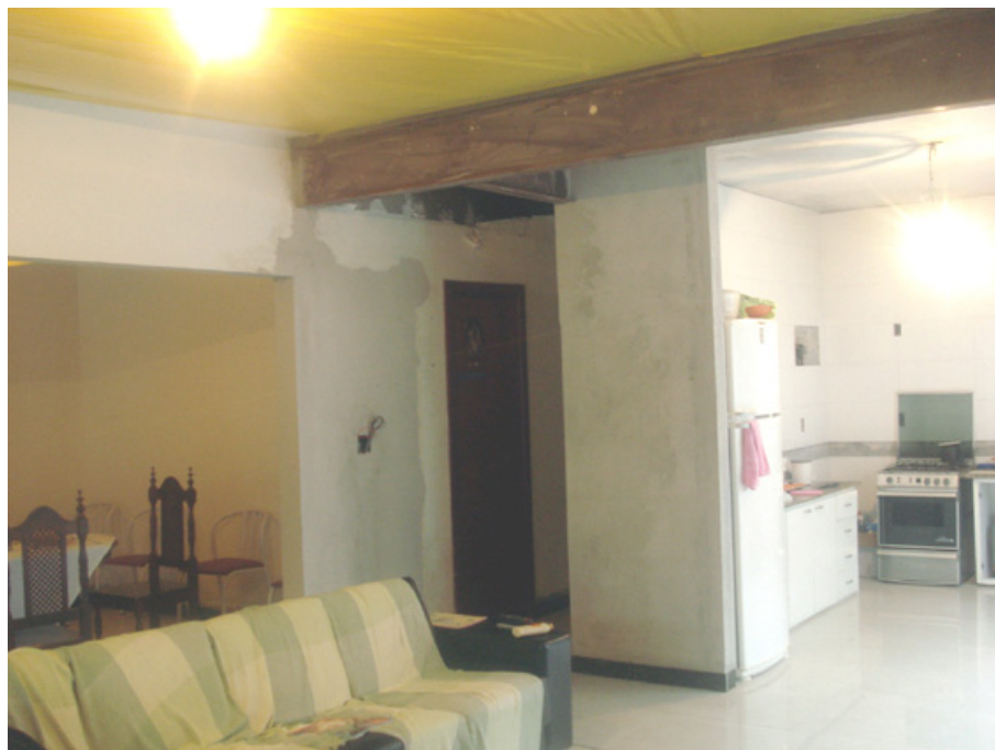
FIGURA 11 – Interior da casa, obra já iniciada. Fonte: arquivo pessoal da autora, 2010.
