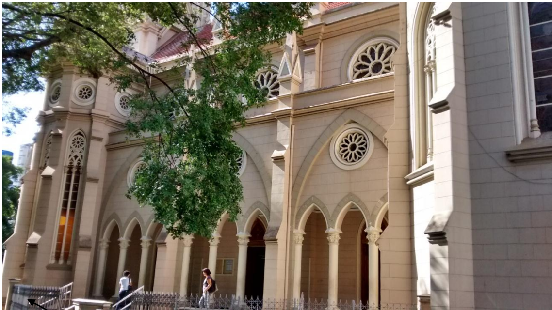
Figura 24: Entrada lateral, porção norte, do templo.
