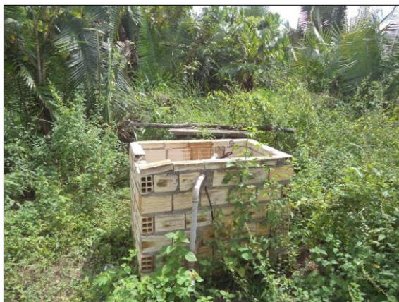
Figura 47 – Revestimento superficial do poço Fonte: A autora, 2018.
