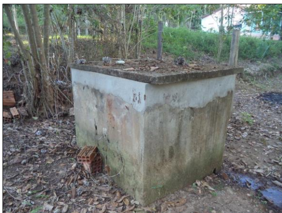
Figura 26 – Revestimento superficial do poço artesiano
