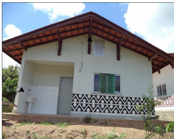
Figura 33 – Compartimento para reservatório e tanque Fonte: A autora, 2018.
