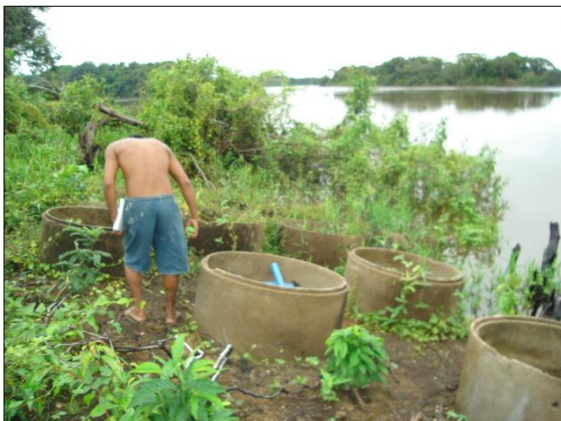
Figura 41 – Reservatórios para armazenamento da água do rio Xingu
