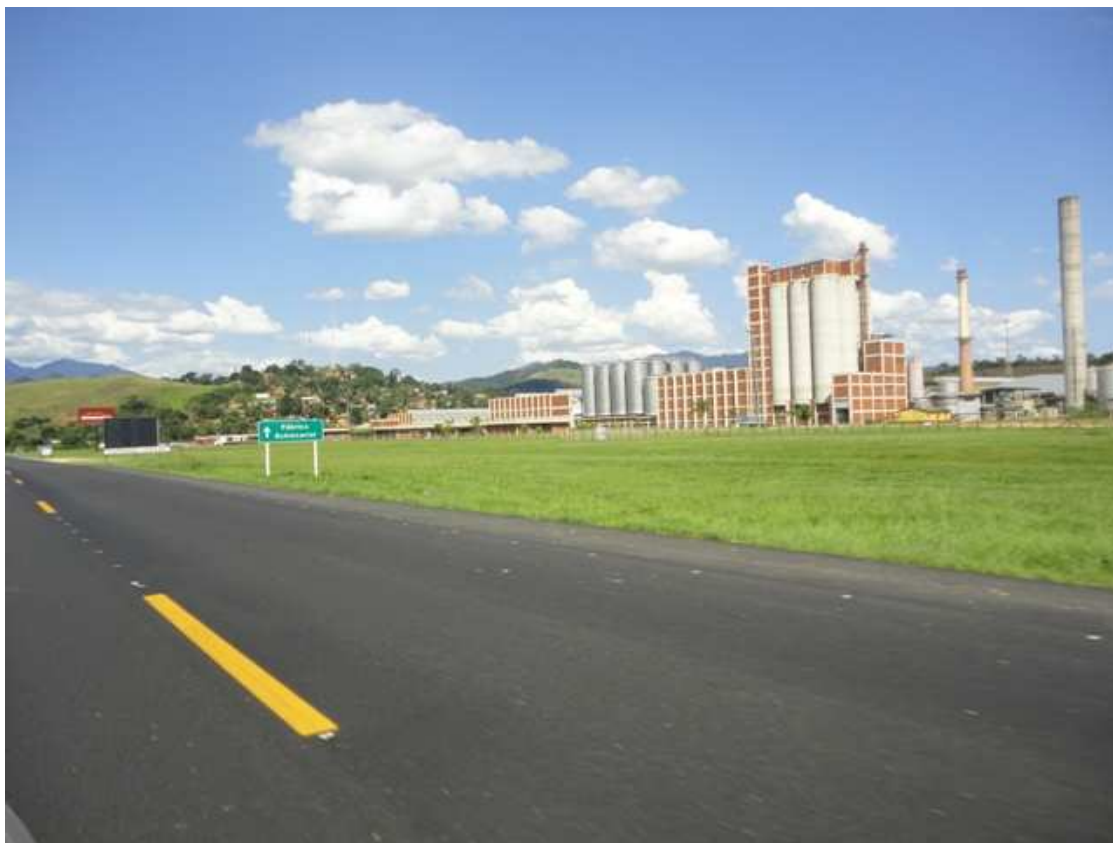
Figura 27 – Rodovia RJ 122 executada com Asfalto borracha
