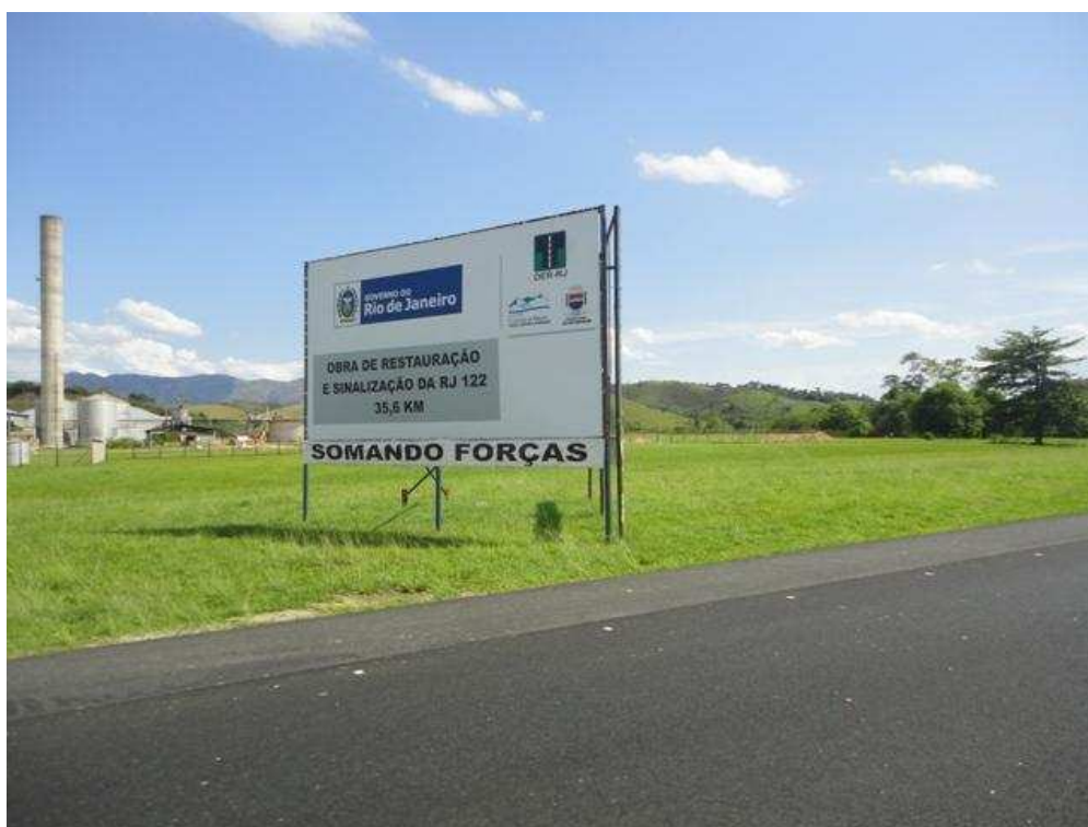
Figura 23 – Rodovia RJ 122 Obra de restauração executada com Asfalto Borracha.
