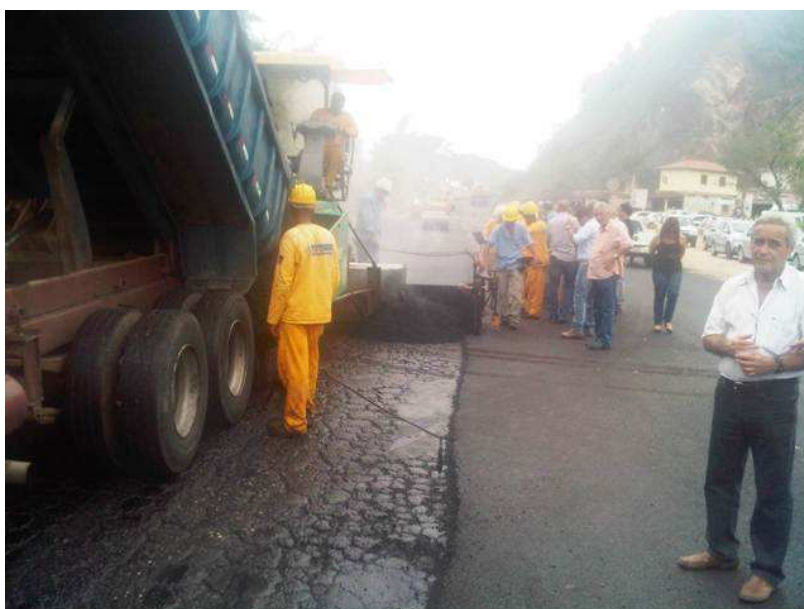
Figura 2 – Aplicação de Asfalto Borracha sobre Asfalto trincado.
