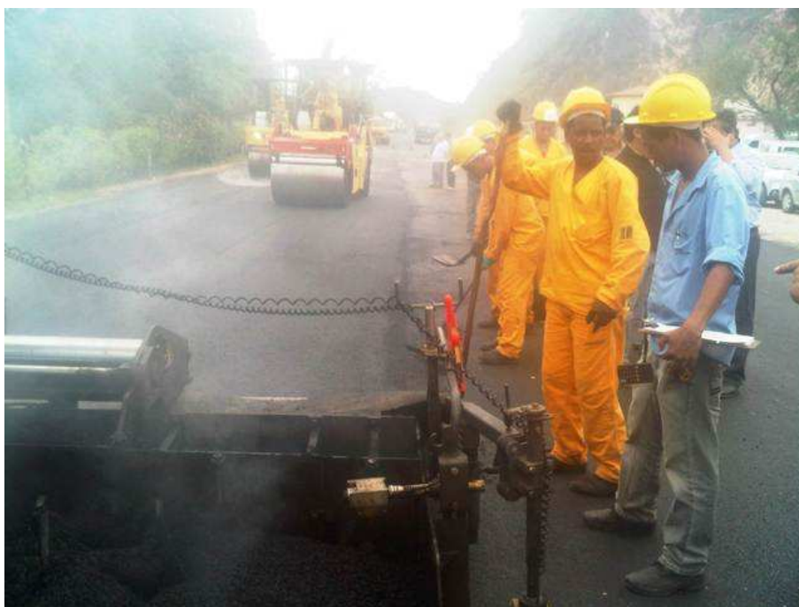
Figura 18 – Aplicação de Asfalto Borracha.
