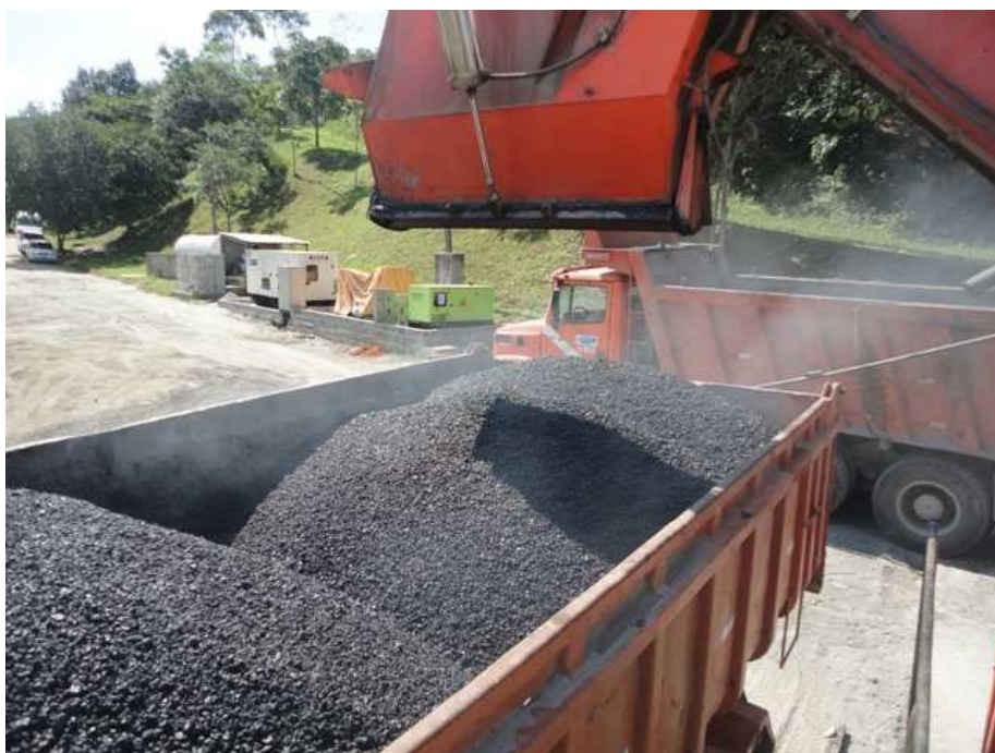
Figura 12 – Carregamento de Asfalto Borracha.
