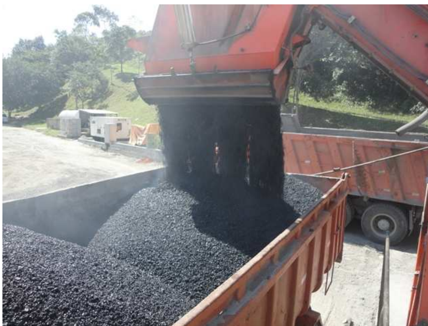
Figura 13 – Carregamento de Asfalto Borracha.
