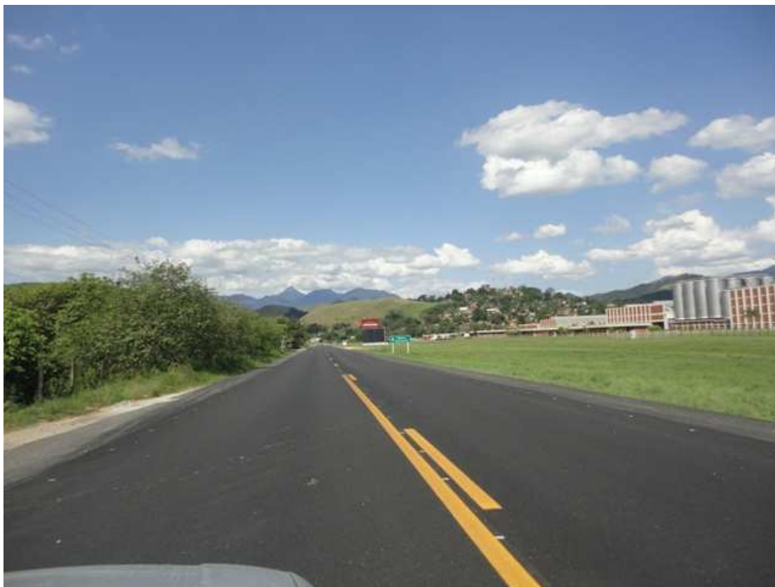
Figura 26 – Rodovia RJ 122 Asfalto Borracha - obra concluída.
