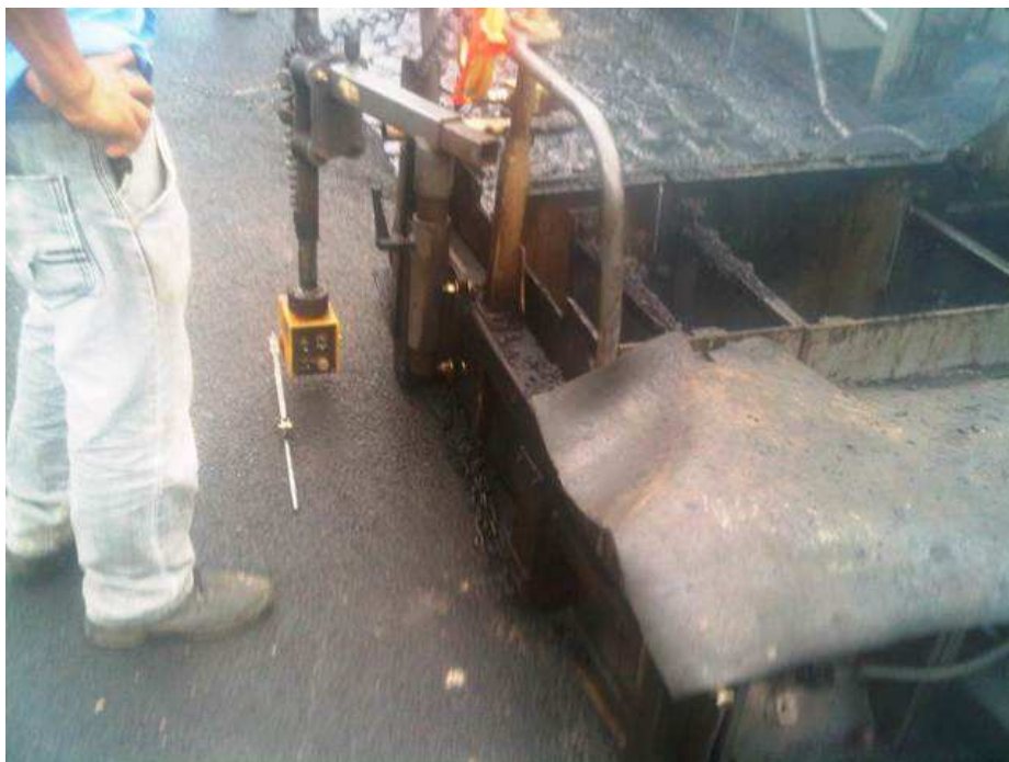
Figura 17 – Aplicação de Asfalto Borracha.
