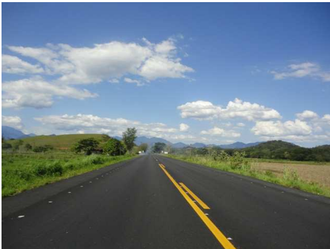
Figura 25 – Rodovia RJ 122 Asfalto Borracha - obra concluída.
