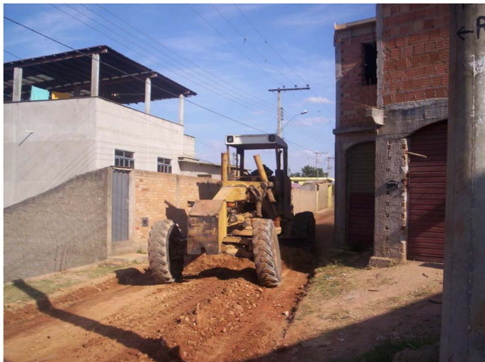
Figura 93 - Rua durante a intervenção.
