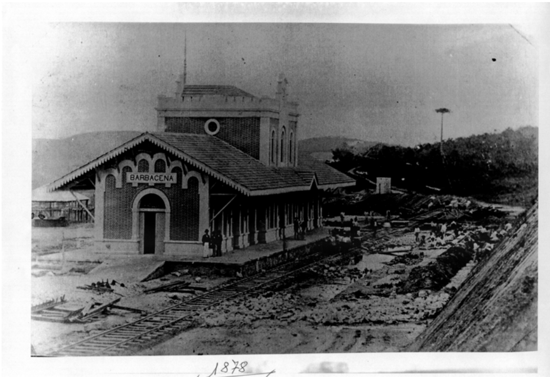
Figura 24 - Estação ferroviária de Barbacena durante a sua construção (1878).
