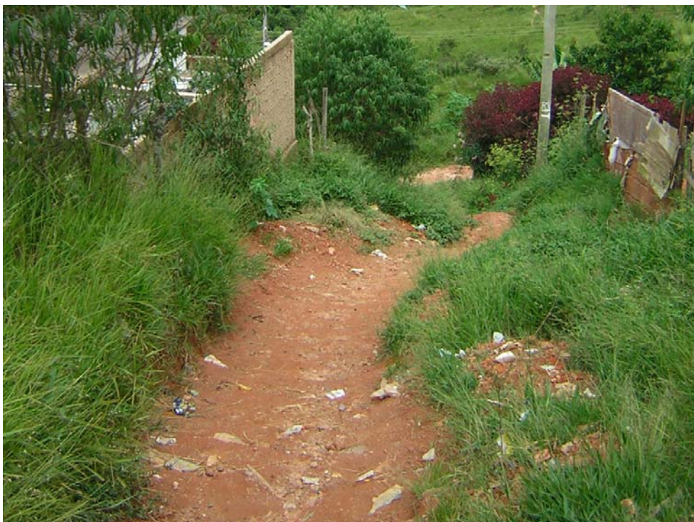
Figura 92 - Rua antes da intervenção.
