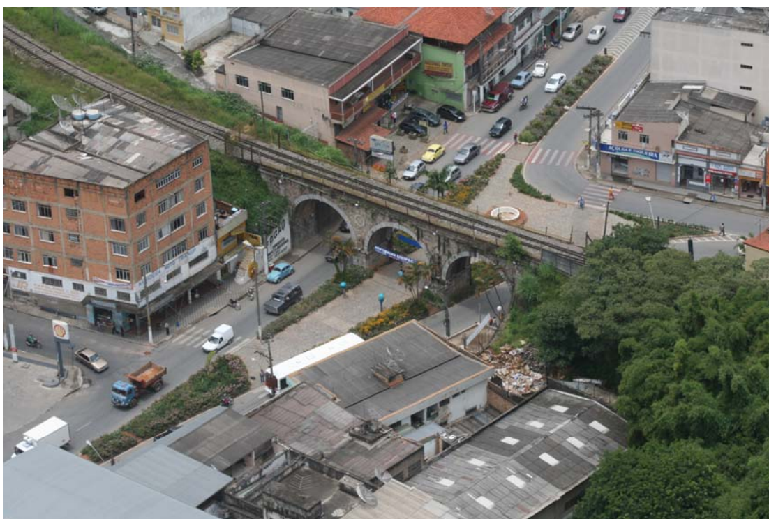
Figura 14 - Largo do Pontilhão em Barbacena-MG: Após reforma urbana (2010).
