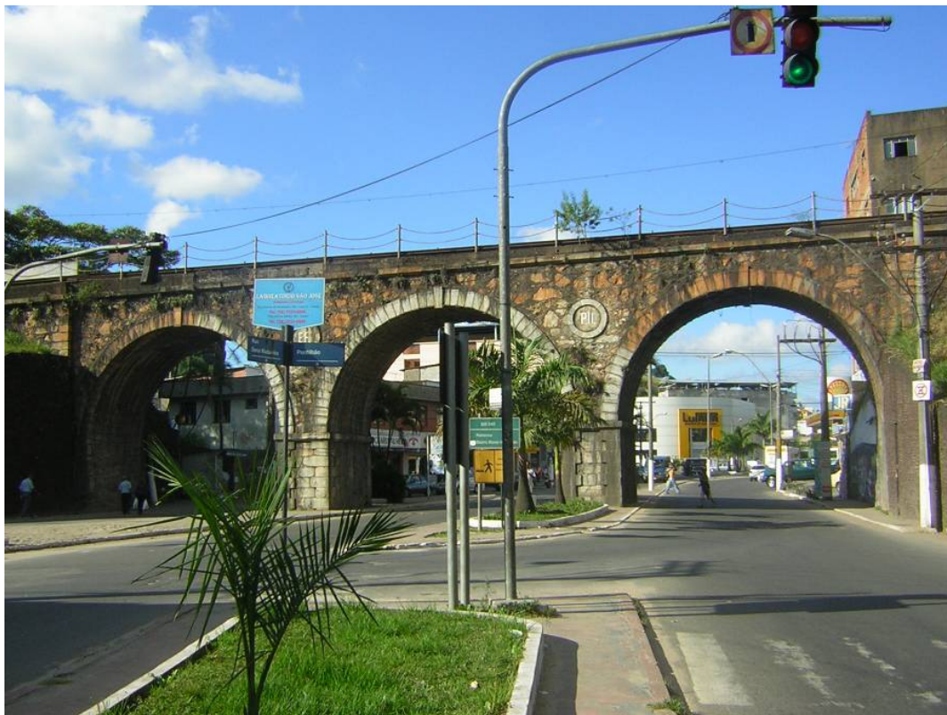
Figura 12 - Largo do Pontilhão em Barbacena-MG: Situação existente (2005).
