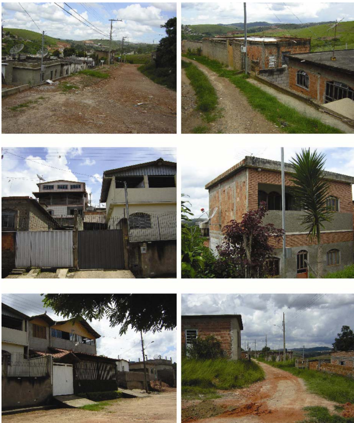
Figura 64 - Exemplos das diferentes tipologias encontradas no Bairro
