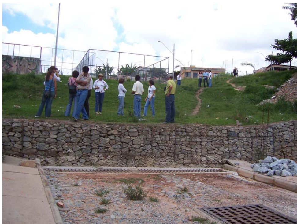
Figura 71 - Exemplo em Contagem: Prof. Edézio. Aterro dique para controle da vazão das águas pluviais em bairros de baixa renda – Já finalizado, resultado.
