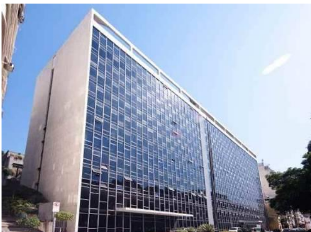
Figura 37 - Edifício Manchete após o retrofit .
