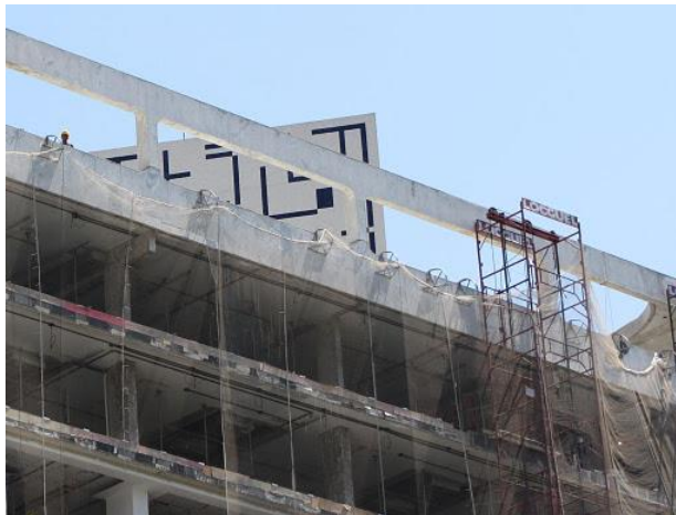
Figura 36 - Edifício Manchete durante o retrofit . Estrutura à mostra.
