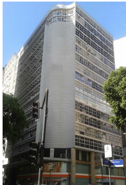
Figura 14 – Edifício Seguradoras//pilotis descaracterizado e brises removidos, Irmãos Roberto.
