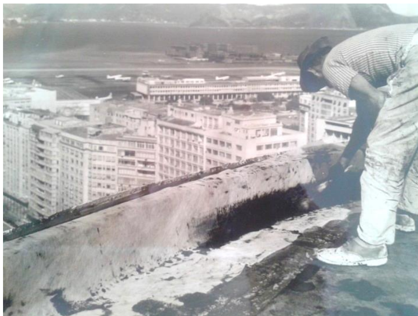
Figura 116 – Execução da impermeabilização da laje do 16º andar de 1963.
