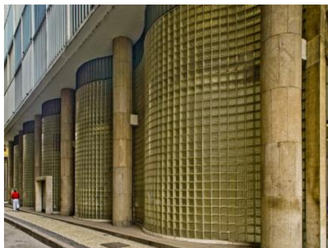
Figura 22 - Edifício sede do Banco Boa Vista/detalhe do fechamento do pilotis, Oscar Niemeyer.
