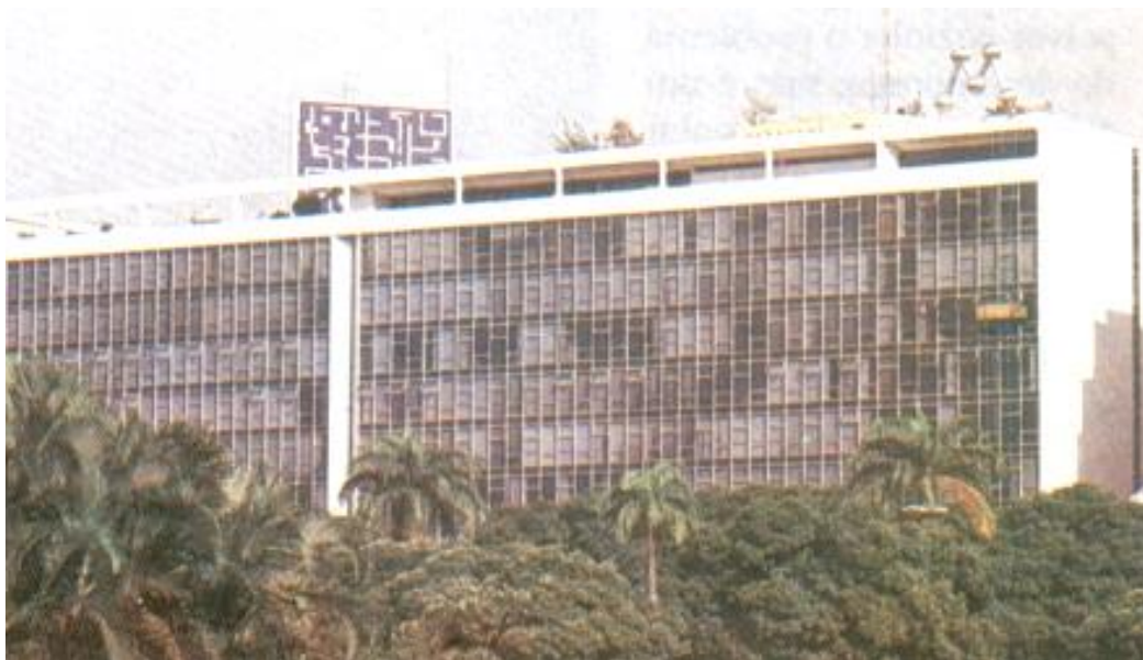
Figura 33 – Edifício Manchete antes do retrofit , Oscar Niemeyer.
