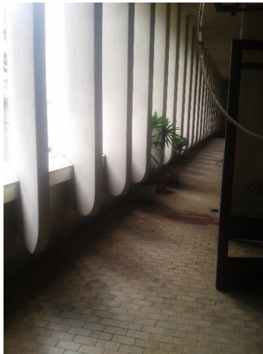
Figura 45 – Imagem do corredor entre os brise-soleils e salas/oitavo pavimento.
