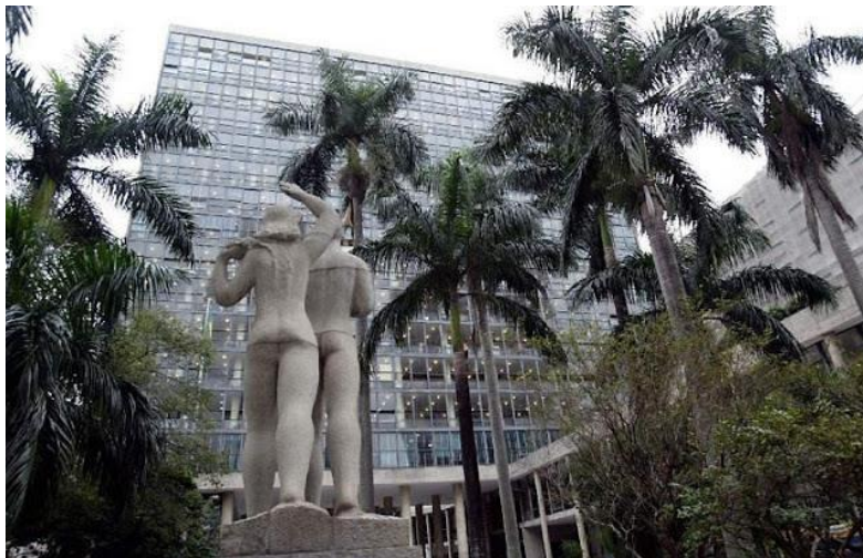
Figura 106 – Vista da fachada sul/sobreposição dos dois volumes.
