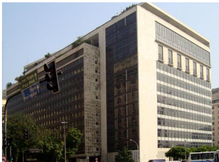
Figura 20 - Edifício Sede do Jockey Clube, Lucio Costa.
