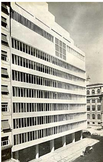
Figura 11 - Fachada do edifício sede da A.B.I.
