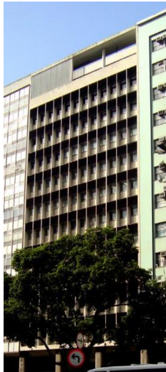
Figura 19 - Edifício Sede do Banco Aliança, Lucio Costa.
