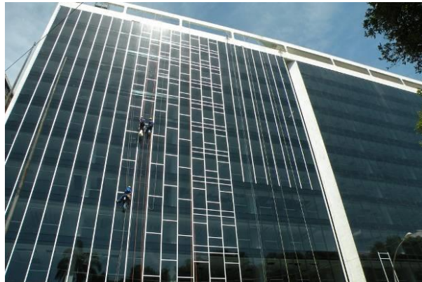
Figura 35 - Edifício Manchete durante o retrofit .
