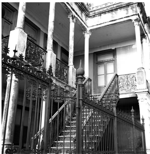
FIGURA 100: Escada de ferro de residência
