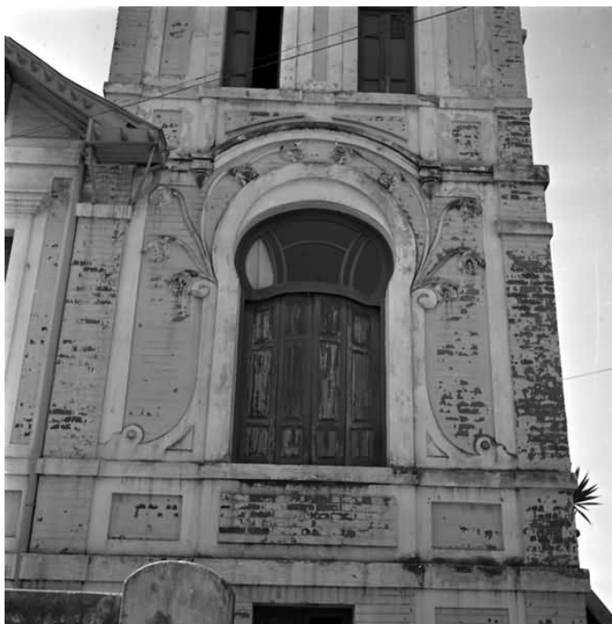
FIGURA 131: Janela de residência na Rua Varginha
