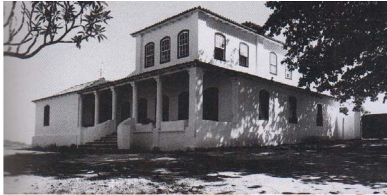
FIGURA 22 – Casa da Fazenda do Engenho d'água [RJ; construção: meados do século XVIII] Fonte: CENTRO DE ARQUITETURA E URBANISMO DO RIO DE JANEIRO, 2000a, p.121.
