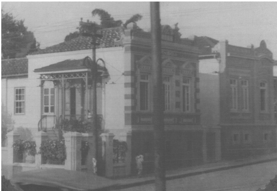
FIGURA 97: [Vista das fachadas lateral e frontal de residência na Rua Gonçalves Dias] Fonte: MENEZES, 1997, p.47.
