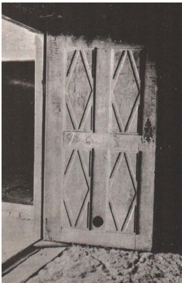
FIGURA 30 – Porta principal da casa de fazenda do Padre Inácio, em Cotia, Estado de São Paulo Fonte: SAIA, 1975, p.232.
