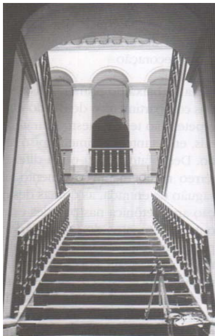
FIGURA 51: [Vista interna da escada da Casa da Marquesa de Santos, Rio de Janeiro (RJ)] Fonte: ROCHA-PEIXOTO, 2000c, p. 312.
