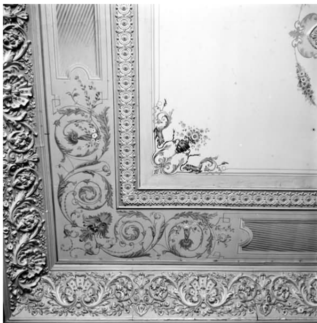
FIGURA 118: [Detalhe do forro de residência na Rua da Bahia] Fonte: LABORATÓRIO DE FOTODOCUMENTAÇÃO SYLVIO DE VASCONCELLOS, [200-]. Nota: A fotografia é de autoria de MAZONNI, Marcos de Carvalho; MAZONNI, Gui Tarcisio, e foi tirada em 1960.
