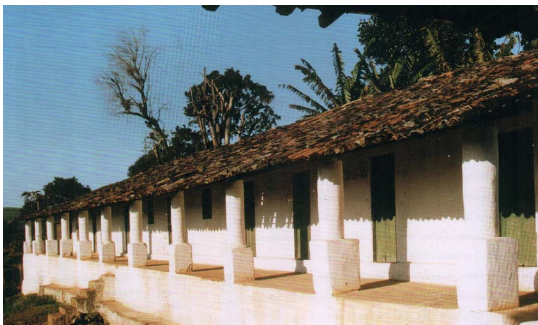
FIGURA 08 – Antiga senzala do engenho Coimbras, Cabo de Santo Agostinho (PE) Fonte: GOMES, 2006, p.102.
