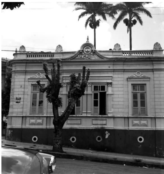
FIGURA 90: [Fachada de residência com elementos diversos na composição da platibanda]
