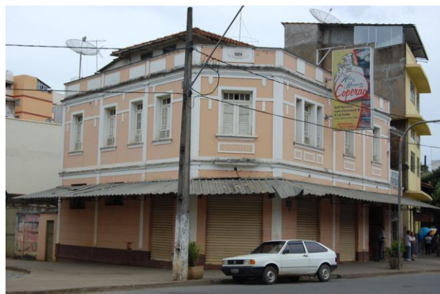
FIGURA 49 – Edificação na Rua Cleto da Rocha, de 1929, vizinha à Estação Ferroviária, não incluída no perímetro de tombamento. Fonte: acervo do autor, 2009.
