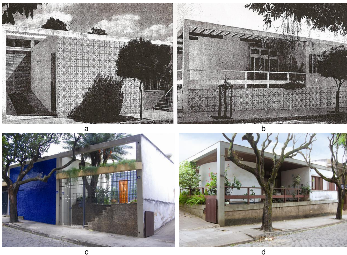
FIGURA 30 – Residências à Rua dos Estudantes com projeto de 1948 do arquiteto Francisco Bolonha e azulejos na fachada de Anísio Medeiros que podem ser vistos nas fotos a e b. As moradias sofreram reformas em 1972 que dentre outras mudanças retiraram os azulejos de Medeiros.
