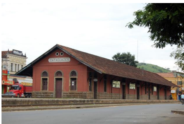
FIGURA 13 – Estação Ferroviária de 1877.
