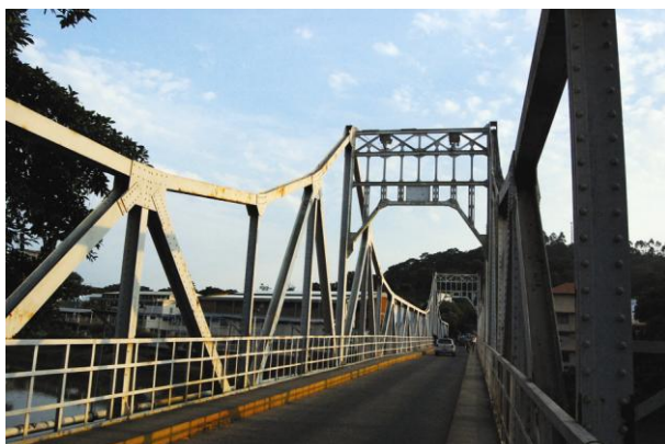
FIGURA 11 – Ponte Metálica sobre o Rio Pomba. Obra de 1915.
