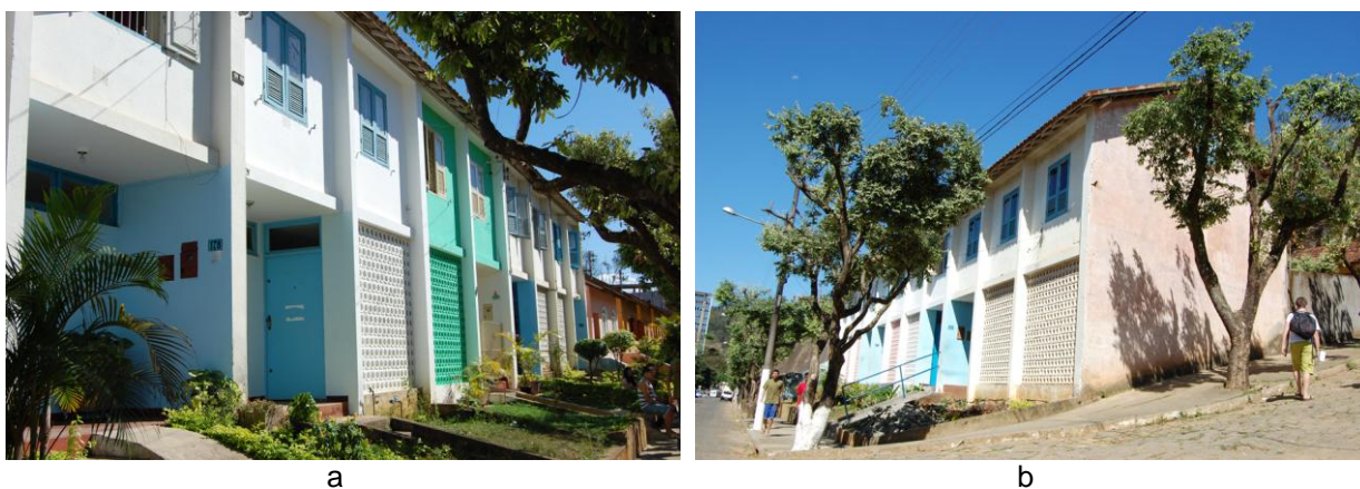
FIGURA 9 – Residências Operárias à rua Francisca de Souza Peixoto, no Bairro Jardim. São dois edifícios cada um com 5 apartamentos dúplex. Projeto da década de 1950 de Francisco Bolonha.
