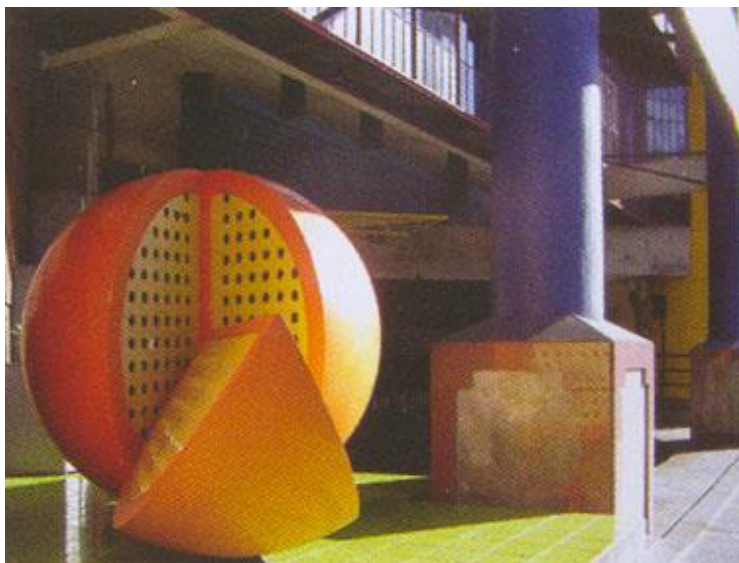
Figura 5.18: Detalhe dos elementos de ventilação dos sanitários públicos masculinos do “Rainha da Sucata”. Fonte: SANTA CECÍLIA, p. 158.
