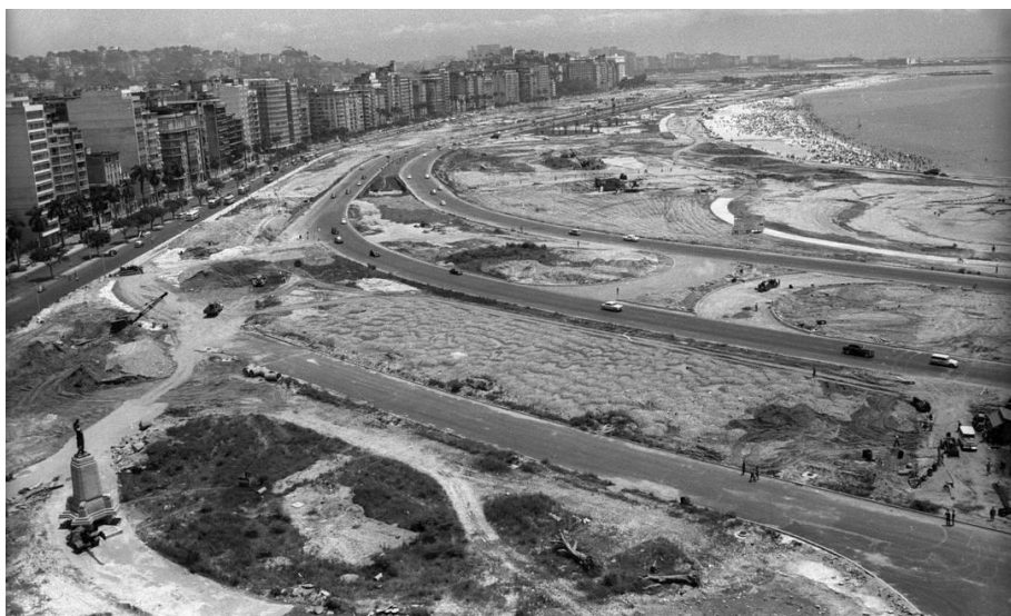
Fig.04 - A Construção do Parque do Flamengo, 1965. Arquivo O Globo/Agência O Globo (autor não identificado).
