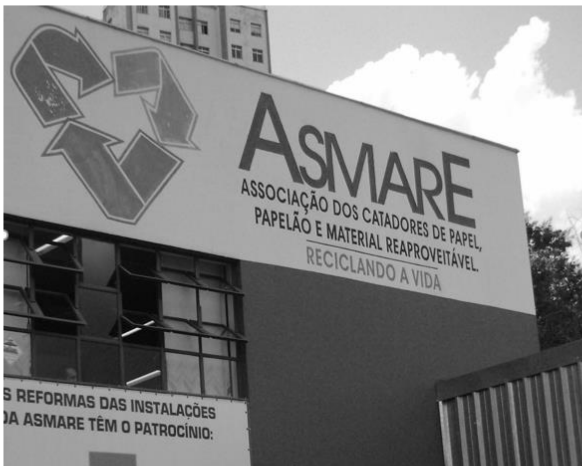
Figura 6: Fachada da ASMARE
