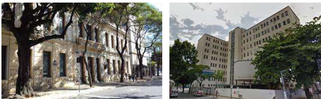
Antiga Escola de Engenharia – Pavilhão Mário Werneck Fonte: Instituições divulgadoras da FMC-PBH
