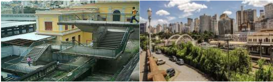
Escadarias da Estação Central – Passeio da Rua Sapucaí Fonte: Instituições divulgadoras da FMC-PBH
