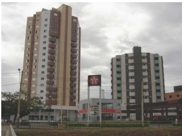
E – Vista externa do Ibituruna Center
