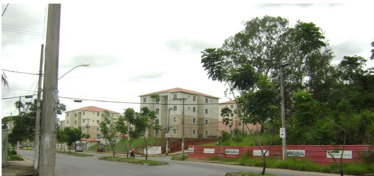
Figura 33: Prédios recém-construídos na área Arb.Core-1b
