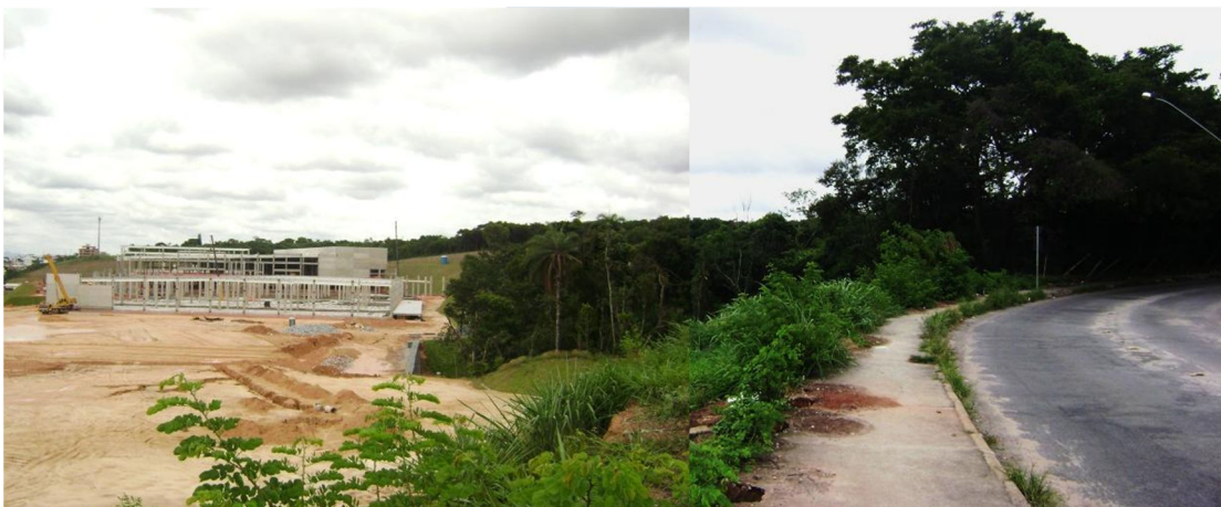
Figura 31: Construção de Shopping Center na área Arb.Core-1a em janeiro de 2013
