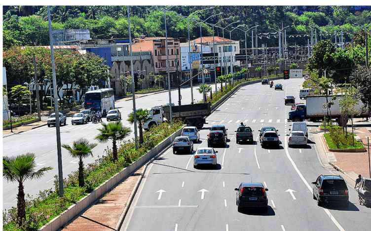
Figura 7: Trecho finalizado do Boulevard Arrudas
