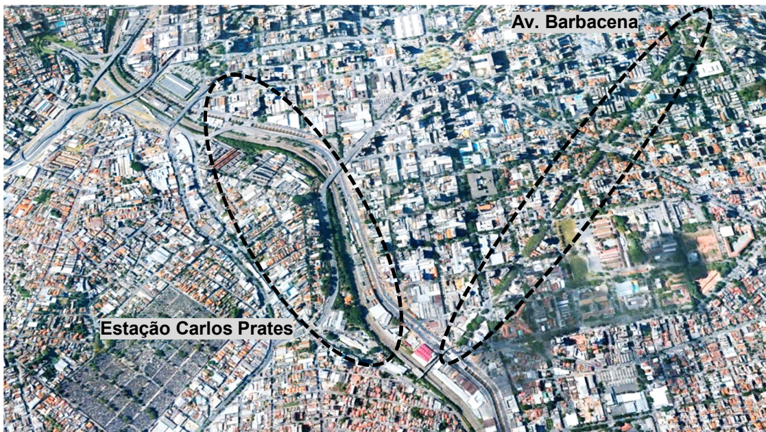
Figura 64: Vegetação Lindeira ao trilho do Metrô – Estação Carlos Prates – e Avenida Barbacena
