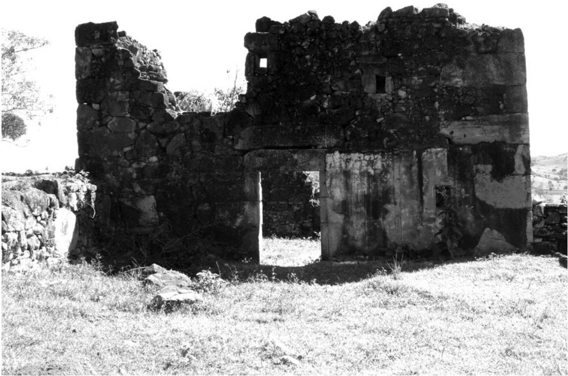
FIGURA 20 Ruína da Fundição clandestina. São Caetano de Moeda, MG. Datada séc. XVIII.
