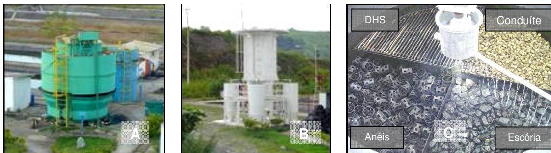
Figura 6.2 - Aparato experimental: Reator UASB (A) e filtros biológicos percoladores (B/C).
