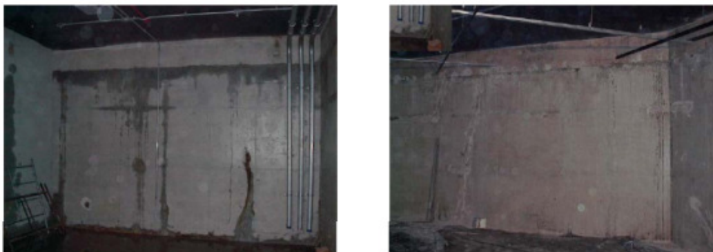
Figura 4.2.2.4 Antes e Depois da Recuperação das fissuras
