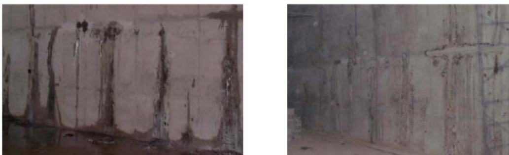
Figura 4.2.2.5 Detalhe de Antes e Depois da Recuperação das fissuras
