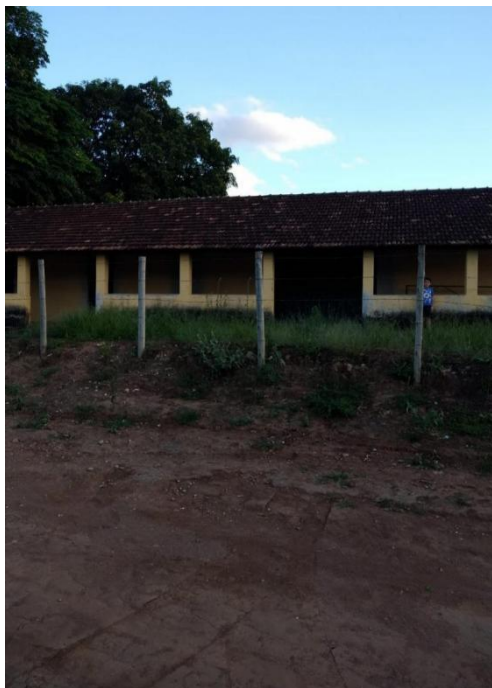
Foto 22 - Fachada de escola, na área rural, abandonada por falta de alunos Fonte: dos arquivos da autora
