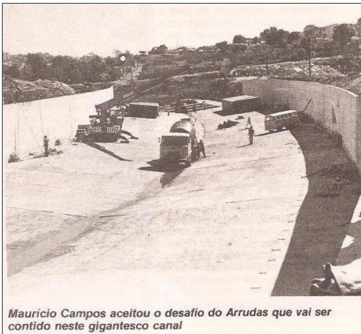
Figura 36: Fotografia da Revista História de Belo Horizonte, de 1981, elogiando a iniciativa do então prefeito de desafiar a força do Arrudas em uma obra grandiosa. Revista História de Belo Horizonte – 1981
