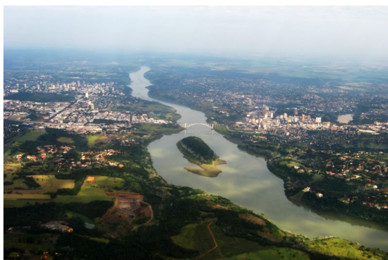
Foto 1: Ponte da Amizade construída sobre o Rio Paraná
