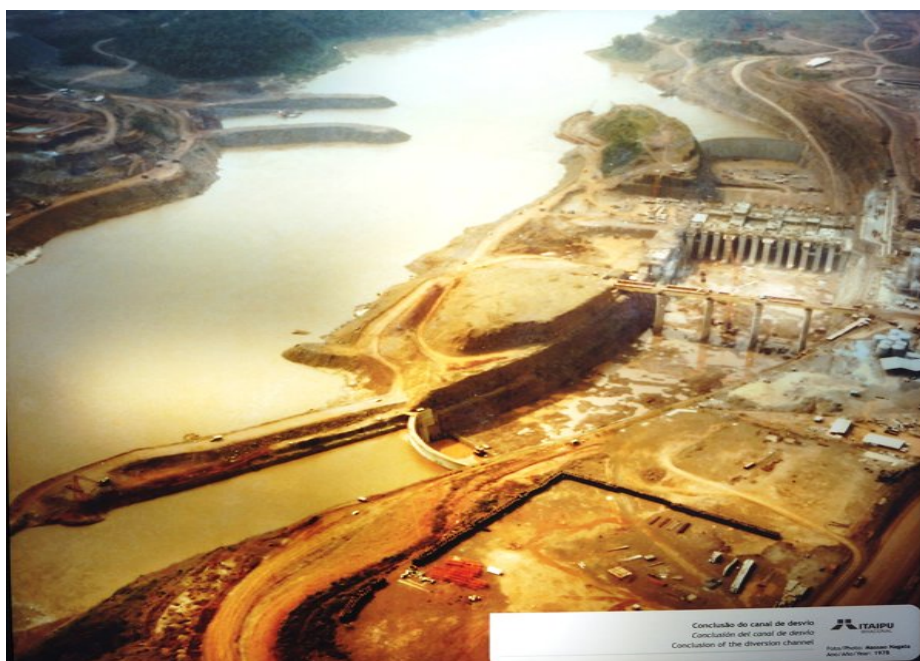
Foto 3: Obras de desvio do Rio Paraná durante construção da hidrelétrica de Itaipu
