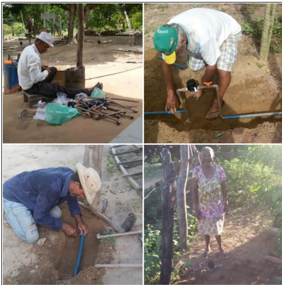
Figura 33 - Instalação dos hidrômetros na comunidade de Lagedo. Foto: O autor
