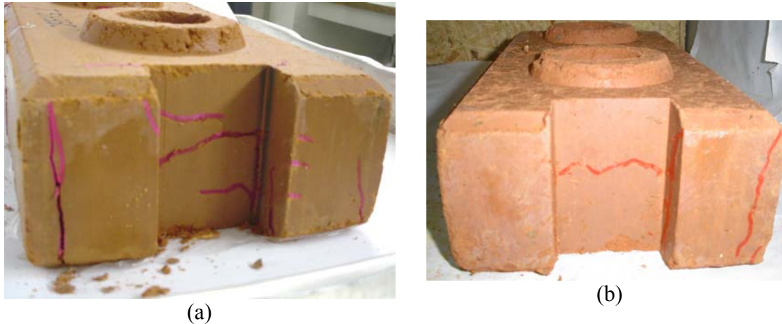
FIGURA 46 – Ruptura no tijolo – solo Homog. 03 (a) 0% resíduos (b) % resíduos
