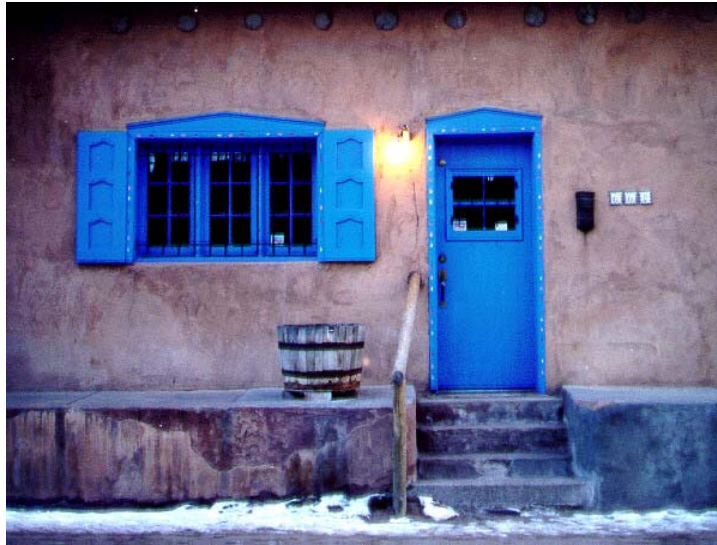
FIGURA 3 – Casas feitas de argila ou adobe na província de Santa Fé - Argentina
