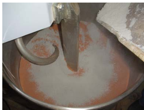
(d) Adição de cimento no misturador de argamassa
