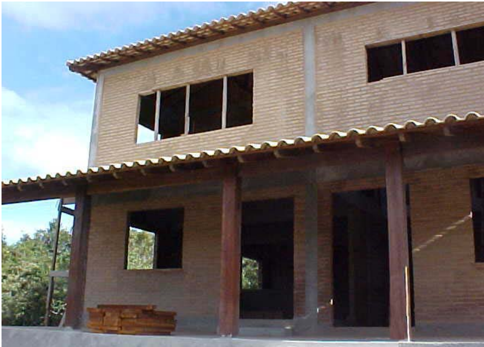
FIGURA 7 – Residência em construção na região metropolitana de Belo Horizonte – MG onde são utilizados tijolos de solo-cimento.
