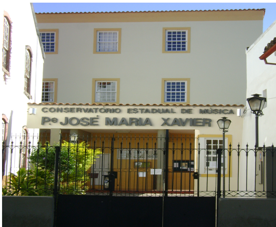
FIGURA 7 – Atual prédio do Conservatório de São João del Rei, localizado na Rua Padre José Maria Xavier, nº 164, no centro da cidade. Acervo do Conservatório Estadual de Música
