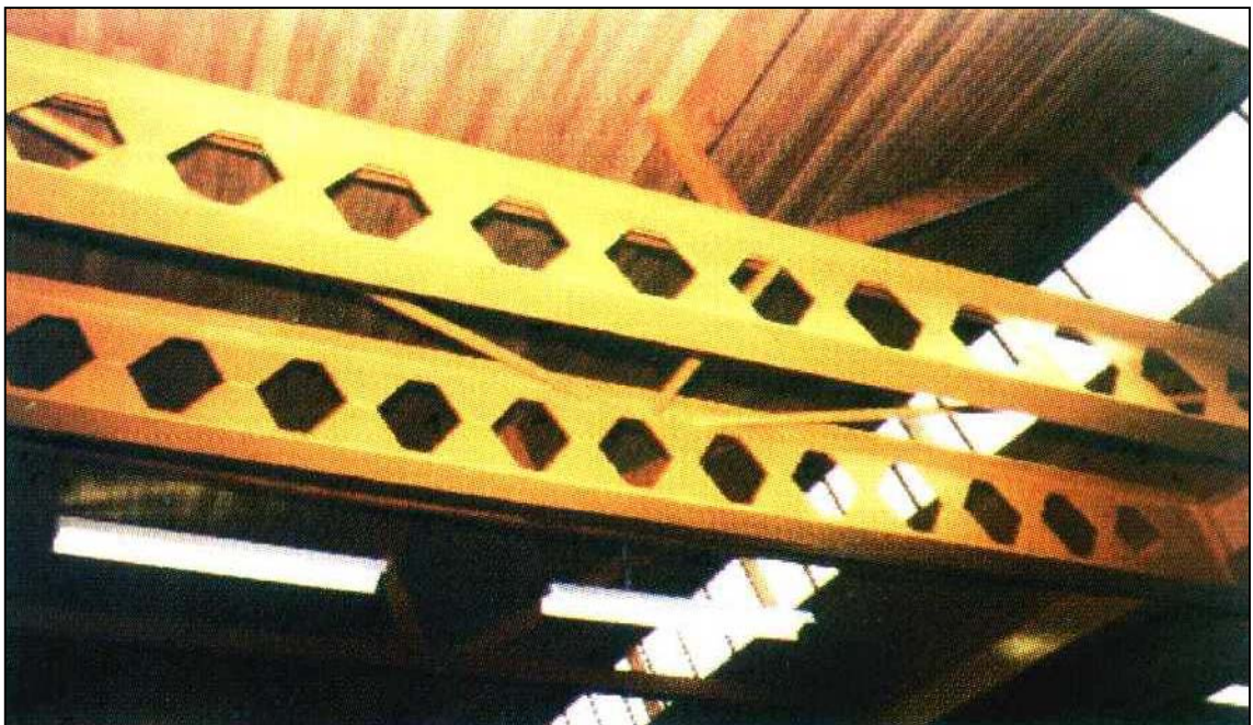
Figura 3.7 - Estrutura metálica protegida com tinta intumescente.
