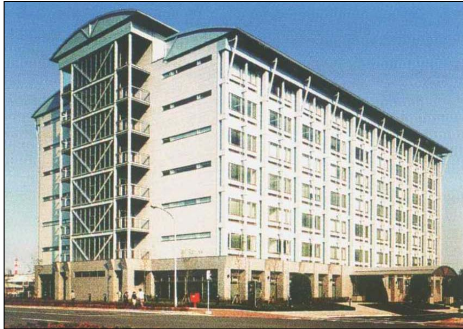
Figura 6.12 – Edifício Tobihata construído em aço resistente ao fogo. (SCHLEICH et al, 1993).
