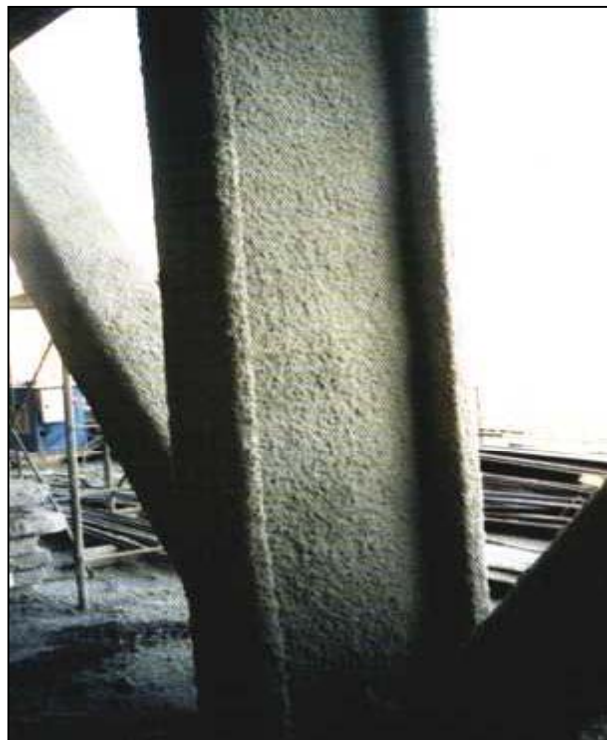
Figura 3.5 – Pilar metálico protegido com uma argamassa a base de cimento e fibras minerais.
