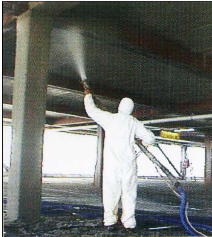
Figura 3.4 – Aplicação de uma argamassa a base de cimento e fibras minerais.
