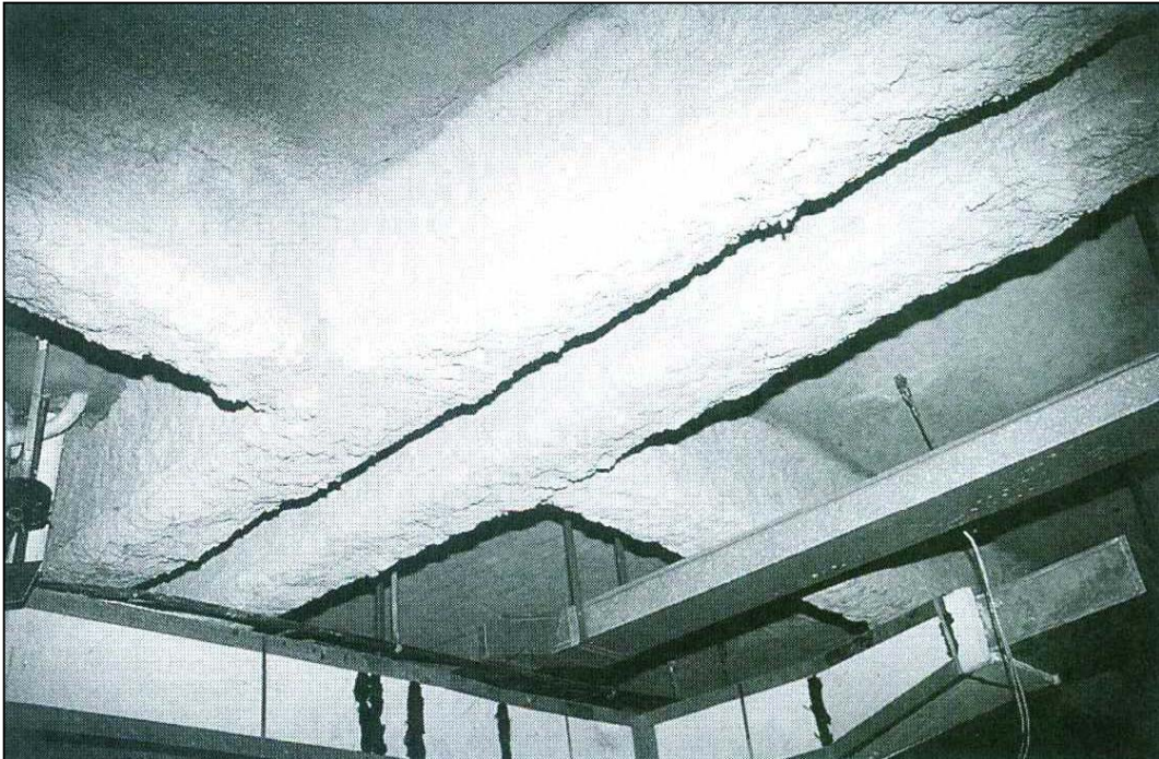
Figura 3.10- Vigas de aço revestidas com argamassa de vermiculita, por meio de “spray”.
