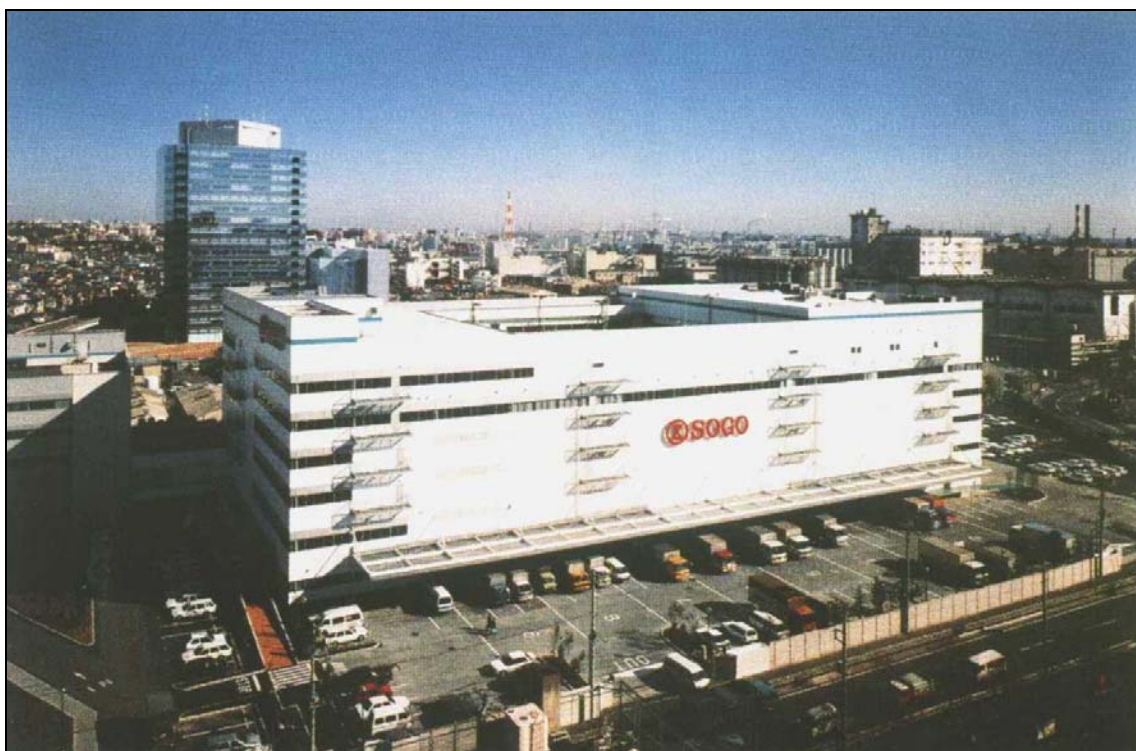
Figura 6.14 – Depósito Yokohama Sogo construído em aço resistente ao fogo (SCHLEICH et al, 1993).
