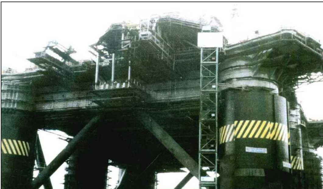
Figura 3.11 – Aplicação de argamassa de vermiculita na plataforma P-19 da PETROBRAS.
